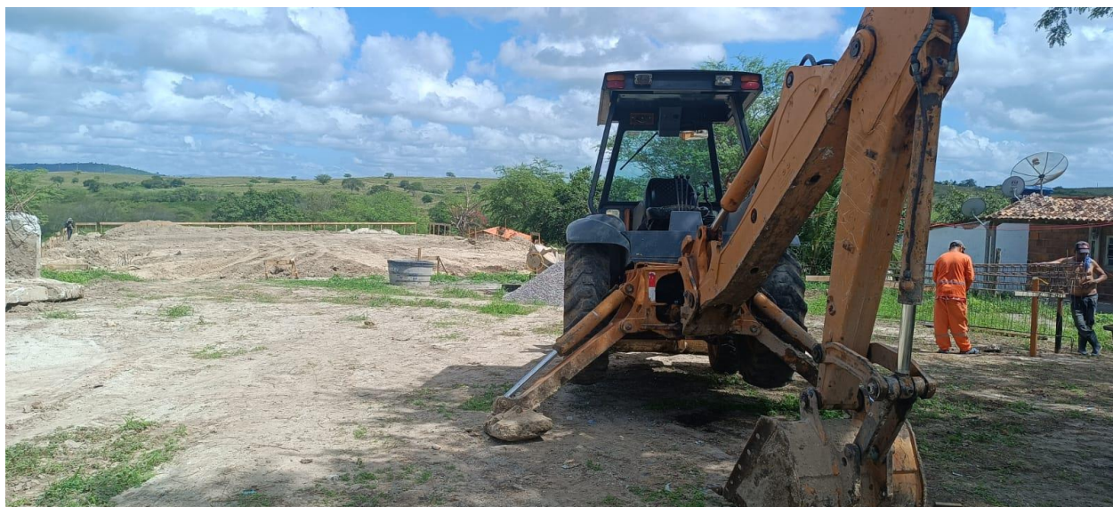
Figura 9: Aterro da Quadra.
