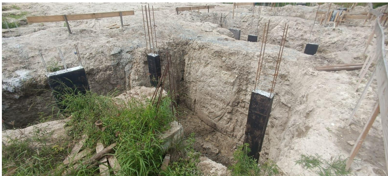
Figura 4: Pescoços de Pilar.
