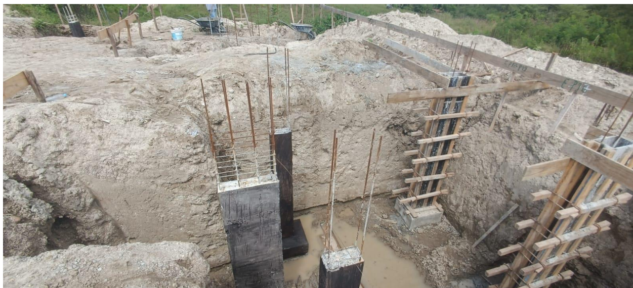
Figura 3: Pescoços de Pilar.
