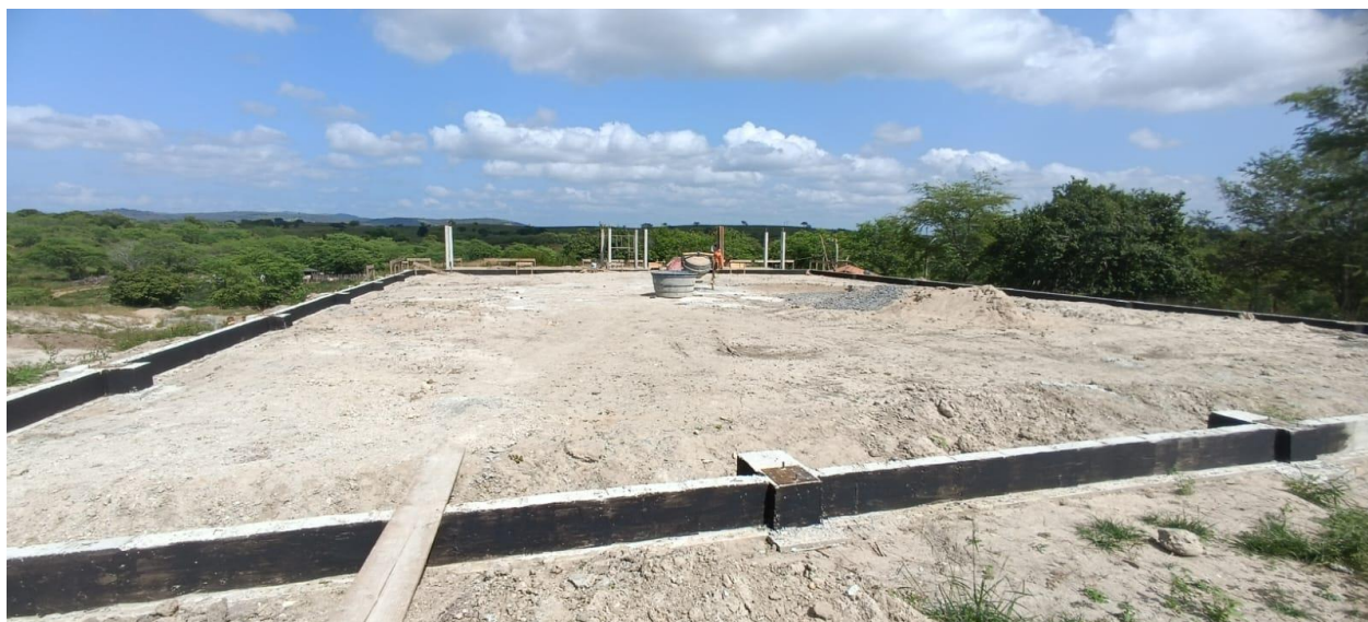
Figura 6: Aterro da quadra
