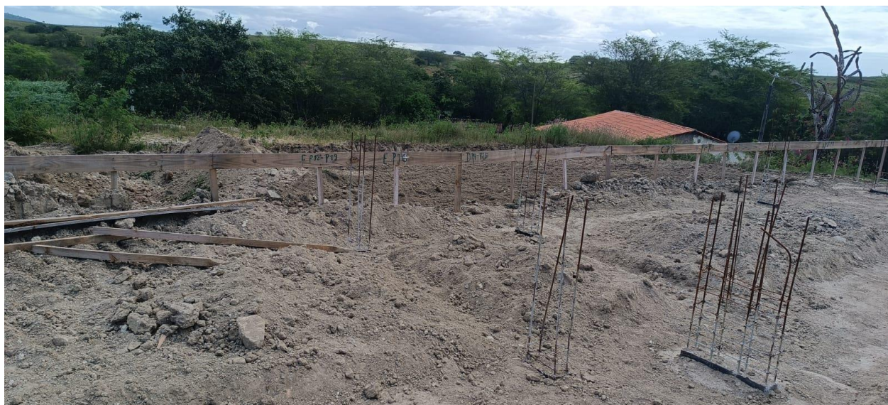
Figura 5: Reaterro dos pescoços de pilar.
