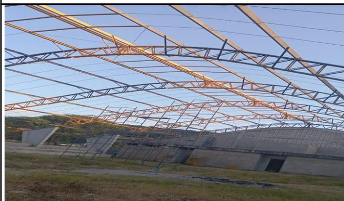
FOTO 03: Recuperação e pintura da estrutura metálica
