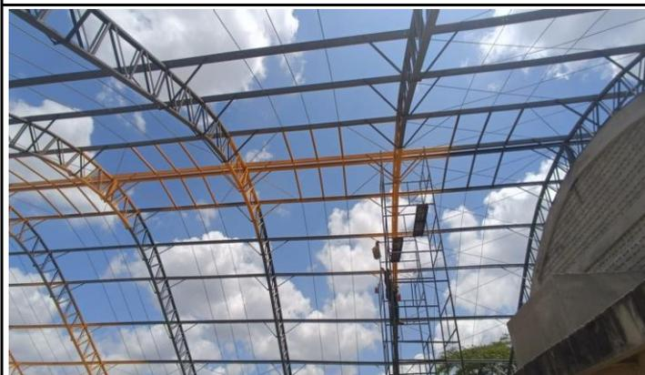
FOTO 01: Recuperação e pintura da estrutura metálica
