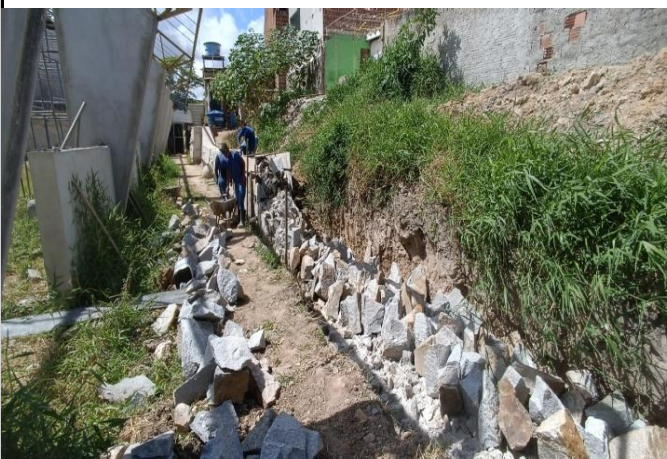
FOTO 03: Base do Muro de Arrimo
