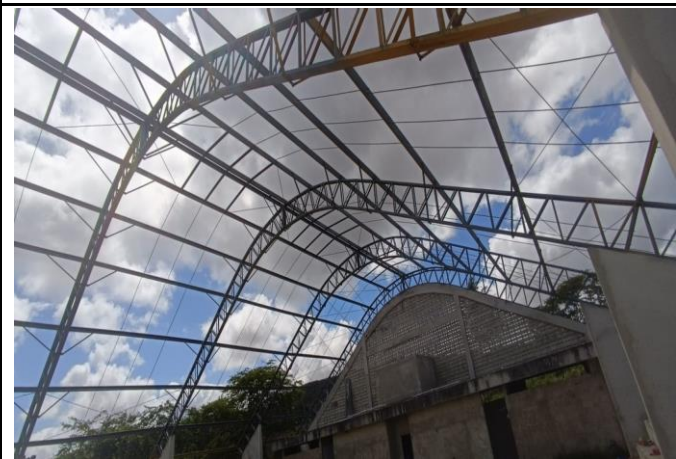
FOTO 06: Recuperação da estrutura de coberta
