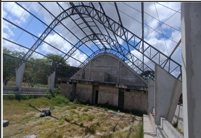
FOTO 05: Recuperação da estrutura de coberta
