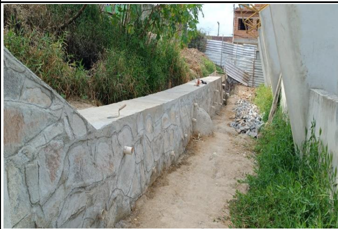
FOTO 02: Muro de Arrimo
