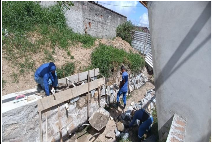
FOTO 04: finalização do muro de arrimo
