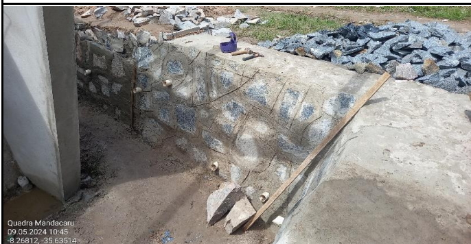
FOTO 03: Muro de contenção.
