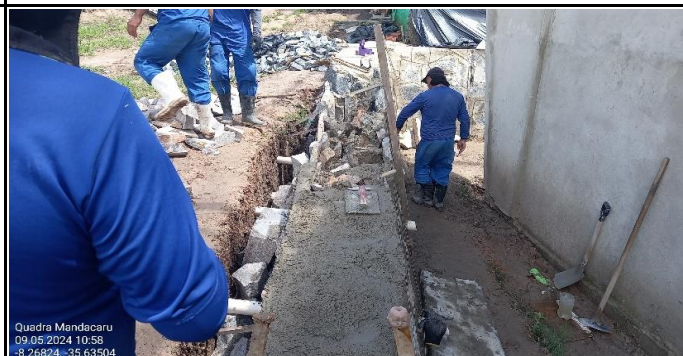
FOTO 04: Muro de contenção.
