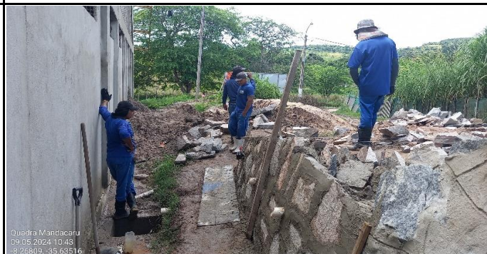
FOTO 02: Muro de contenção.
