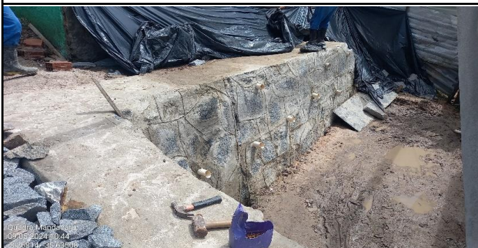
FOTO 01: Muro de contenção.
