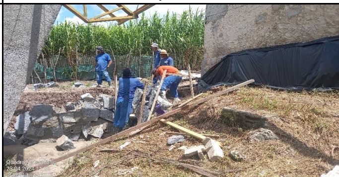
FOTO 06: Muro de contenção.
