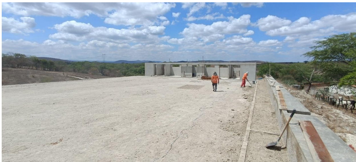
Figura 2: Concretagem da arquibancada
