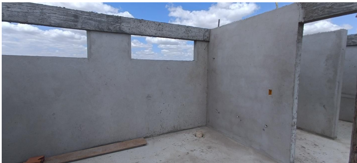
Figura 5: Emboço e Hidraulica da parte interna dos vestiários
