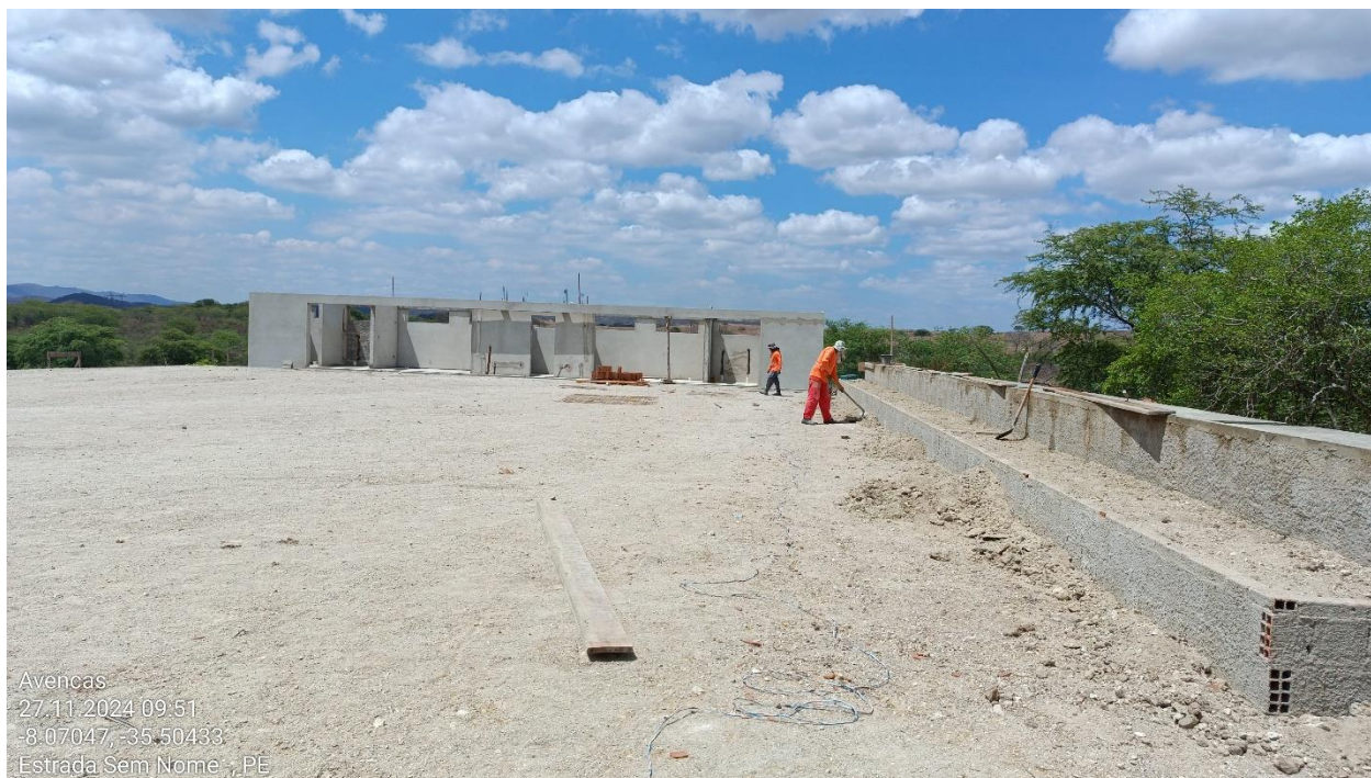
Figura 1: Alvenaria e aterro da arquibancada
