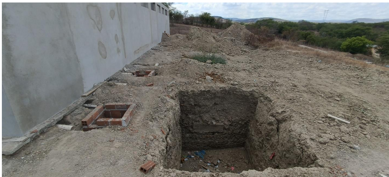
Figura 7: Caixas de passagem e emboço externo
