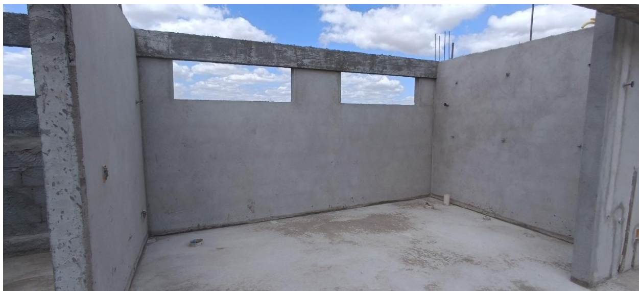
Figura 4: emboço da parte interna dos vestiários
