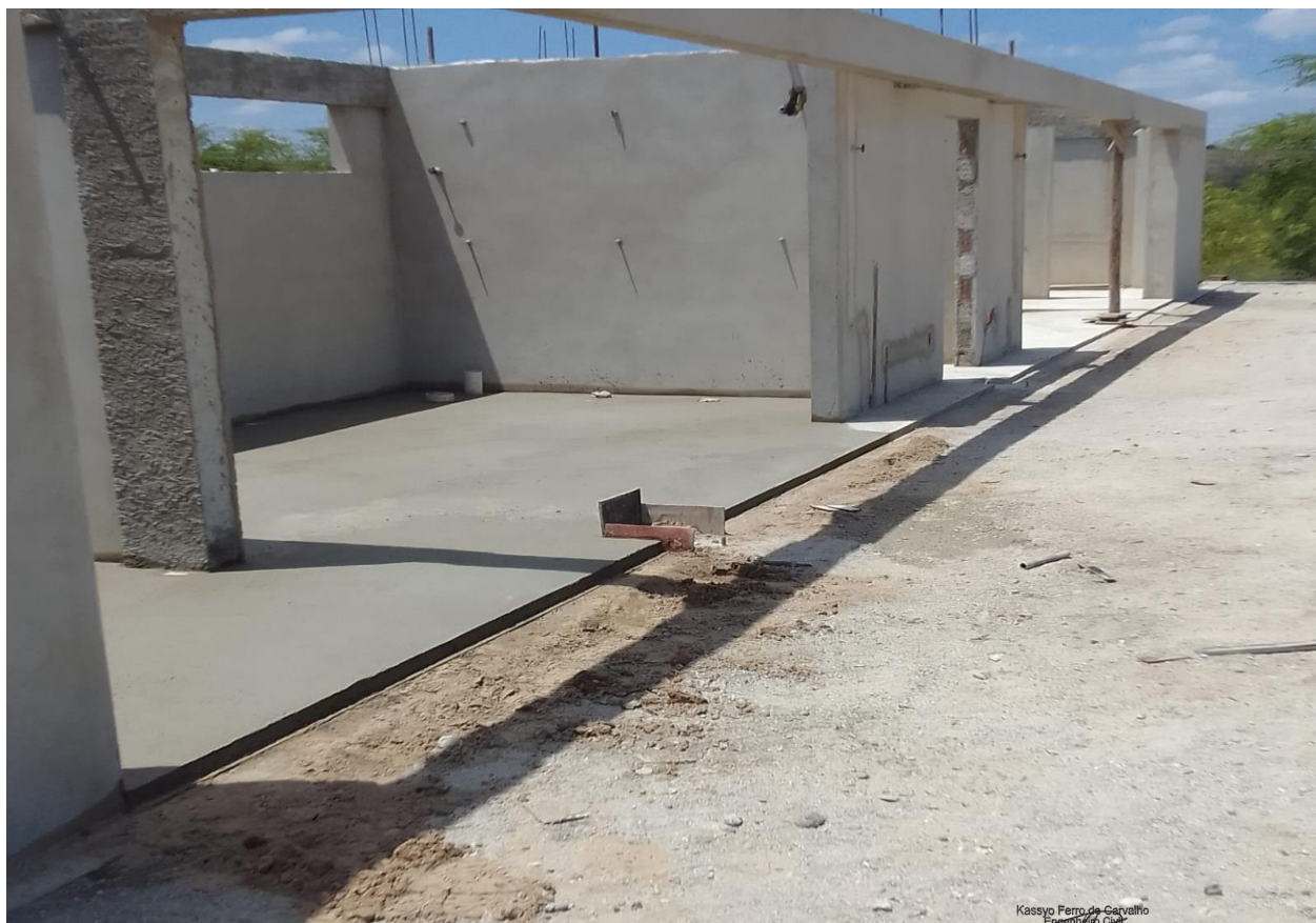
Figura 6: Contra piso dos vestiários e registros hidraulicos
