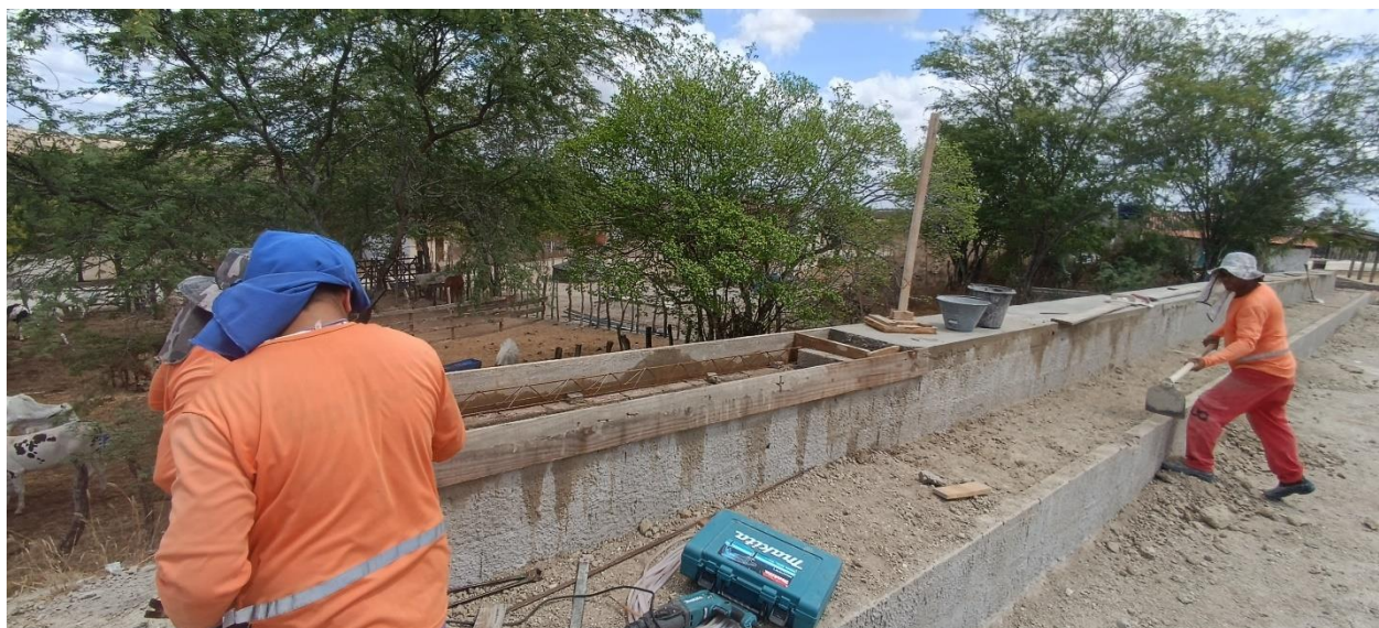
Figura 3: forma para concretagem da arquibancada
