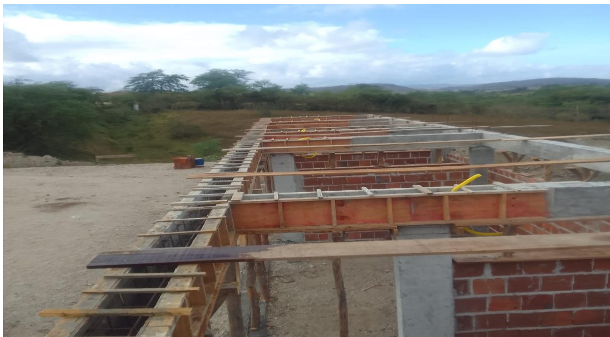
Figura 11: Forma das vigas
