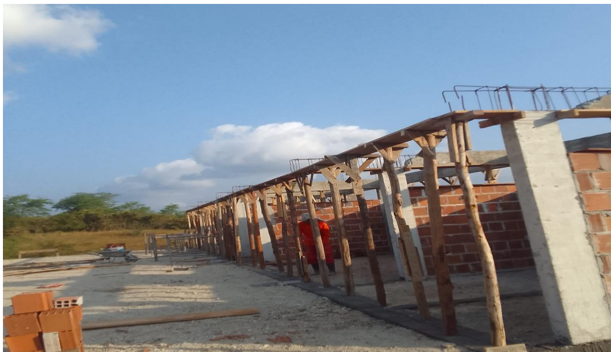
Figura 3: nivelamento dos fundos de viga frontal
