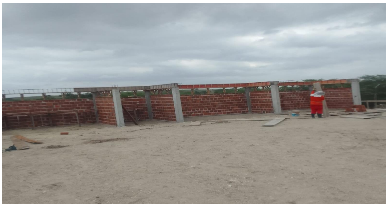
Figura 8: Alvenaria do vestiário
