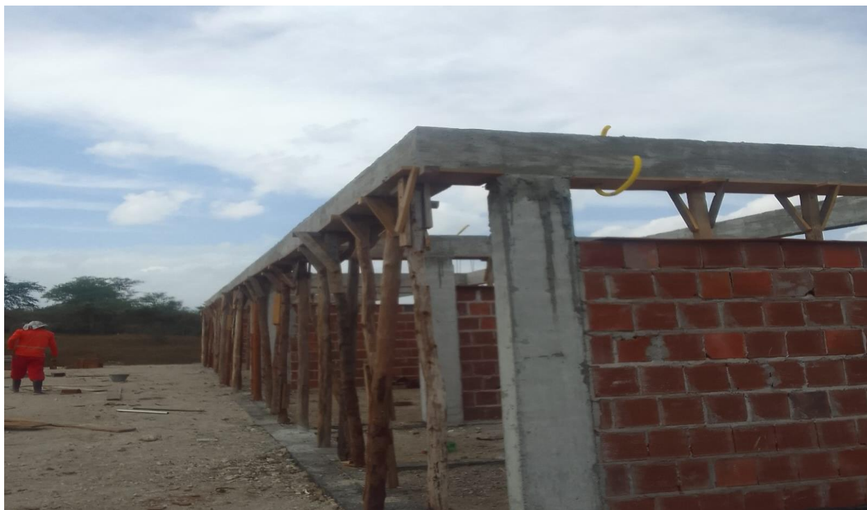
Figura 5: Viga frontal concretada
