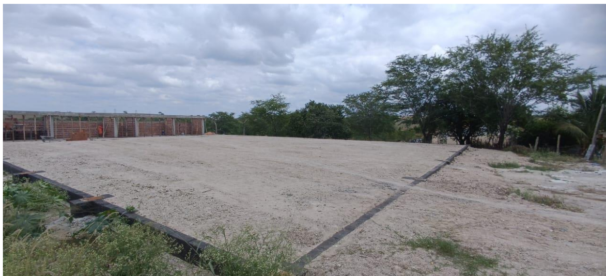
Figura 12: Impermeabilização das vigas baldrame
