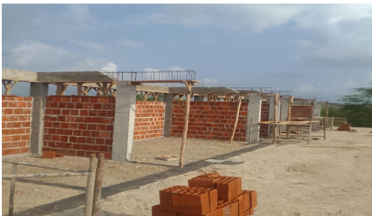
Figura 4: vigas do vestiário
