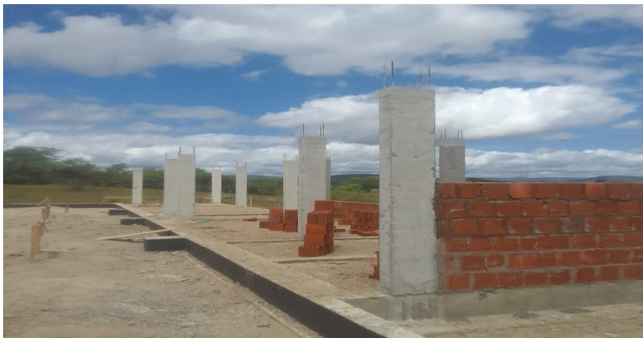
Figura 10: Alvenaria do vestiário
