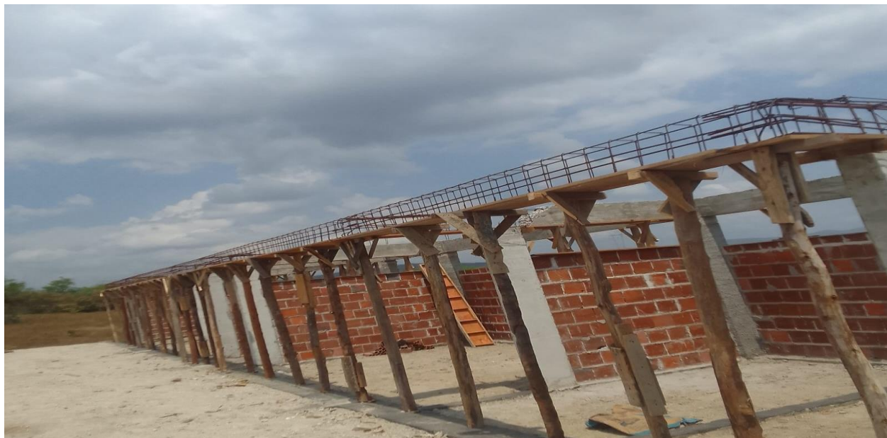
Figura 1: Armação das viga frontal do vestiário
