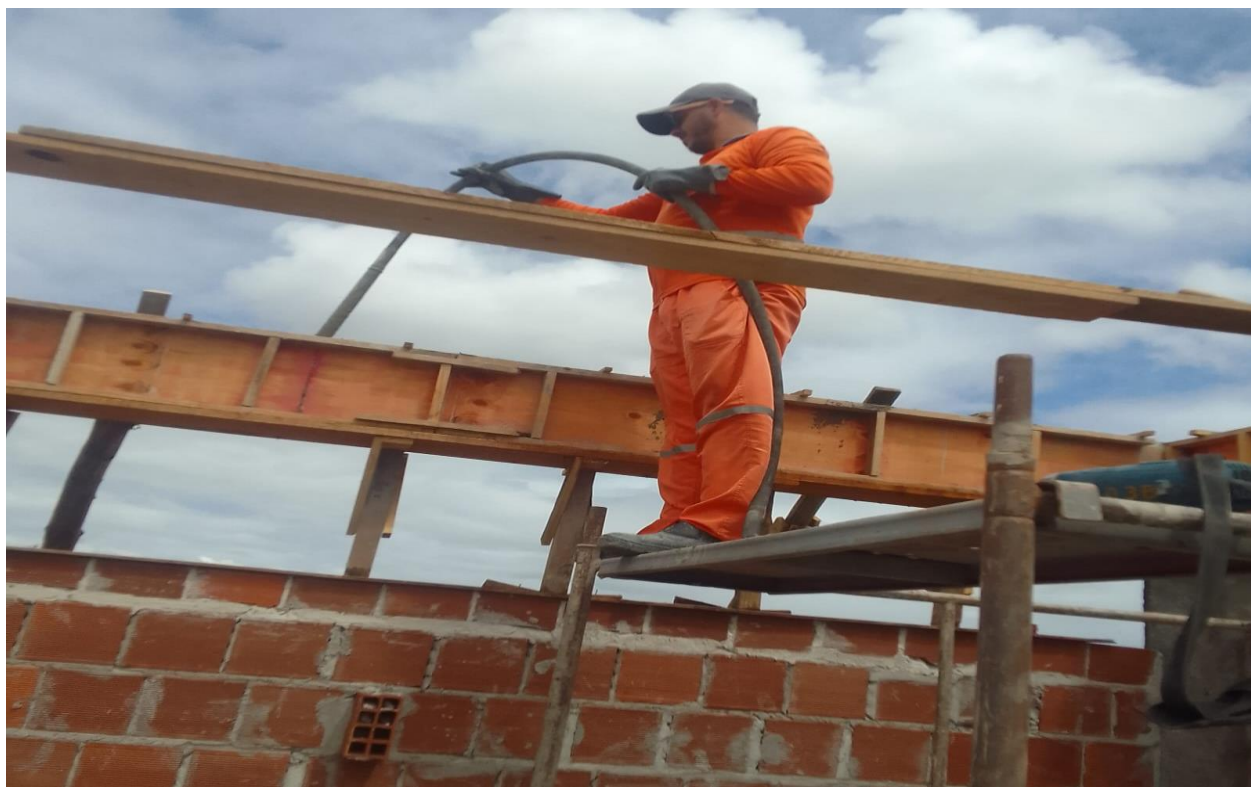
Figura 9: Concretagem das vigas do vestiário
