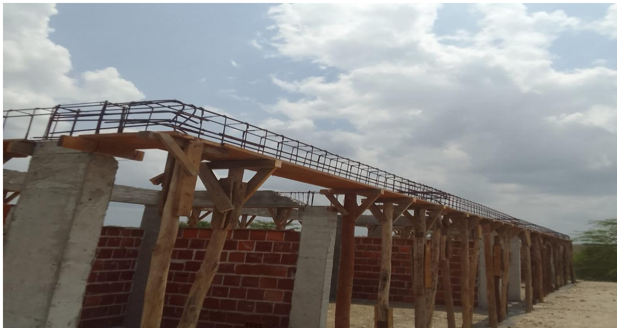
Figura 2: Armação da viga frontal do vestiário
