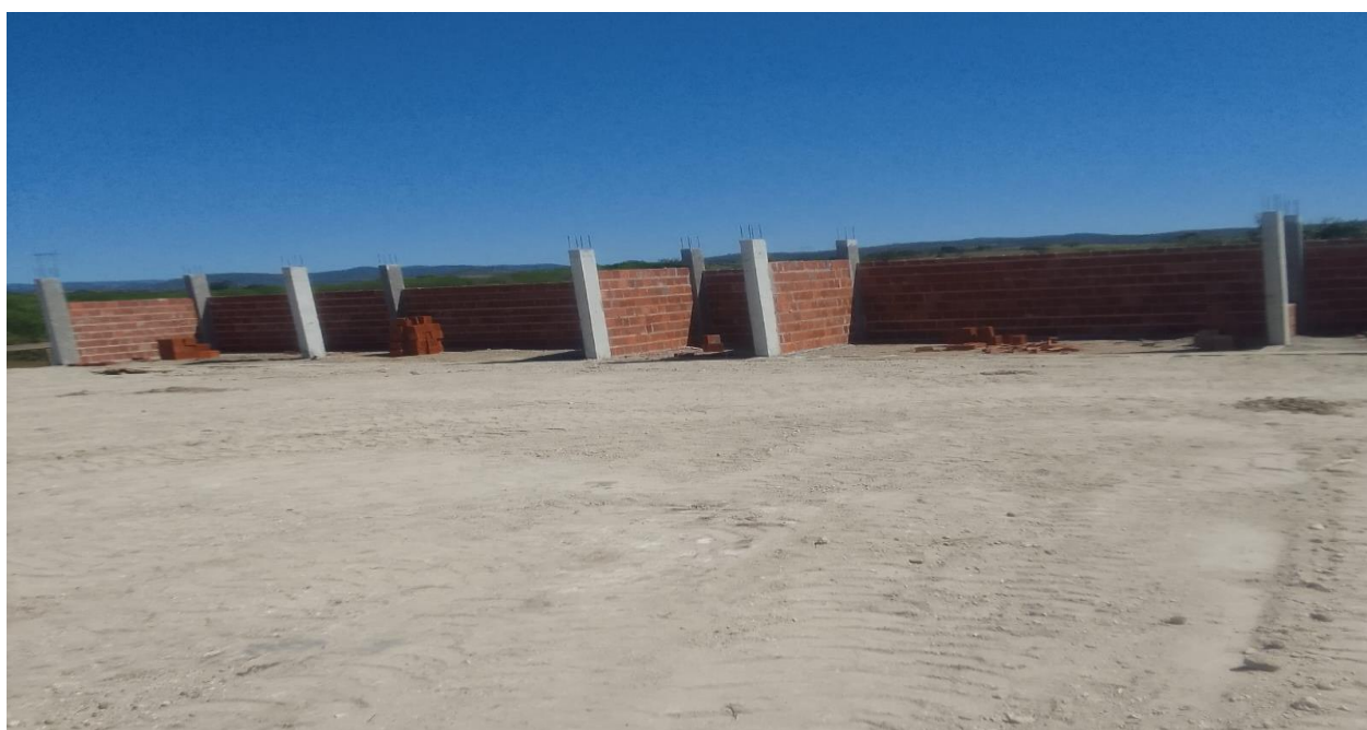
Figura 6: Alvenaria do vestiário
