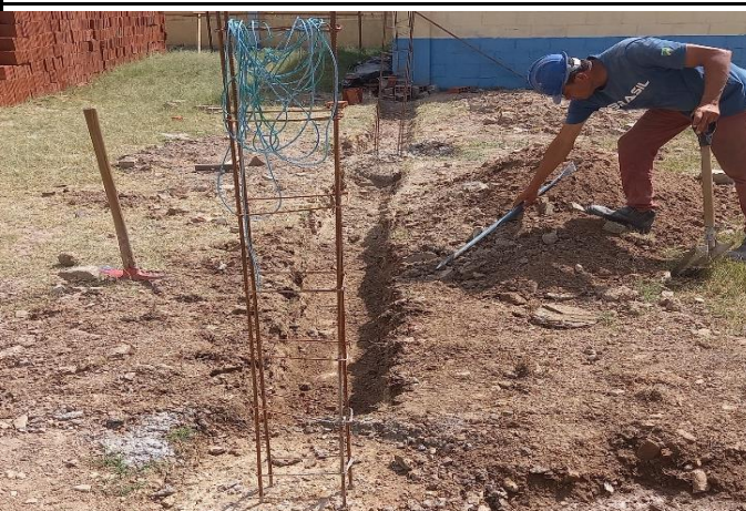
FOTO 04: Ferragem dos pilares das salas nova.
