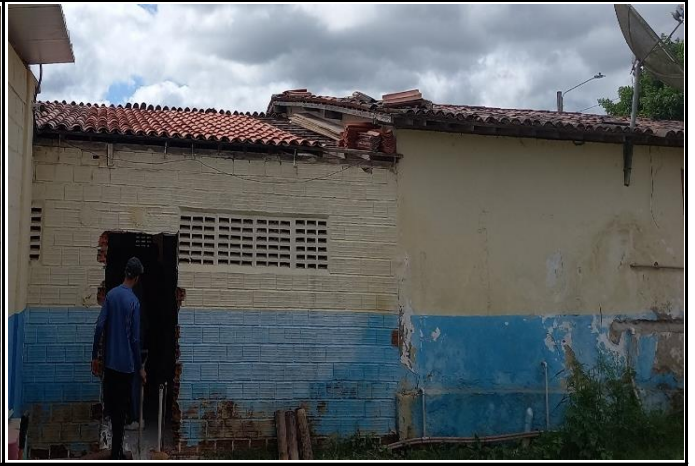
FOTO 08: Revisão de cobertura de toda escola.
