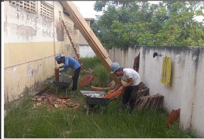
FOTO 09: Revisão de cobertura de toda escola.
