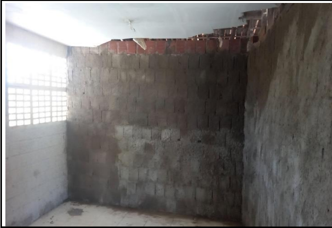
FOTO 07: Chapisco na alvenaria de vedação.
