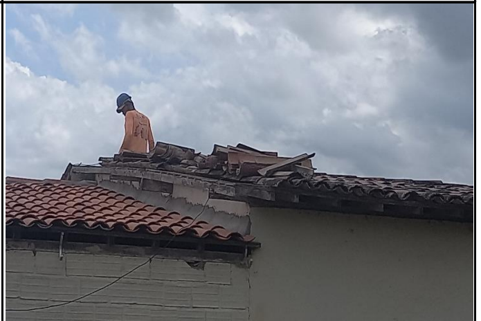
FOTO 10: Revisão de cobertura de toda escola.
