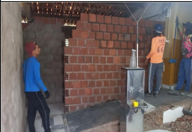
FOTO 06: Alvenaria de vedação sala aee.
