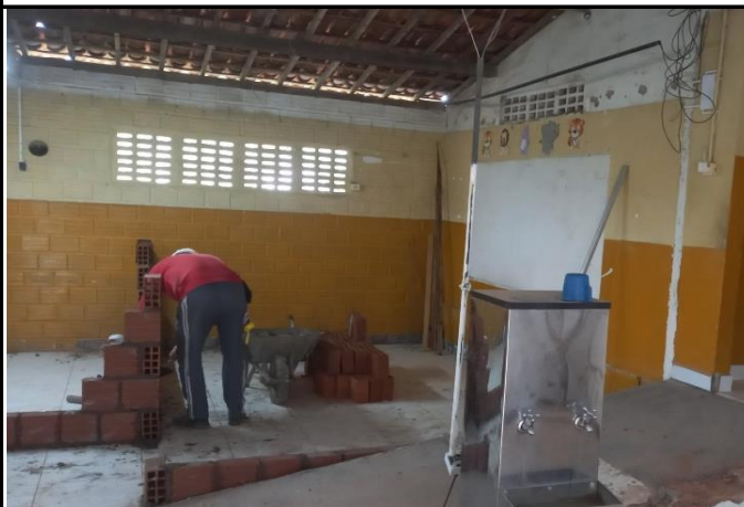
FOTO 02: Demolição de forro da antiga sala de aula.
