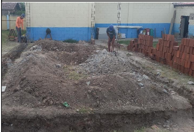
FOTO 03: Escavação para fundação das salas novas.
