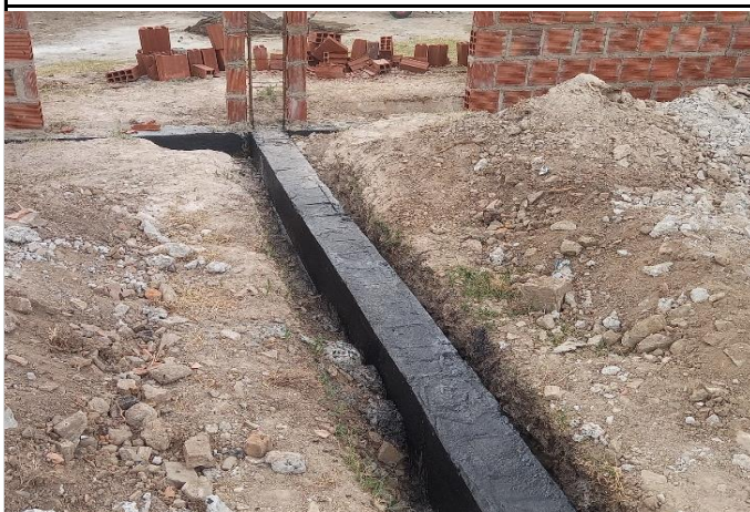
FOTO 05: Impermeabilização da base das salas novas.
