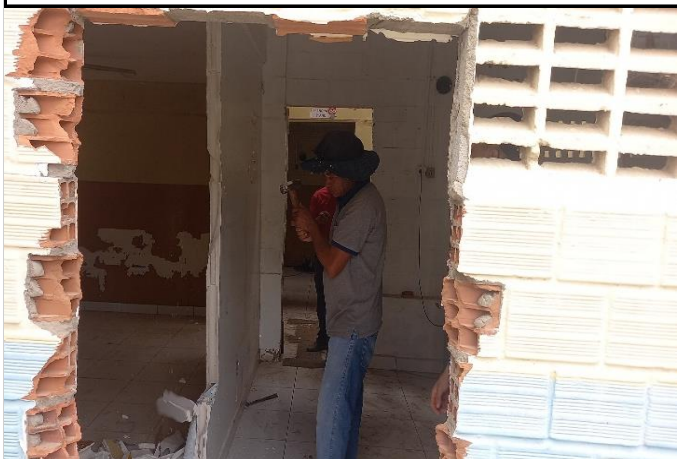
FOTO 01: Demolição de alvenaria.
