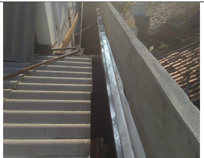
Execução de massa única
