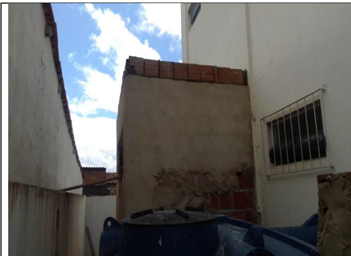
Execução da massa única
