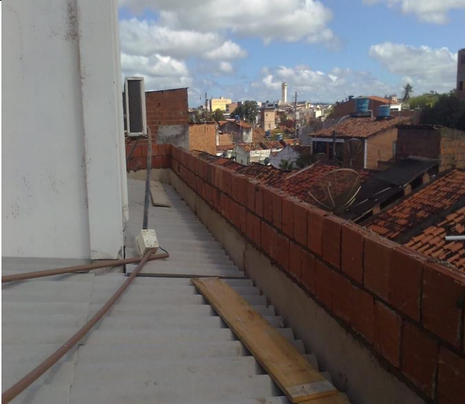
Execução da alvenaria
