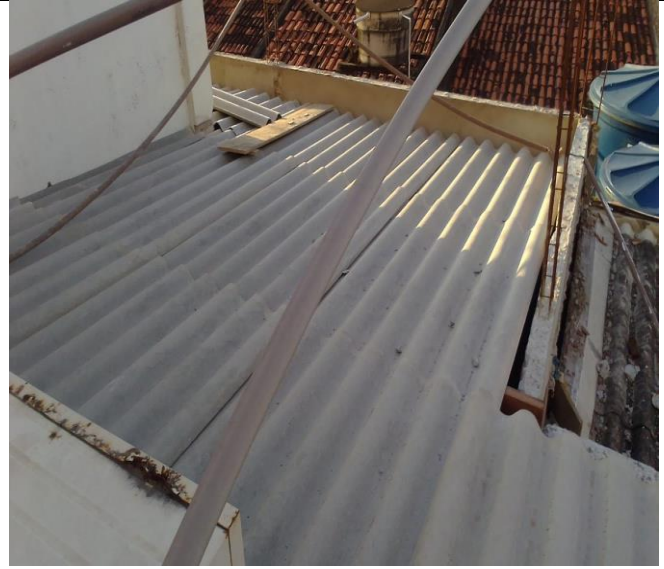
Execução de cobertura
