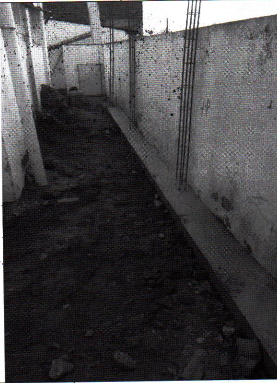
Execução da fundação
