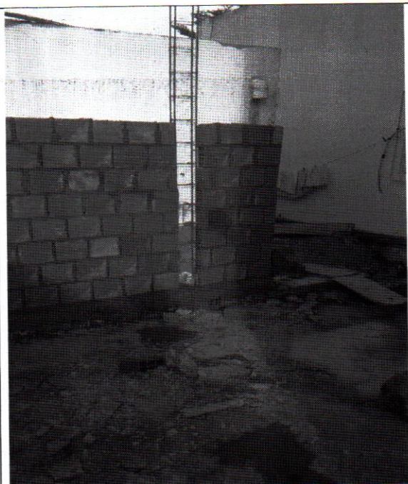
Execução alvenaria e estrutura
