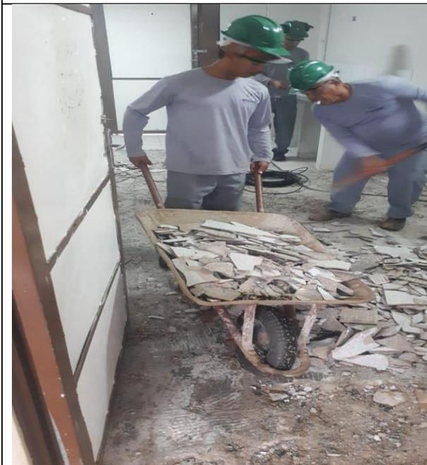
FOTO 03: REMOÇÃO DE PISO CERÂMICO.
