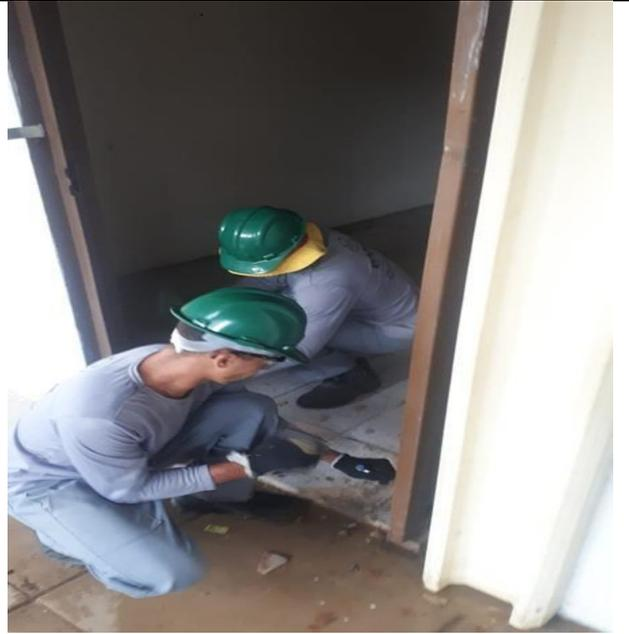
FOTO 02: REMOÇÃO DE PISO CERÂMICO.
