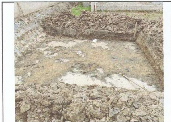
IMAGEM 09: Escavação da base do castelo d'água
