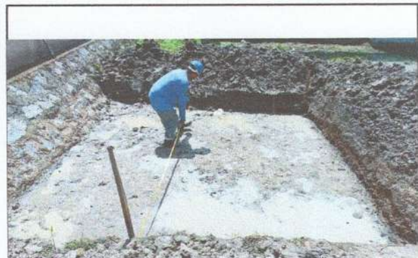
IMAGEM 10: Escavação da base do castelo d'água
