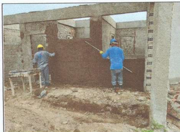
IMAGEM 14: Reboco em paredes
