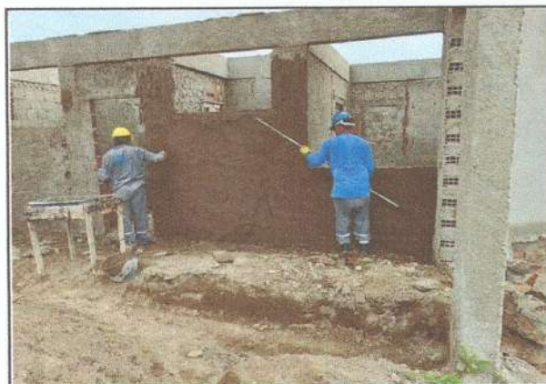
IMAGEM 11: Reboco em paredes
