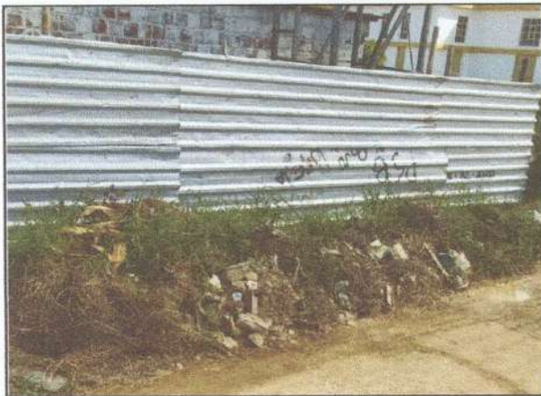
IMAGEM 07: Tapume em telha metálica
