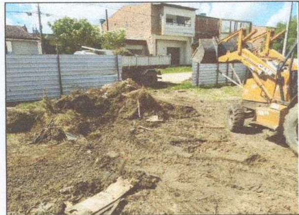
IMAGEM 08: Tapume em telha metálica e limpeza
