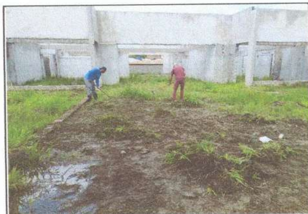
IMAGEM 17: Limpeza e capinação da obra
