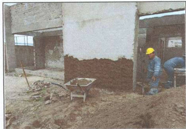
IMAGEM 12: Reboco em paredes
