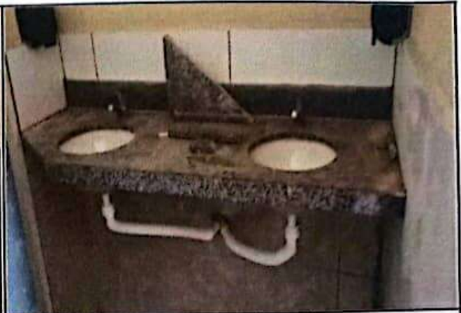
FOTO 08: Lavatorio com bancada de granito.
