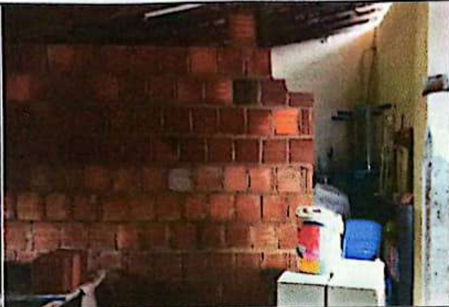
FOTO 01: Alvenaria de vedação da sala de computação.
