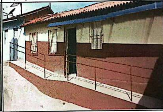
FOTO 04: Guarda corpo na rampa de acesso.
