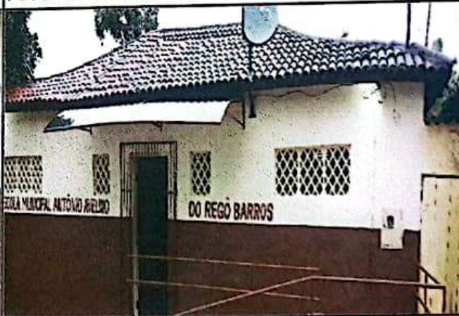
FOTO 12: Revisão de coberta de toda escola.
