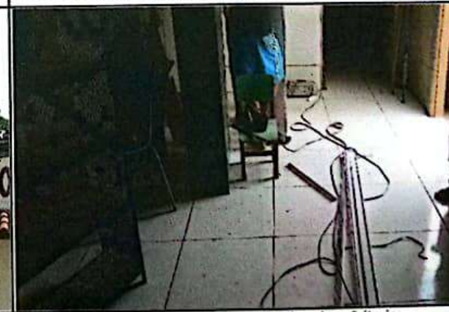
FOTO 06: Revestimento cerâmico do piso do refeitório.
