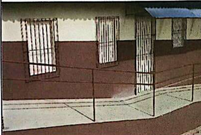
FOTO 09: Grades de proteção da porta e janelas.
