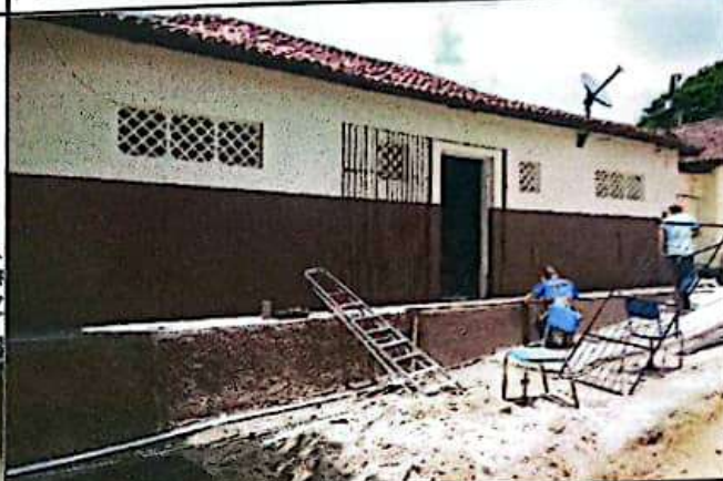
FOTO 10: Pintura manual em tinta látex de toda escola.
