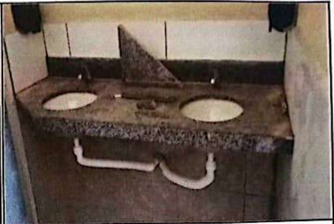
FOTO 08: Lavatorio com bancada de granito.
