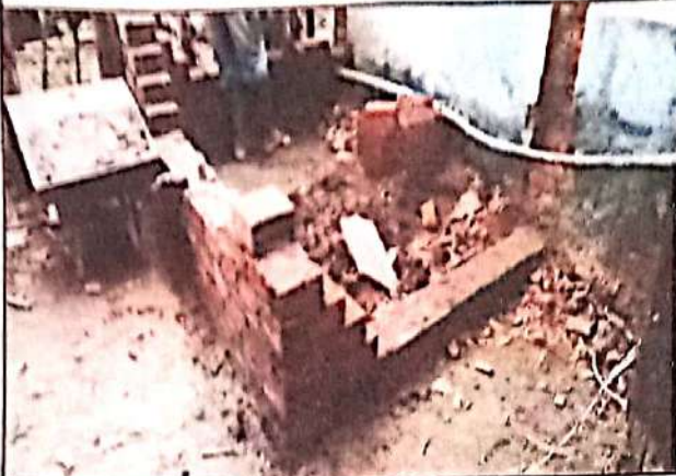
FOTO 01: Alvenaria de embassamento do PNE.
