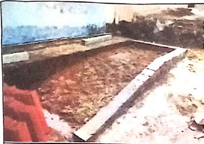
FOTO 07: Alvenaria de embassamento da rampa de acesso.
