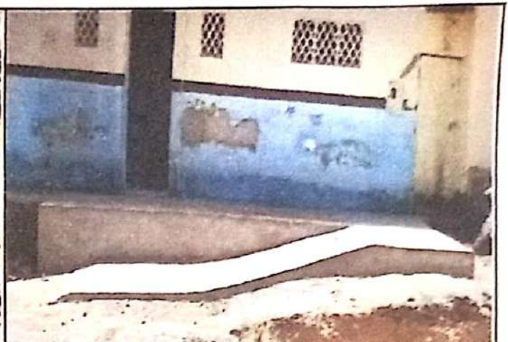
FOTO 08: Execução de passeio na rampa de acesso .
