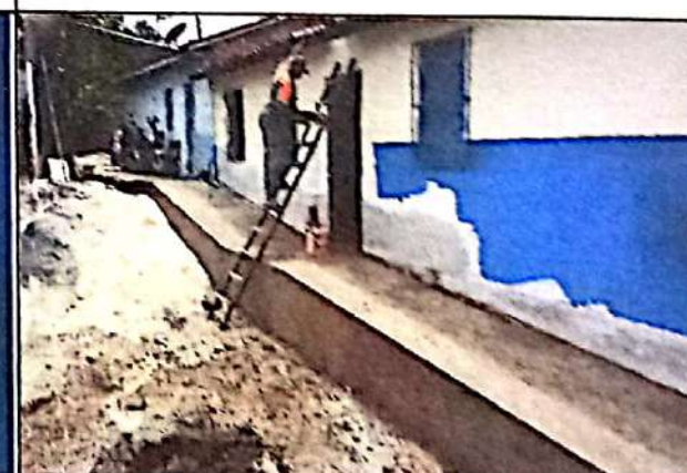
FOTO 06: Massa única da rampa.
