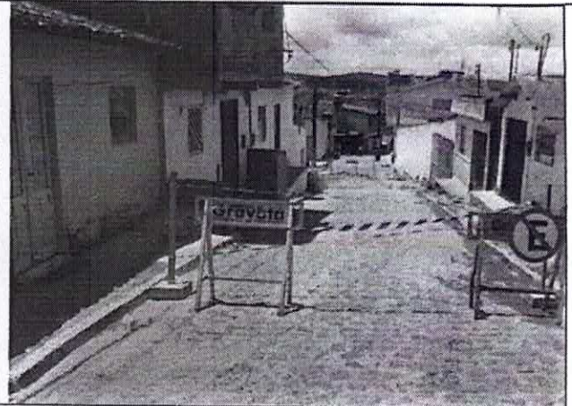
Foto 2: Travessa Caitano Alves Varela
