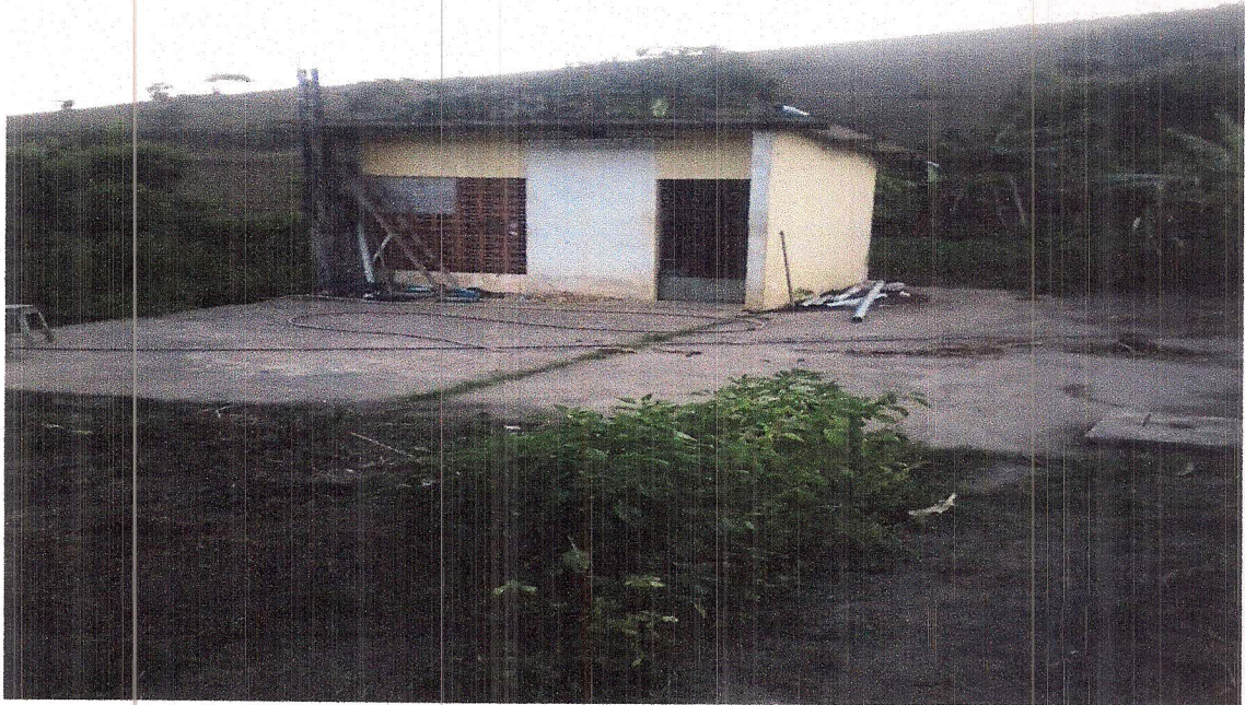
Casa da bomba
