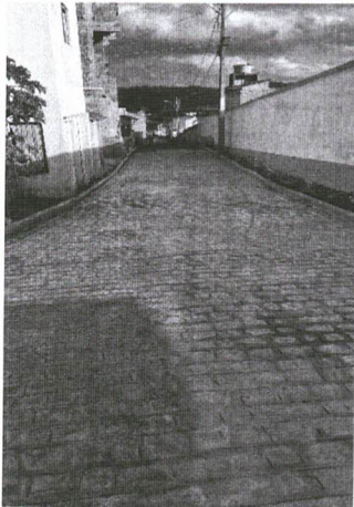
EXECUÇÃO DA PAVIMENTAÇÃO
