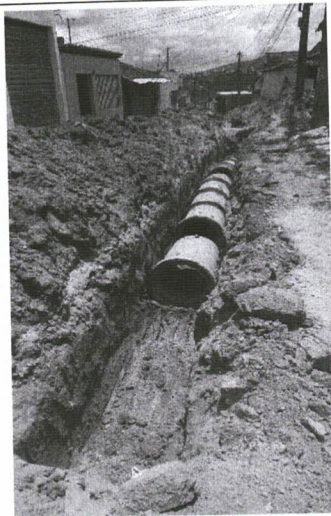
ASSENTAMENTO DE TUBOS DE CONCRETO
