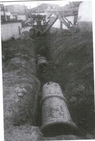
ASSENTAMENTO DE TUBOS DE CONCRETO
