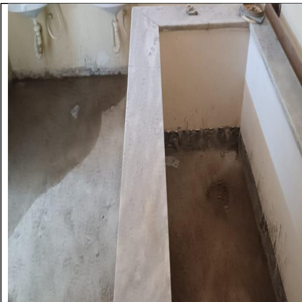
FOTO 15: EXECUÇÃO DE CONTRA PISO
