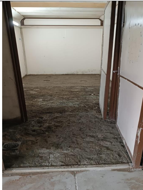
FOTO 13: EXECUÇÃO DE CONTRA PISO
