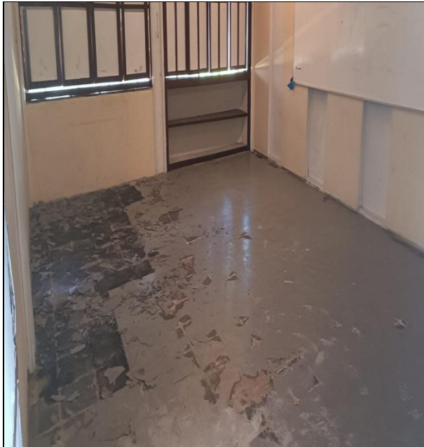
FOTO 01: PISO DAS SALAS DE AULA
