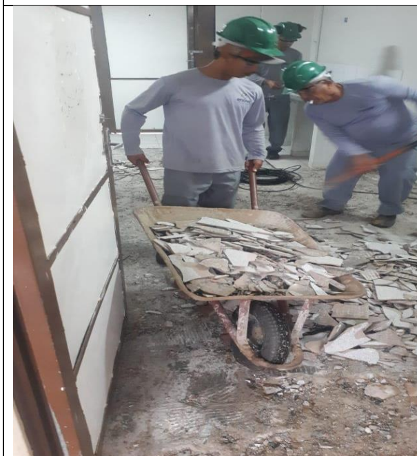
FOTO 03: REMOÇÃO DE PISO CERÂMICO.
