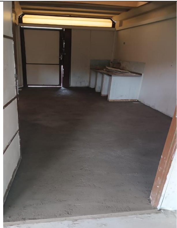
FOTO 14: EXECUÇÃO DE CONTRA PISO
