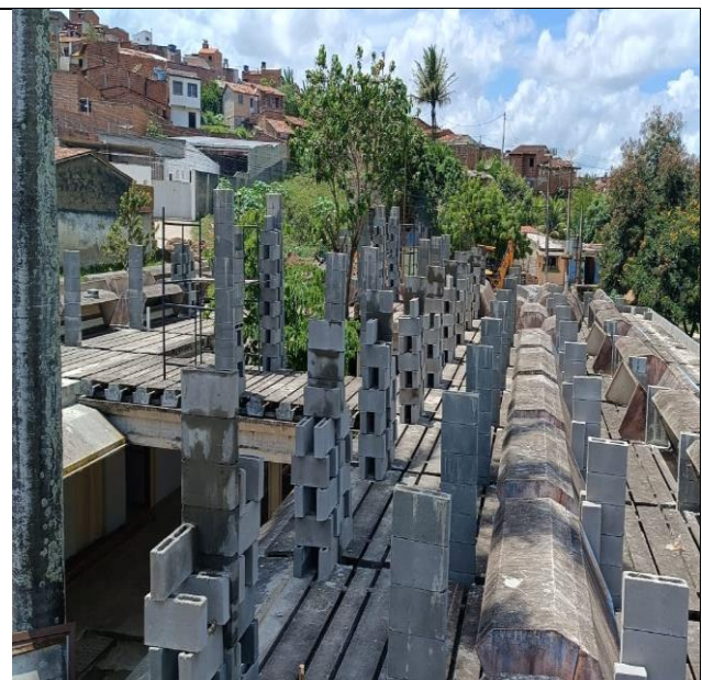
FOTO 10: EXECUÇÃO DOS PILARETES
