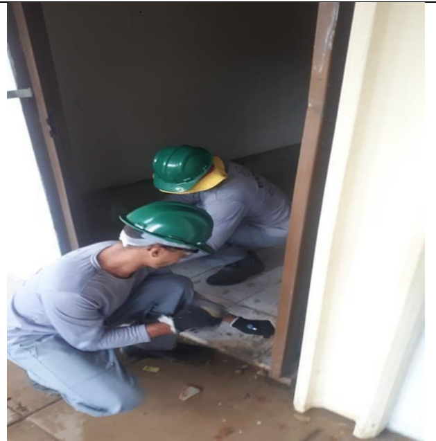
FOTO 02: REMOÇÃO DE PISO CERÂMICO.
