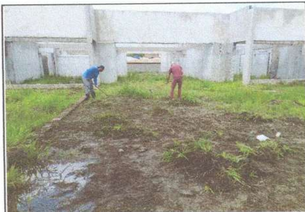
IMAGEM 17: Limpeza e capinação da obra
