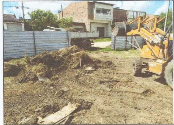
IMAGEM 08: Tapume em telha metálica e limpeza
