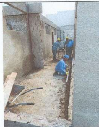
IMAGEM 16: Reboco em paredes
