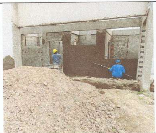
IMAGEM 15: Reboco em paredes
