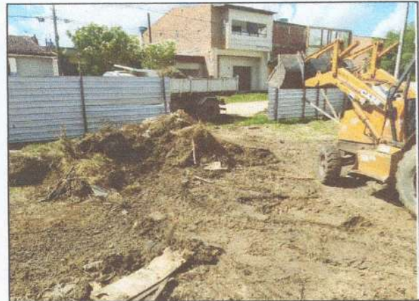
IMAGEM 08: Tapume em telha metálica e limpeza
