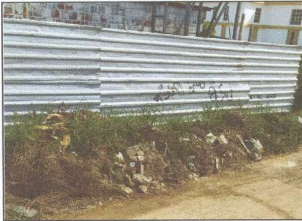
IMAGEM 07: Tapume em telha metálica
