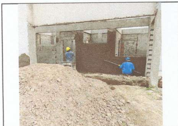
IMAGEM 15: Reboco em paredes
