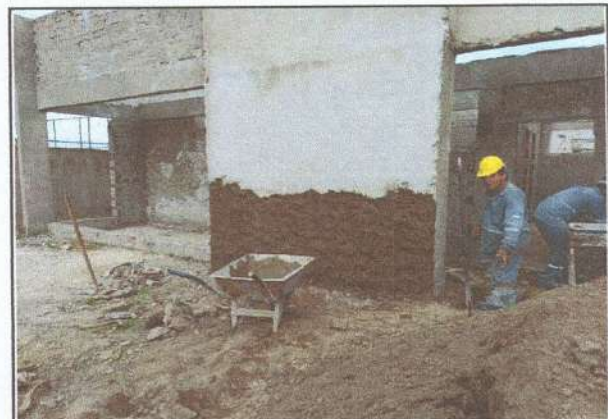
IMAGEM 12: Reboco em paredes
