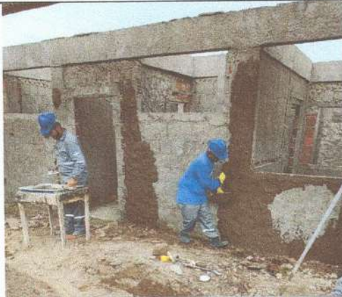
IMAGEM 13: Reboco em paredes
