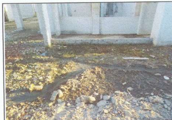
IMAGEM 18: Limpeza e capinação da obra
