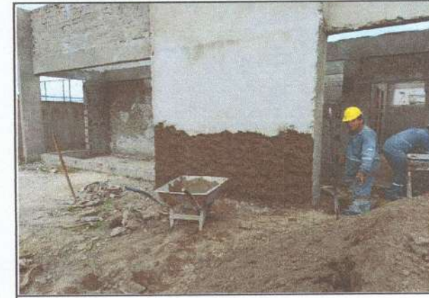
IMAGEM 12: Reboco em paredes
