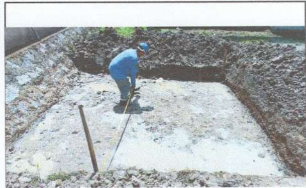
IMAGEM 10: Escavação da base do castelo d'água
