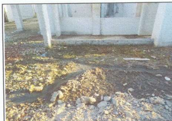
IMAGEM 18: Limpeza e capinação da obra
