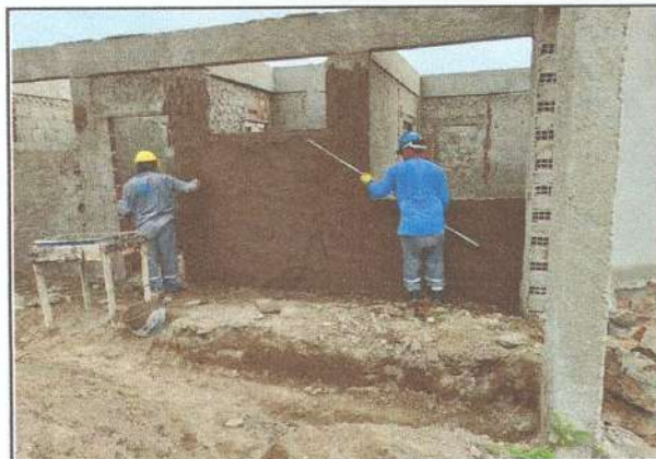
IMAGEM 11: Reboco em paredes
