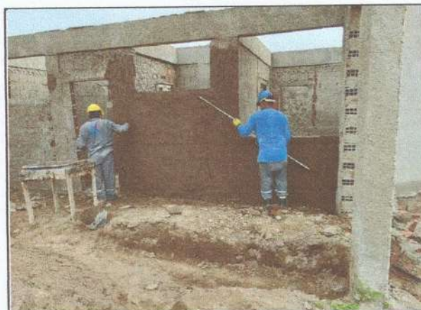
IMAGEM 14: Reboco em paredes
