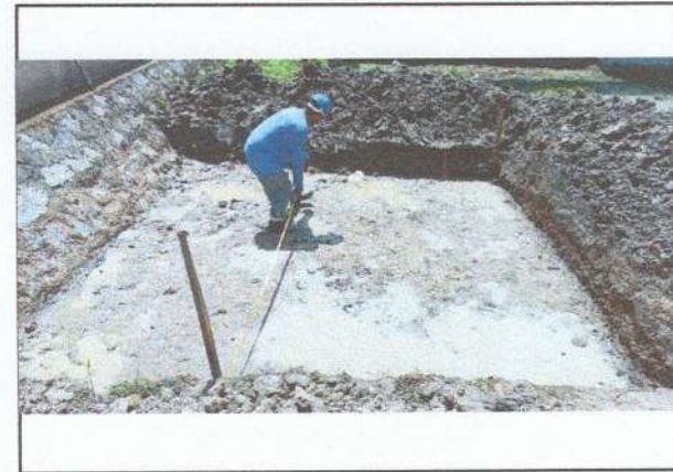
IMAGEM 10: Escavação da base do castelo d'água
