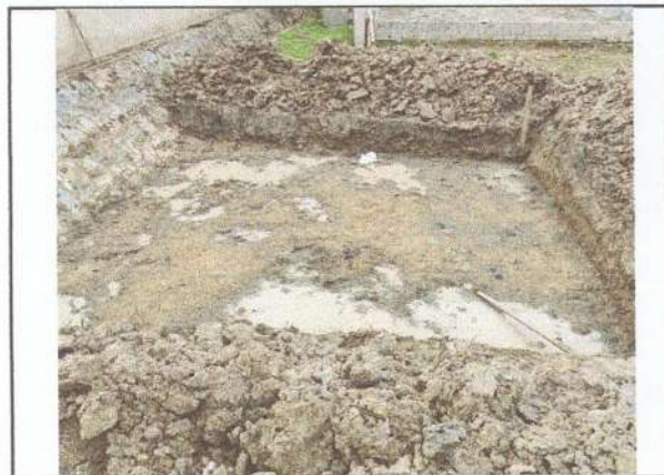
IMAGEM 09: Escavação da base do castelo d'água
