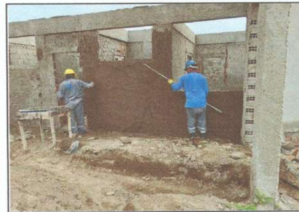
IMAGEM 11: Reboco em paredes
