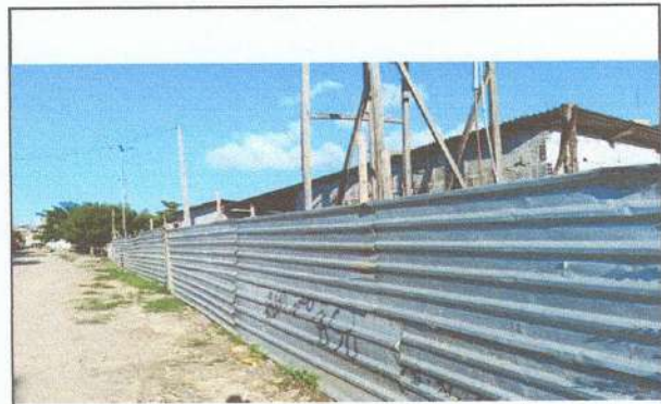
IMAGEM 06: Tapume em telha metálica
