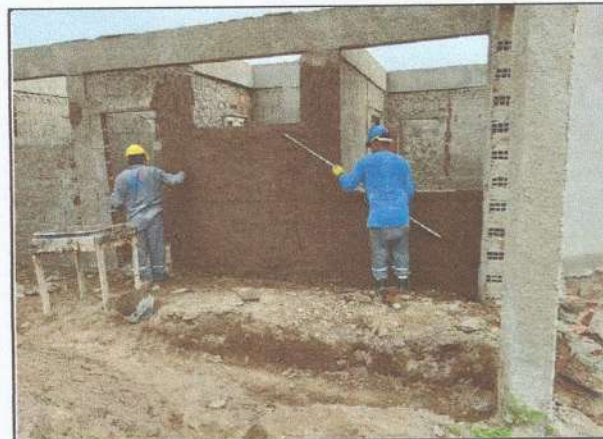
IMAGEM 14: Reboco em paredes
