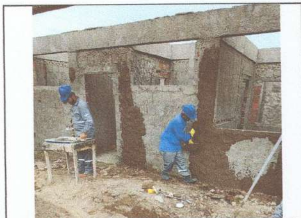
IMAGEM 13: Reboco em paredes
