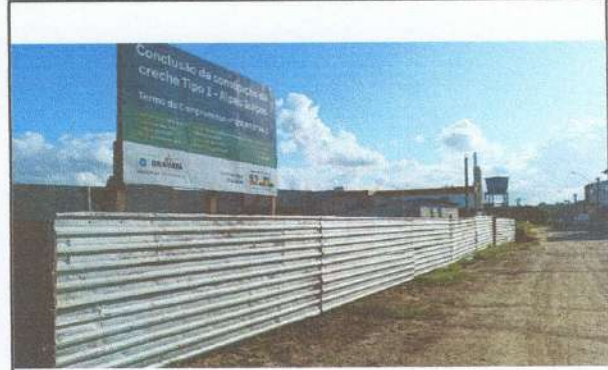
IMAGEM 02: Placa de obra e tapume
