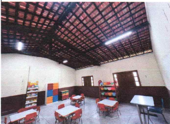
FOTO 11: MADEIRA IMUNIZADA E COM LUMINARIA INSTALADA
