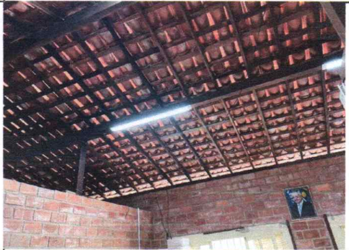
FOTO 14: MADEIRA IMUNIZADA E COM LUMINÁRIA INSTALADA
