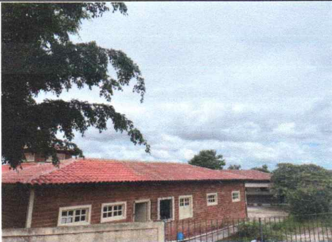
FOTO 03: COBERTA RETELHANDA E LIMPA
