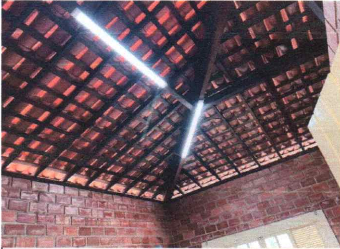
FOTO 13: MADEIRA IMUNIZADA E COM LUMINARIA INSTALADA
