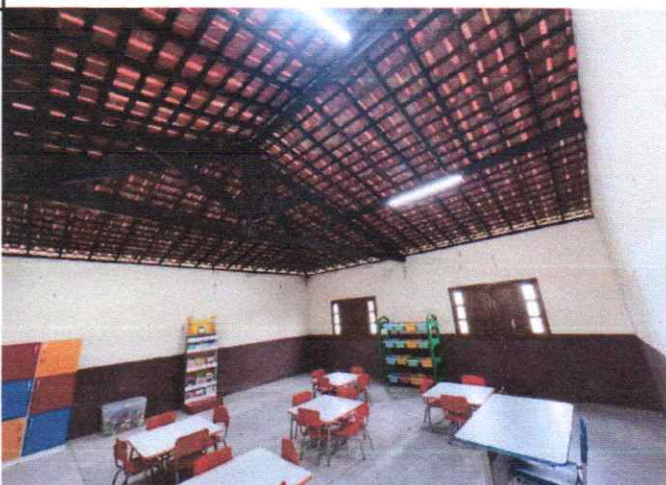
FOTO 10: MADEIRA IMUNIZADA E COM LUMINARIA INSTALADA
