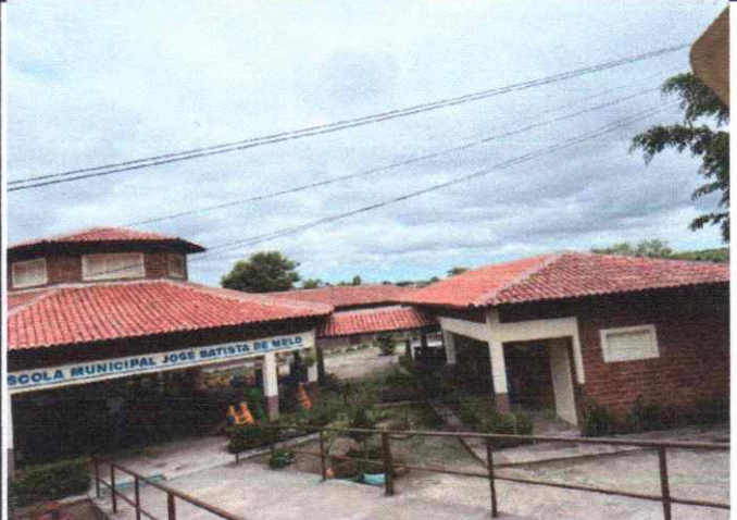
FOTO 04: COBERTA RETELHADA, LIMPA E COM CUMEEIRA REFEITA
