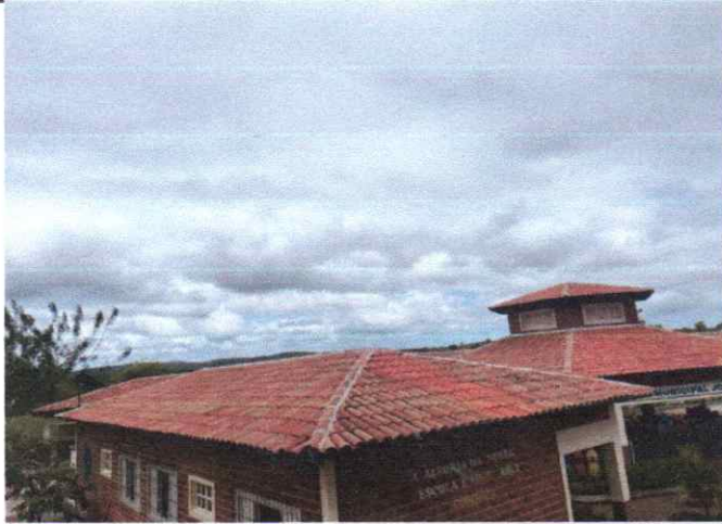
FOTO 01: RETELHANDO, LIMPO E COM CUMEEIRA REFEITA
