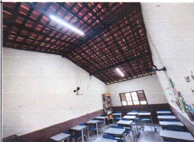
FOTO 08: MADEIRA IMUNIZADA E COM LUMINARIA INSTALADA
