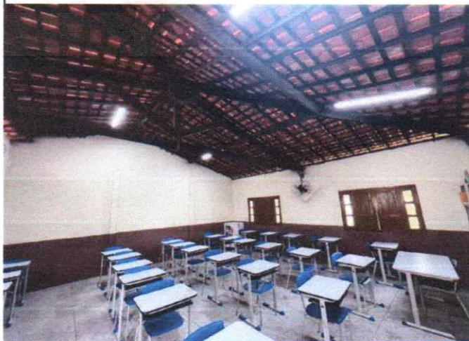
FOTO 06: MADEIRA IMUNIZADA E COM LUMINARIA INSTALADA
