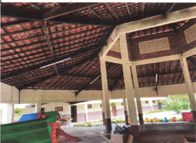
FOTO 12: MADEIRA IMUNIZADA E COM LUMINARIA INSTALADA
