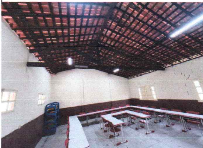
FOTO 09: MADEIRA IMUNIZADA E COM LUMINARIA INSTALADA
