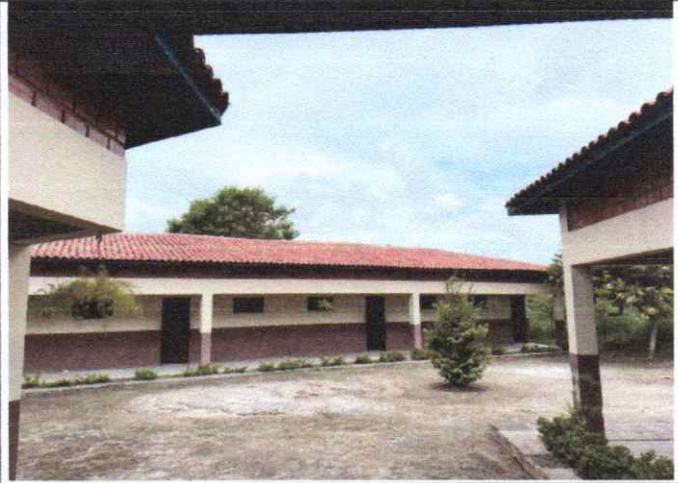
FOTO 02: RETELHANDO E LIMPO
