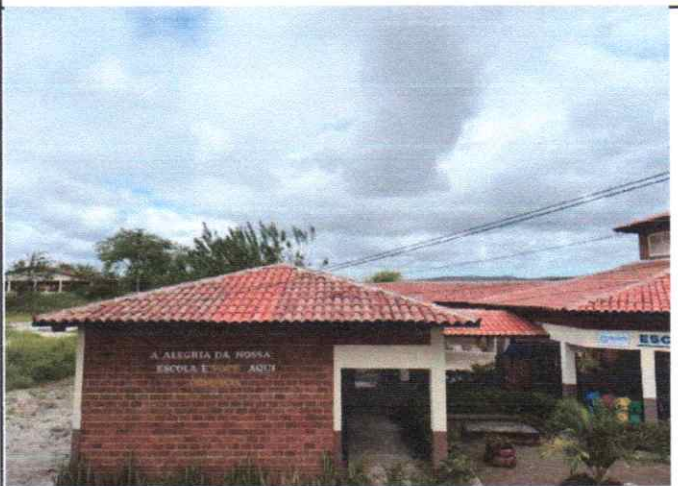
FOTO 06: COBERTA RETELHADA, LIMPA E COM CUMEEIRA REFEITA
