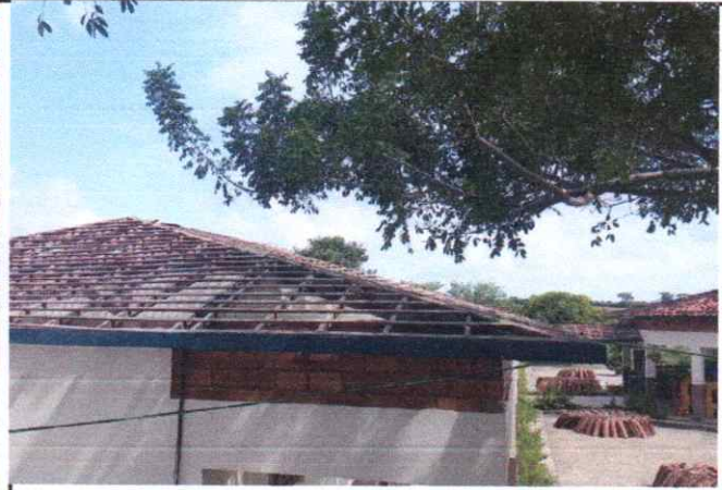
FOTO 08: REMOÇÃO DE TELhado PARA SUBSTITUIÇÃO DE MADEIRAMENTO DANIFICADO E LIMPEZA DAS TELHAS
