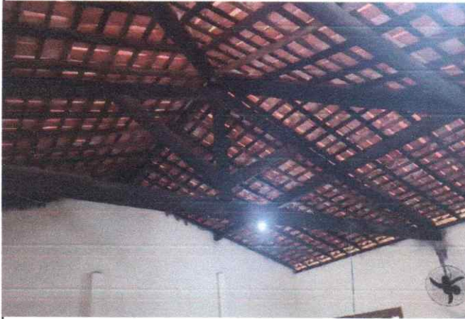
FOTO 09: TESOURA SUBSTITUIDA E APLICADO IMUNIZANTE NA MADEIRA
