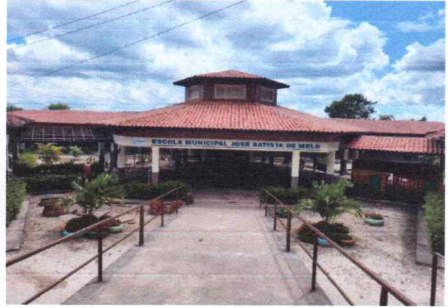
FOTO 14: ENTRADA DO PRÉDIO COM O RETELHAMENTO EM ANDAMENTO
