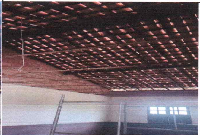
FOTO 08: REMOÇÃO DE TELhado PARA SUBSTITUIÇÃO DE MADEIRAMENTO DANIFICADO E LIMPEZA DAS TELHAS
