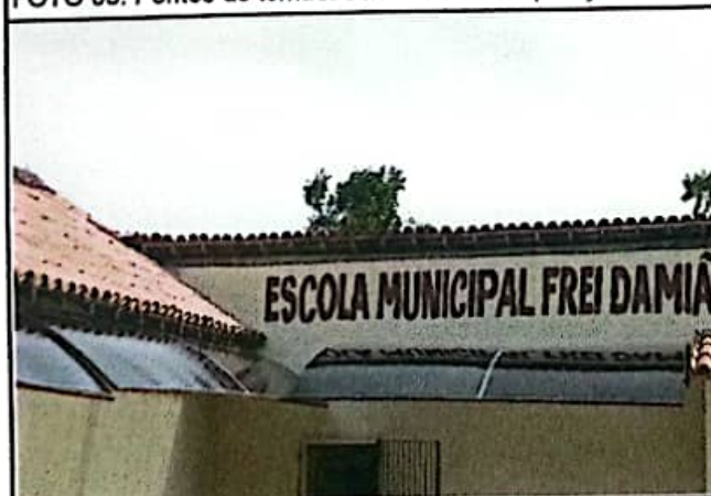
FOTO 05: Toldo em policarbonato na entrada da escola.
