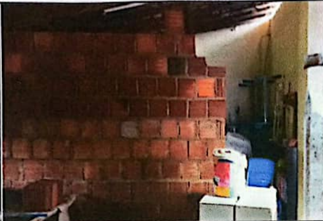
FOTO 01: Alvenaria de vedação da sala de computação.
