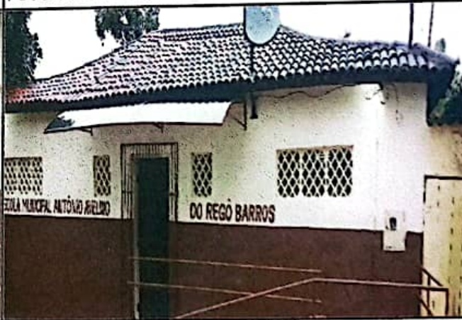
FOTO 12: Revisão de coberta de toda escola.
