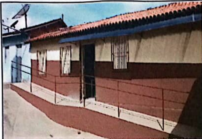
FOTO 07: Pintura de toda escola.
