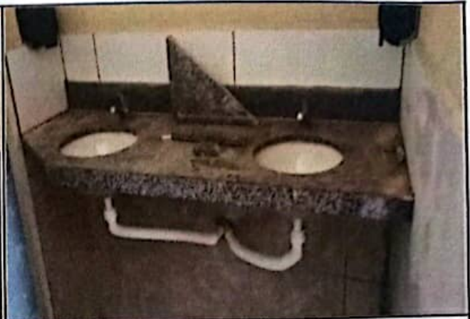
FOTO 08: Lavatorio com bancada de granito.
