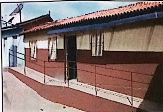
FOTO 07: Pintura de toda escola.
