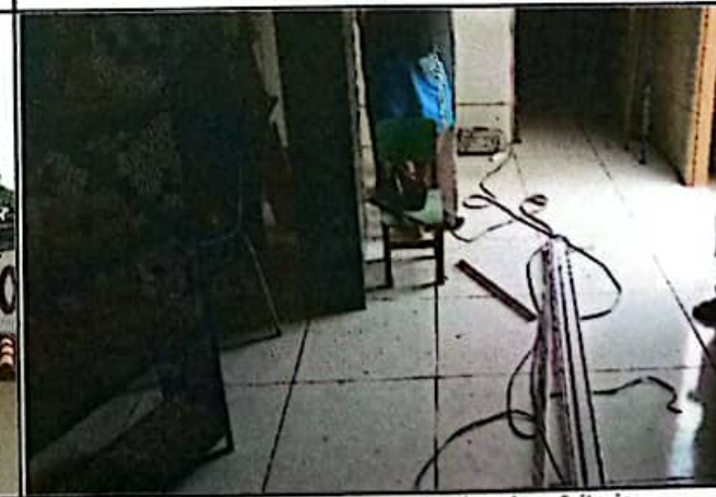
FOTO 06: Revestimento cerâmico do piso do refeitório.
