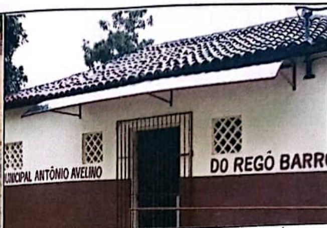
FOTO 08: Toldo em policarbonato na entrada da escola.
