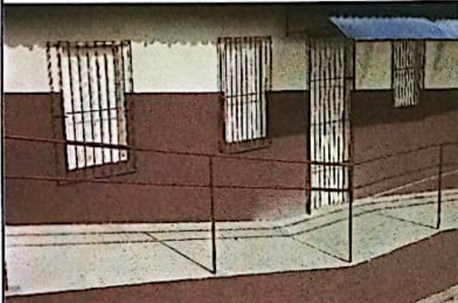
FOTO 09: Grades de proteção da porta e janelas.
