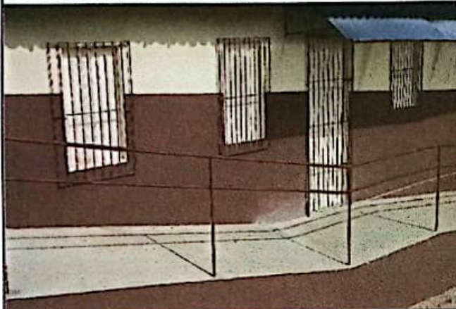
FOTO 09: Grades de proteção da porta e janelas.
