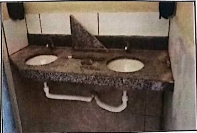
FOTO 08: Lavatorio com bancada de granito.
