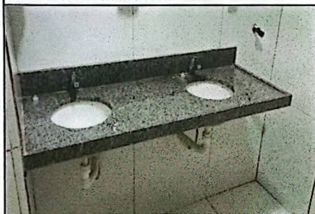
FOTO 03: Lavatório em bancada de granito.
