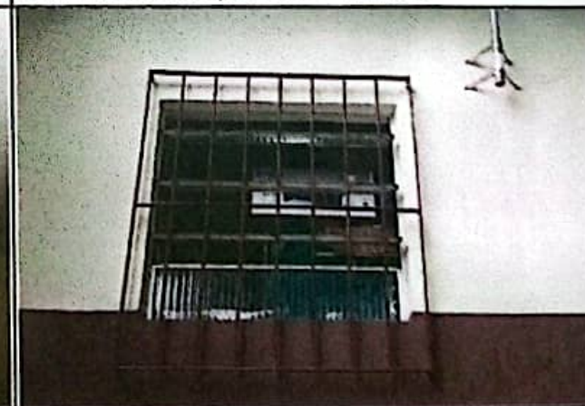
FOTO 06: Grade de proteção da janela.
