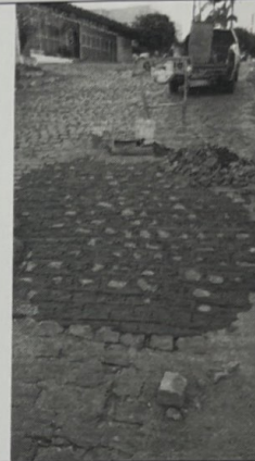
Foto 14: Rua Quintino Bocaiuva
