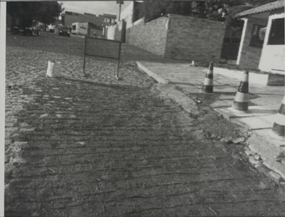
Foto 16: Rua Quintino Bocaiuva
