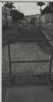
Foto 18: Rua Quintino Bocaiuva
