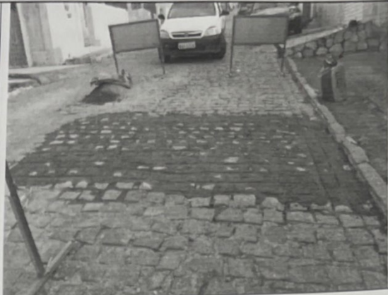
Foto 48: Rua São Lucas
