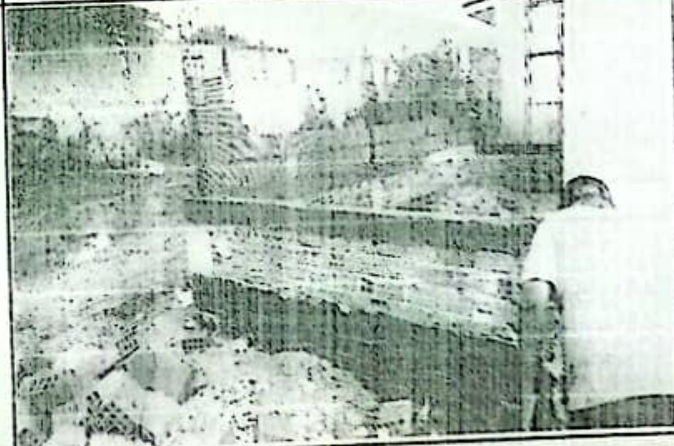
FOTO 06: Alvenaria de embasamento.
