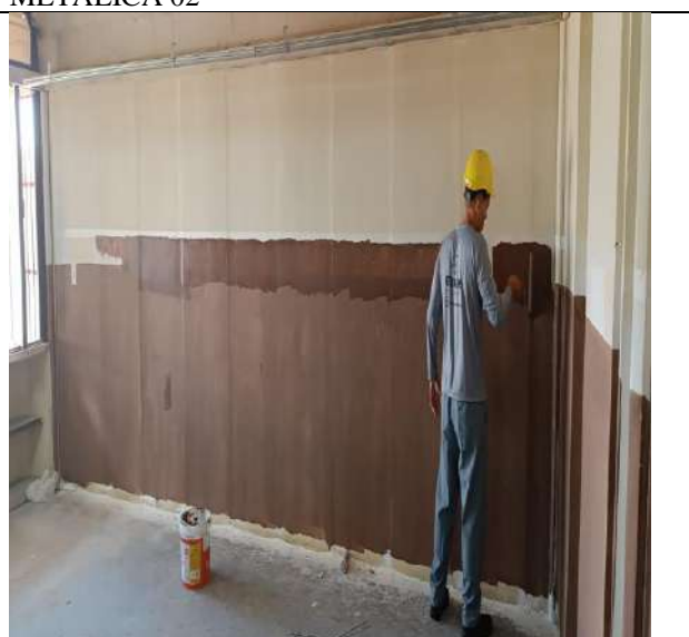
FOTO 16: EXECUÇÃO DE PINTURA DA CRECHE 02
