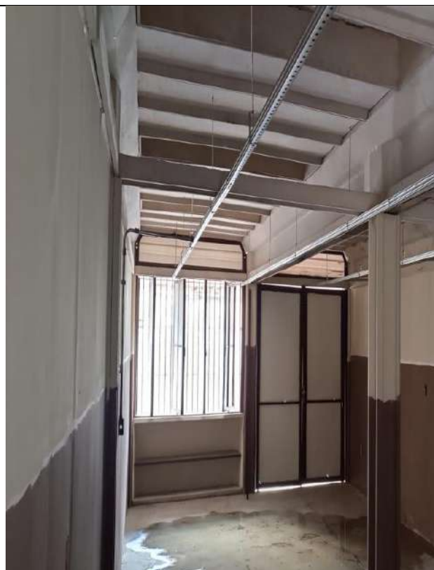
FOTO 14: INSTALAÇÃO DE ELETROCALHA METALICA 02
