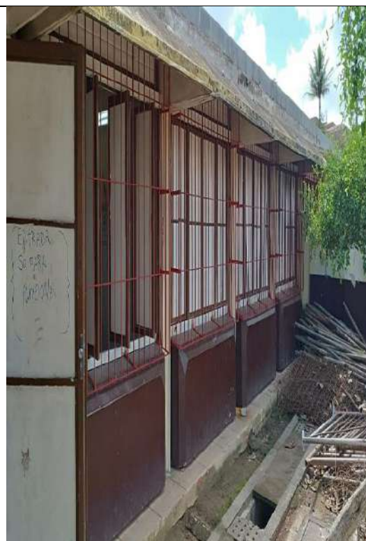
FOTO 07: GRADES DE JANELAS
