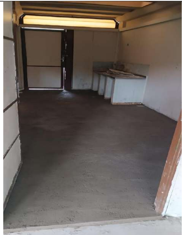
FOTO 14: EXECUÇÃO DE CONTRA PISO
