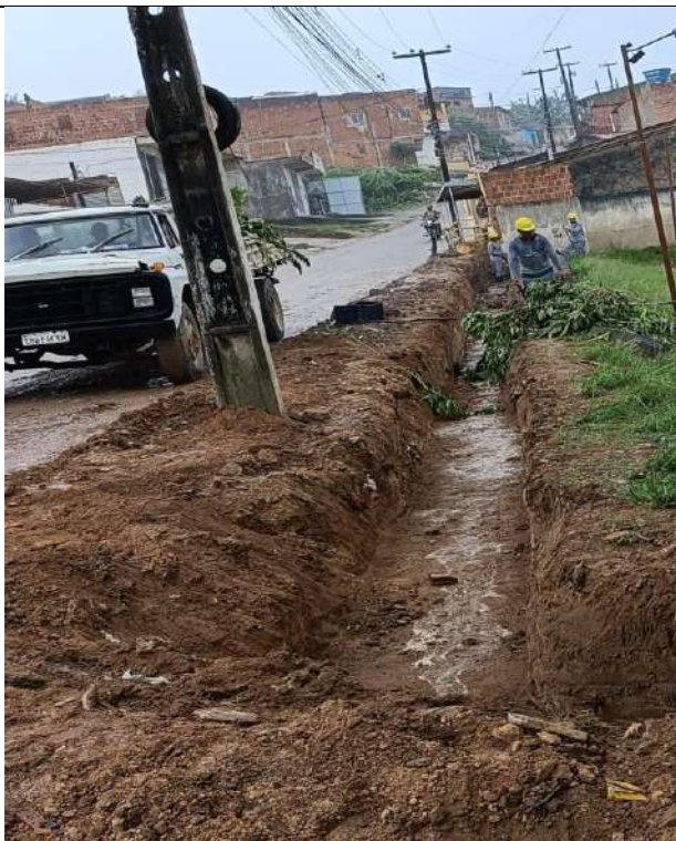
FOTO 01: ESCAVAÇÃO DE VALAS PARA CINTAS E SAPATAS DO MURO
