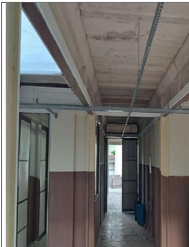
FOTO 13: INSTALAÇÃO DE ELETROCALHA METALICA 01
