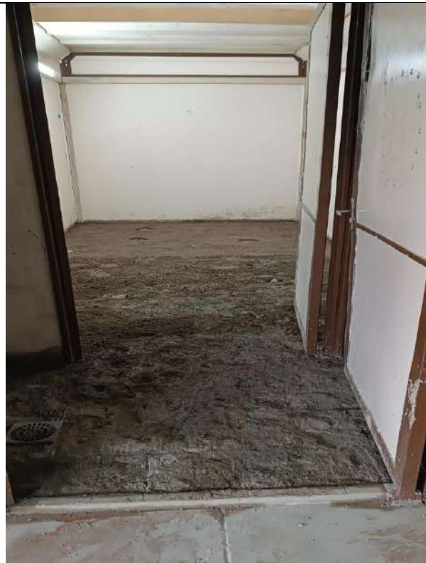
FOTO 13: EXECUÇÃO DE CONTRA PISO
