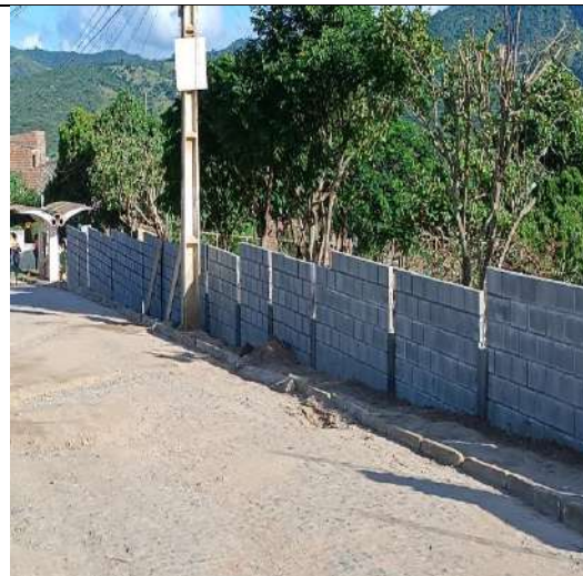
FOTO 04: PILARES E ALVENARIA DE MURO 02
