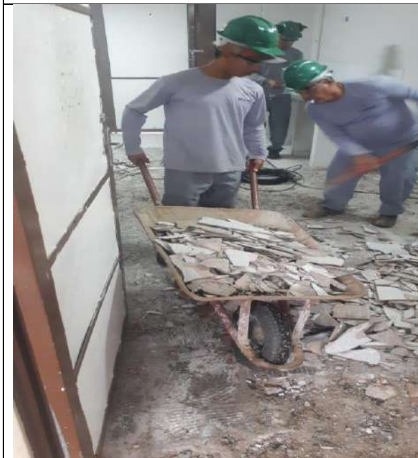
FOTO 03: REMOÇÃO DE PISO CERÂMICO.
