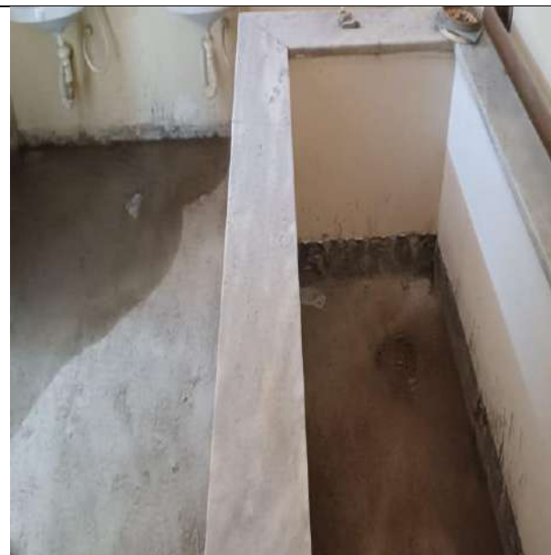
FOTO 15: EXECUÇÃO DE CONTRA PISO
