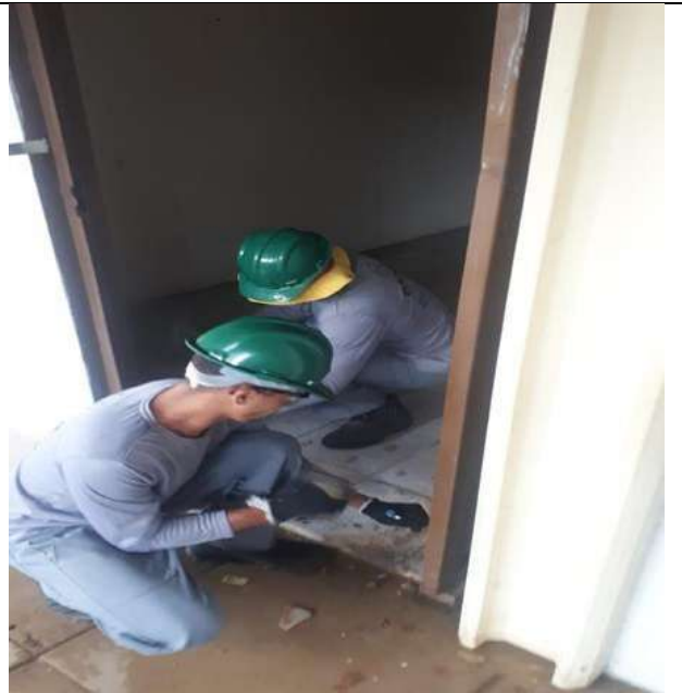
FOTO 02: REMOÇÃO DE PISO CERÂMICO.
