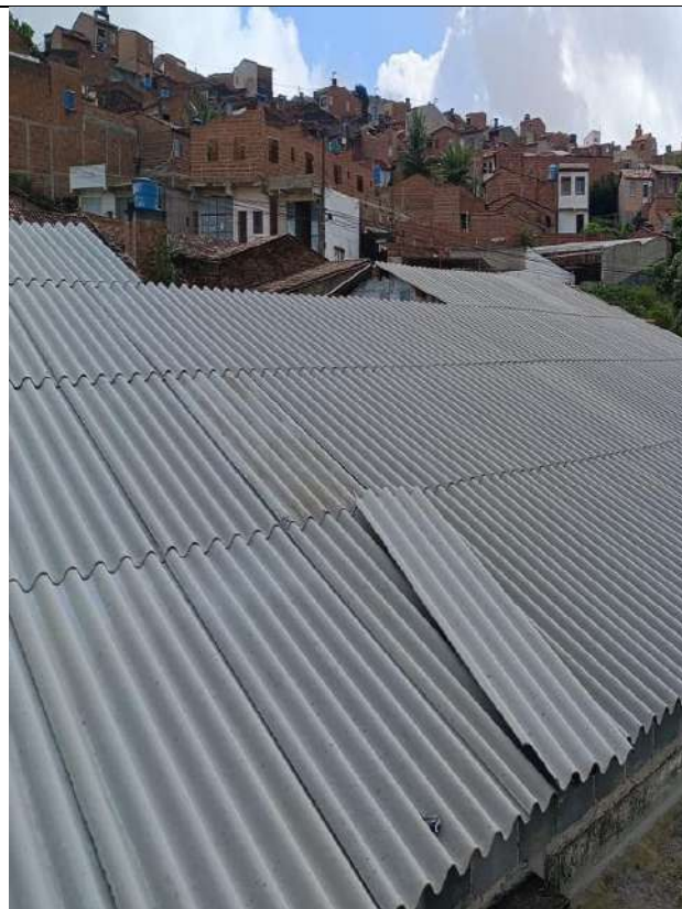
FOTO 10: COBERTA CRECHE, TELHAS EM FIBROCIMENTO 02
