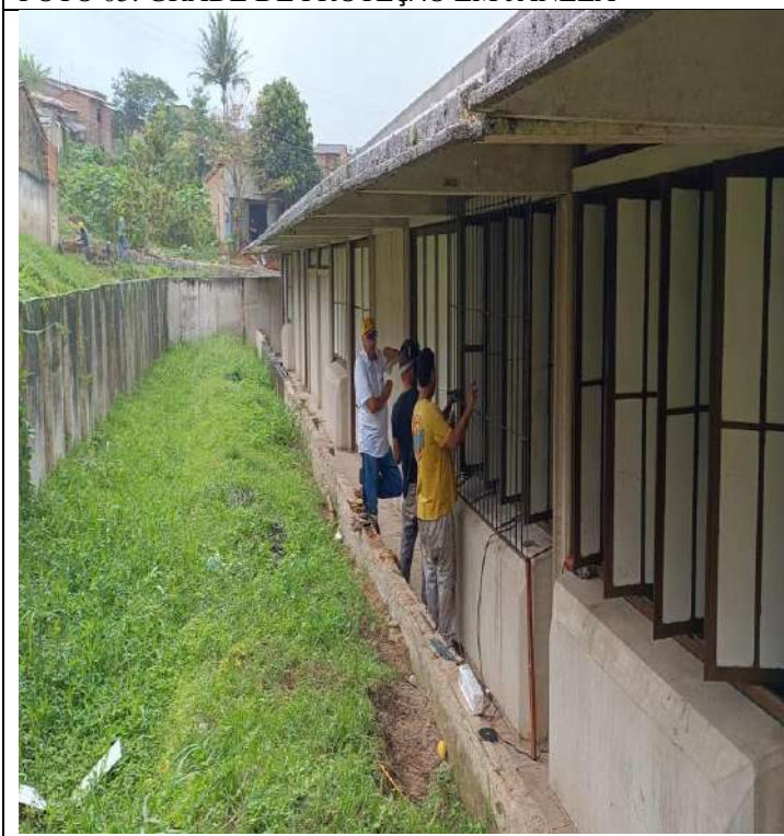
FOTO 06: INSTALAÇÃO DE GRADES DE PROTEÇÃO
