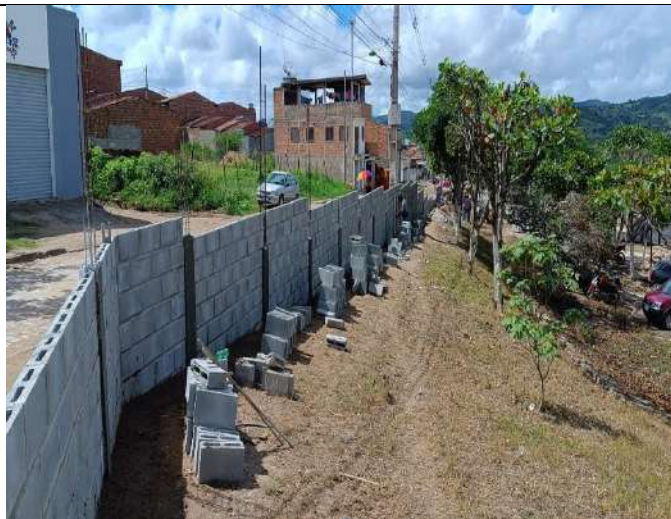
FOTO 03: PILARES E ALVENARIA DE MURO 01
