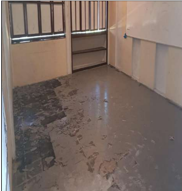
FOTO 01: PISO DAS SALAS DE AULA
