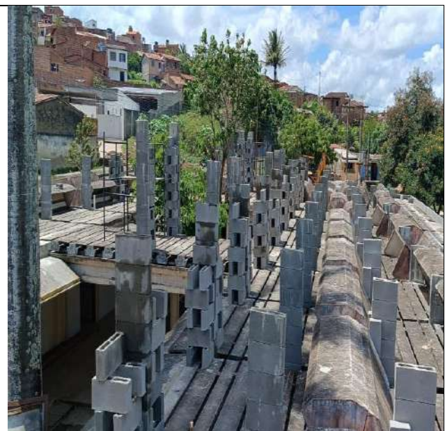
FOTO 10: EXECUÇÃO DOS PILARETES
