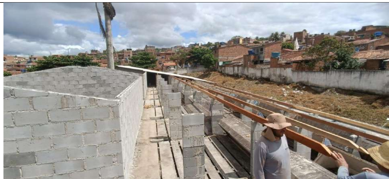
FOTO 08: INSTALAÇÃO DE LINHAS- COBERTA CRECHE.
