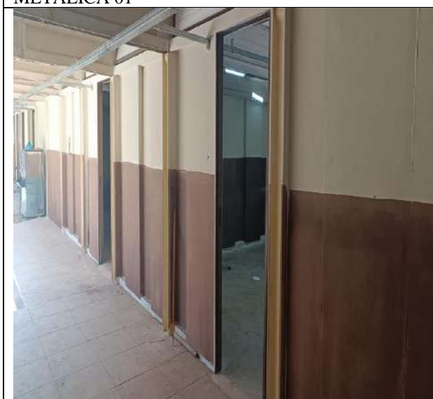
FOTO 15: EXECUÇÃO DE PINTURA DA CRECHE 01
