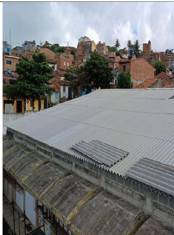
FOTO 09: COBERTA CRECHE, TELHAS EM FIBROCIMENTO 01
