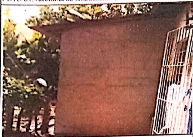
FOTO 03: Massa única no PNE externo.
