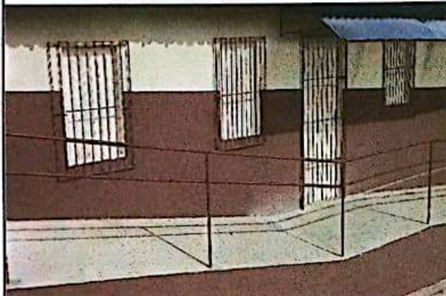
FOTO 09: Grades de proteção da porta e janelas.
