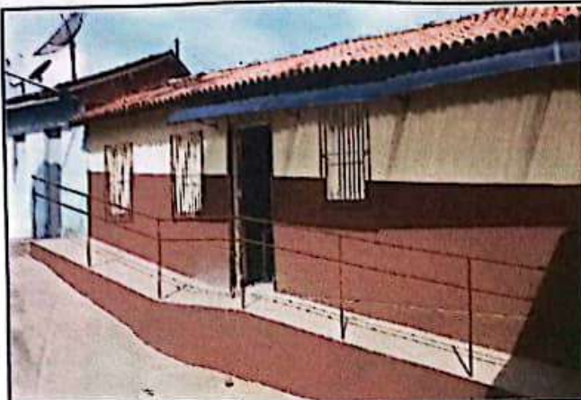
FOTO 07: Pintura de toda escola.
