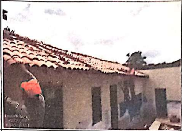
FOTO 08: Revisão de coberta.
