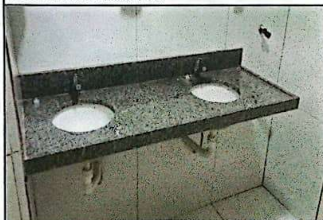
FOTO 03: Lavatório em bancada de granito.
