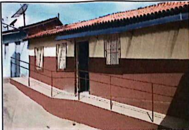
FOTO 07: Pintura de toda escola.
