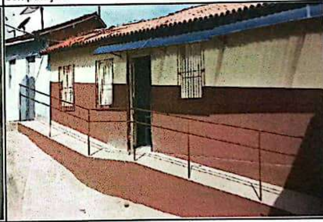
FOTO 04: Guarda corpo na rampa de acesso.
