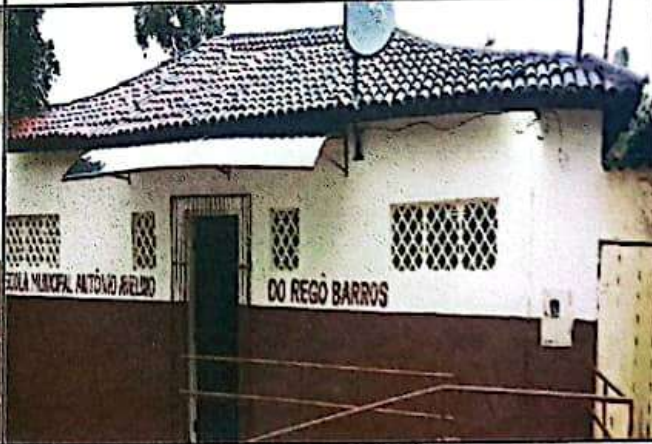
FOTO 12: Revisão de coberta de toda escola.
