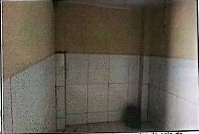
FOTO 02: Revestimento cerâmico das paredes da sala de computação.
