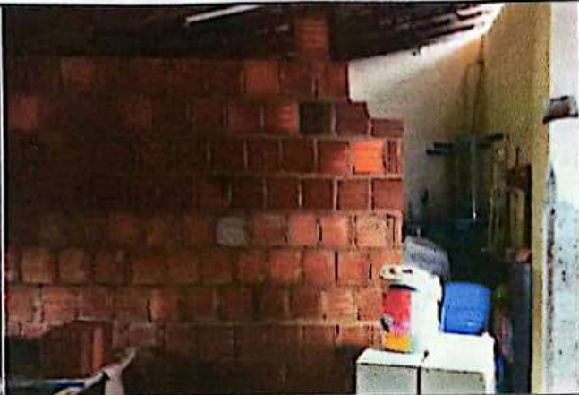
FOTO 01: Alvenaria de vedação da sala de computação.
