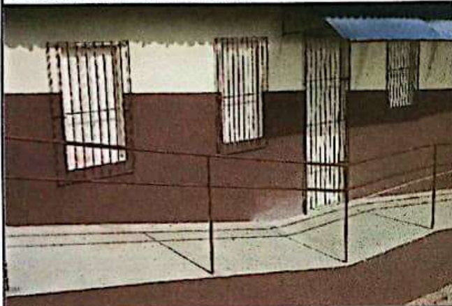
FOTO 09: Grades de proteção da porta e janelas.
