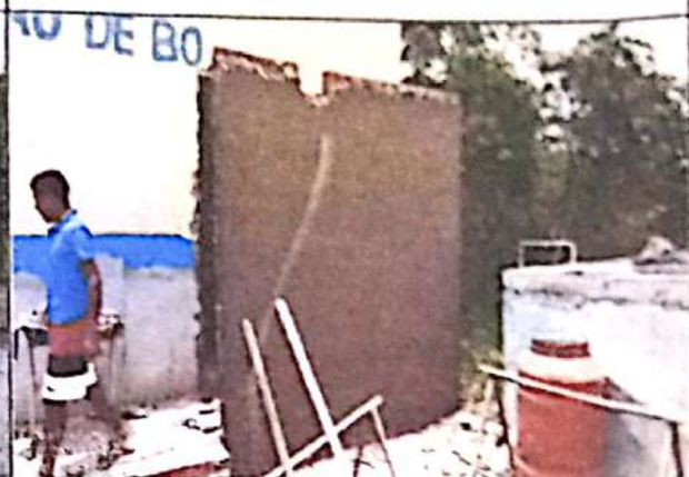
FOTO 02: Massa única em alvenaria do PNE
