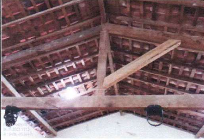
FOTO 01: TESOURA DANIFICADA ( ANTES DA INTERVENÇÃO)
