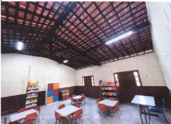
FOTO 11: MADEIRA IMUNIZADA E COM LUMINARIA INSTALADA
