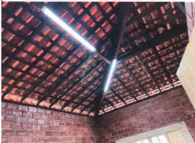
FOTO 13: MADEIRA IMUNIZADA E COM LUMINÁRIA INSTALADA
