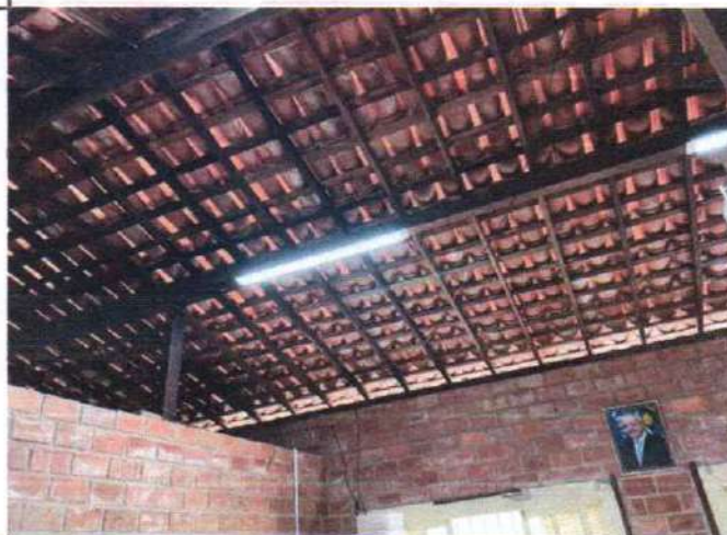
FOTO 14: MADEIRA IMUNIZADA E COM LUMINÁRIA INSTALADA
