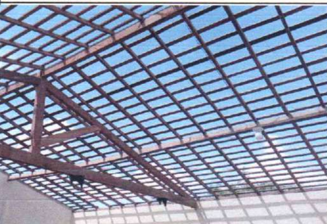
FOTO 05: REMOÇÃO DE TELHADO PARA SUBSTITUIÇÃO DE MADEIRAMENTO DANIFICADO E LIMPEZA DAS TELHAS
