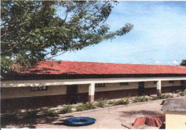
FOTO 13: BLOCO RETELHADO
