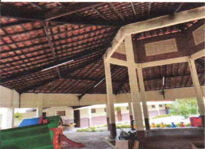
FOTO 12: MADEIRA IMUNIZADA E COM LUMINARIA INSTALADA
