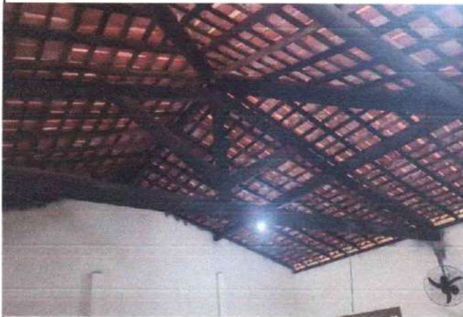
FOTO 09: TESOURA SUBSTITUIDA E APLICADO IMUNIZANTE NA MADEIRA
