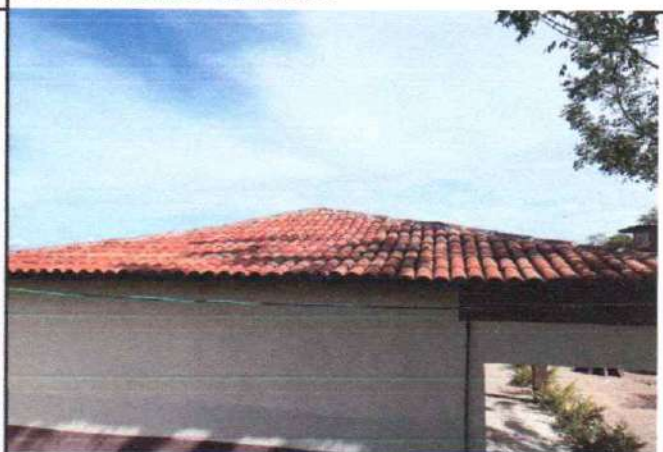
FOTO 12: BLOCO COM RETELHADO
