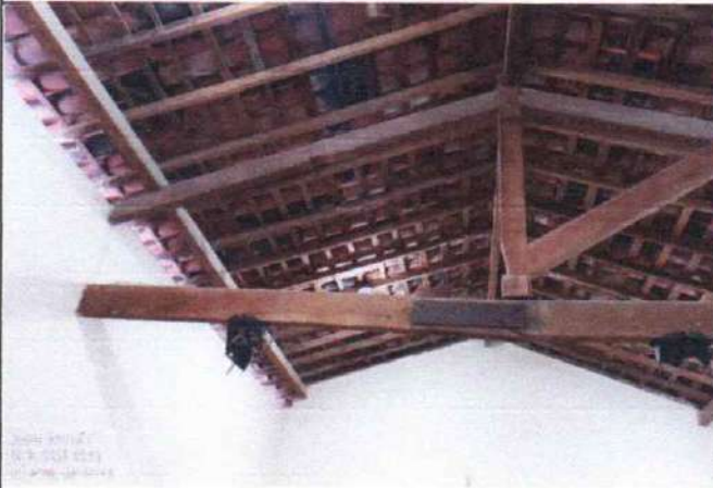
FOTO 03: TESOURA DANIFICADA ( ANTES DA INTERVENÇÃO)
