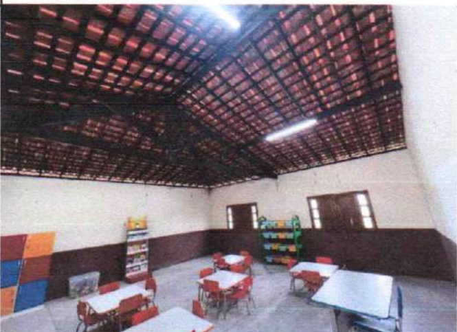
FOTO 10: MADEIRA IMUNIZADA E COM LUMINARIA INSTALADA
