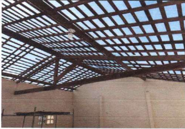
FOTO 06: REMOÇÃO DE TELhado PARA SUBSTITUIÇÃO DE MADEIRAMENTO DANIFICADO E LIMPEZA DAS TELHAS
