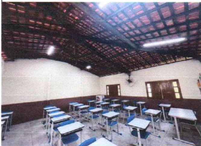
FOTO 06: MADEIRA IMUNIZADA E COM LUMINARIA INSTALADA
