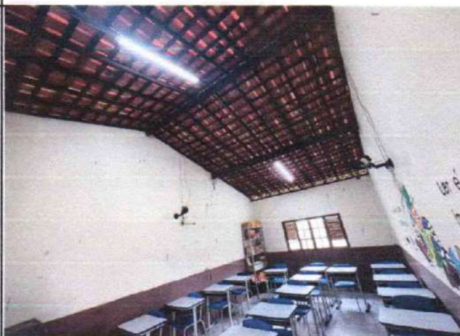
FOTO 08: MADEIRA IMUNIZADA E COM LUMINARIA INSTALADA
