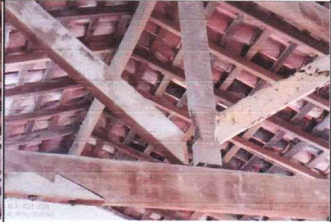
FOTO 02: TESOURA DANIFICADA ( ANTES DA INTERVENÇÃO)
