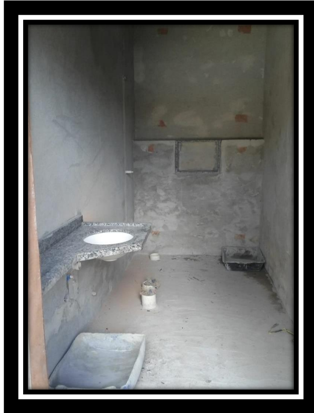
Foto 78 – Lavatorio no vestiário
