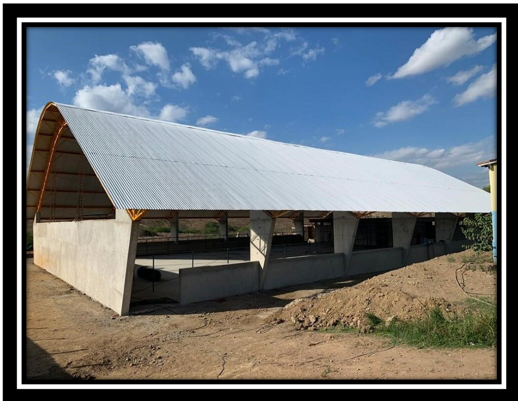
Foto 43 - Sistema de cobertura (Quadra, Russinhas)
