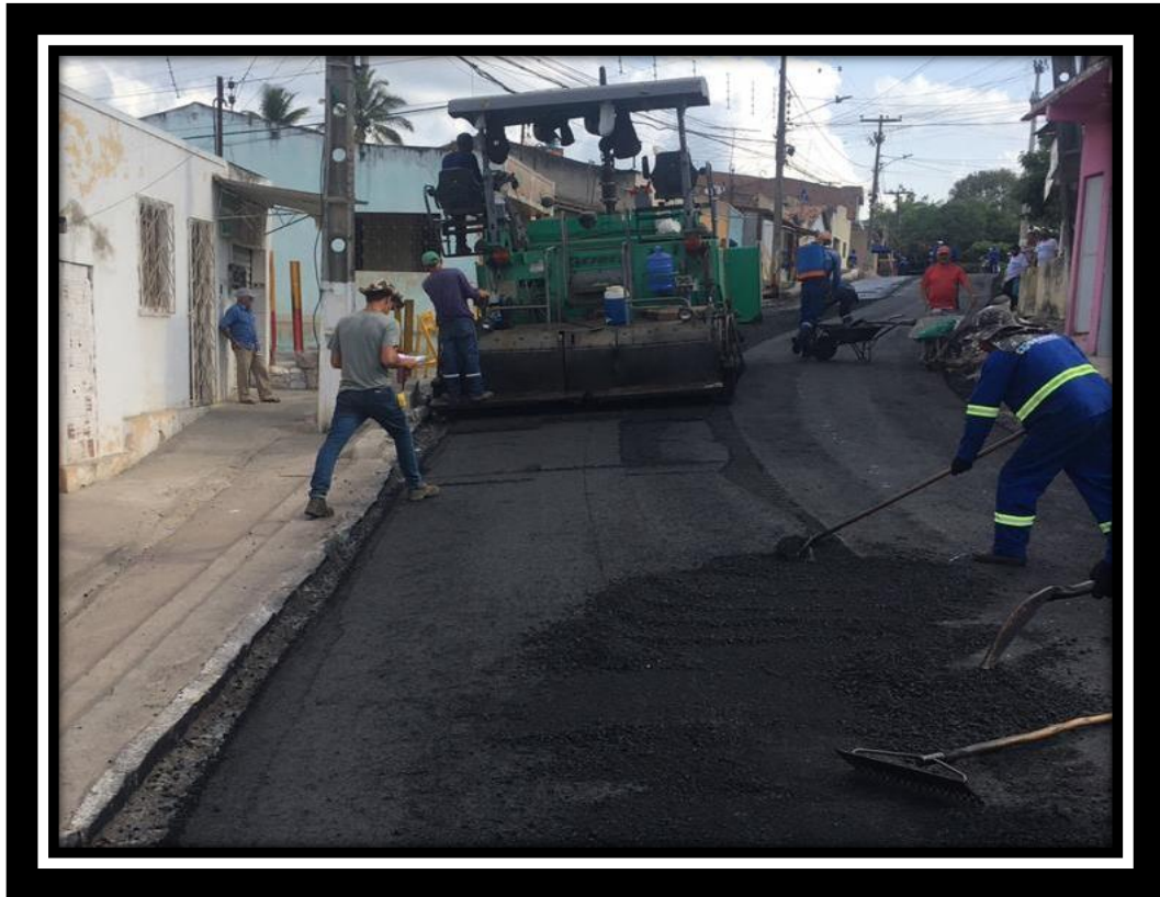
Foto 88 - Execução da camada de BINDER (Rua São Pedro, Cruzeiro)
