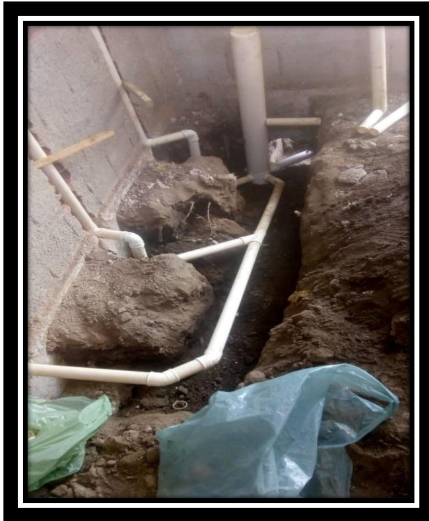
Foto 48 - Instalações sanitárias em andamento (Quadra, Mandacaru)
