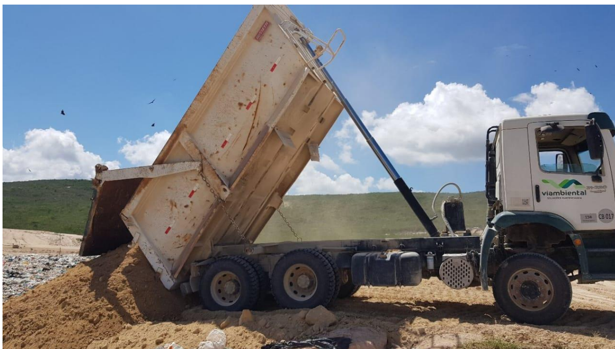
FOTO 29- Imagem do descarregamento do material para a cobertura dos RSU.
