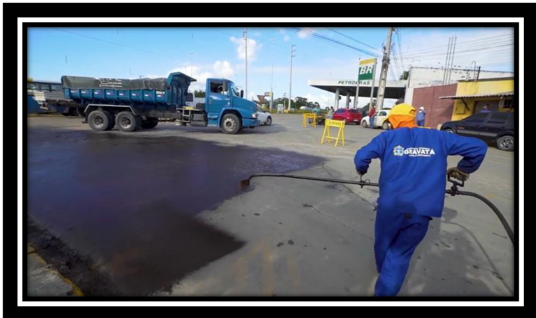
Foto 83 – Aplicação de ligante com emulsão asfáltica (Rua 15 (quise) de Novembro/Acesso a BR 232)
