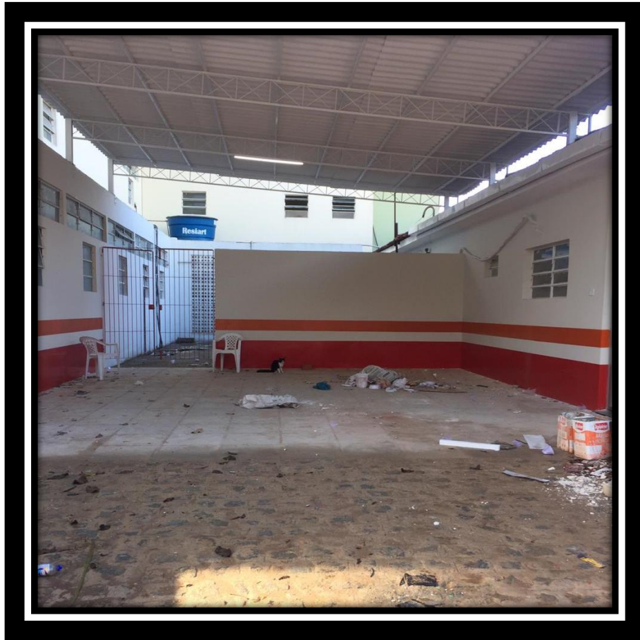
Foto 31 – Pátio com pavimentação em paralelepípedo – Coberta (SAMU)
