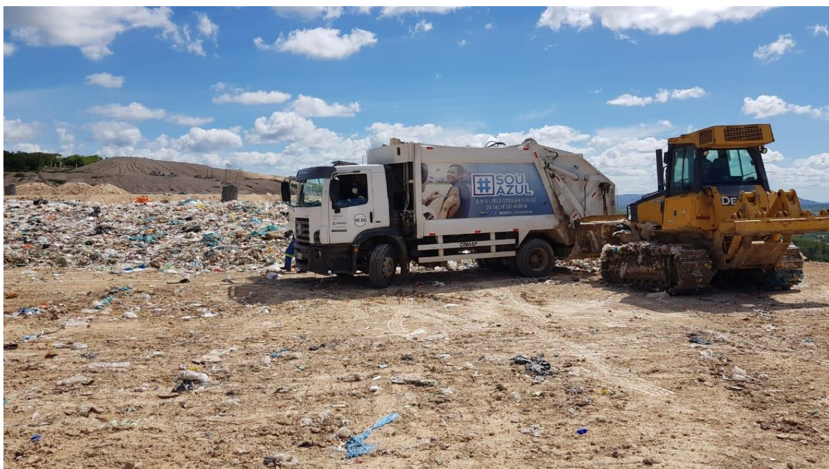
FOTO 20-Imagem da frente de operação de destinação dos resíduos sólidos urbanos, detalhe para o espalhamento e compactação da camada.
