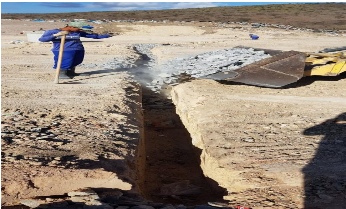
FOTO 19- Imagem da implantação de drenos horizontais.
