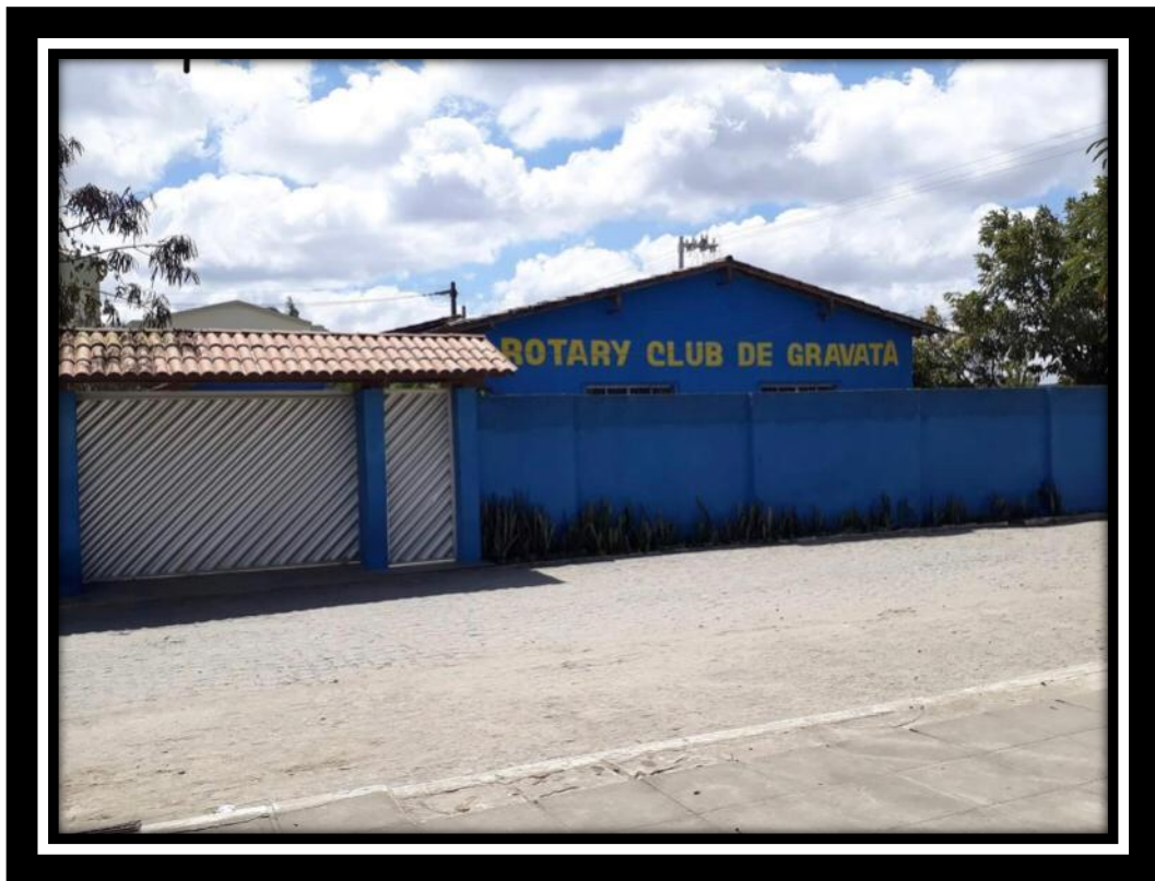
Foto 67 – Fachada (Escola do Rotary)
