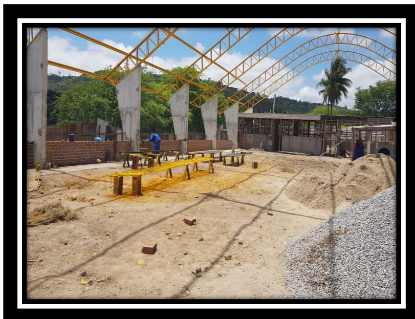
Foto 49 - Trelça metálica (Quadra, Mandacaru)
