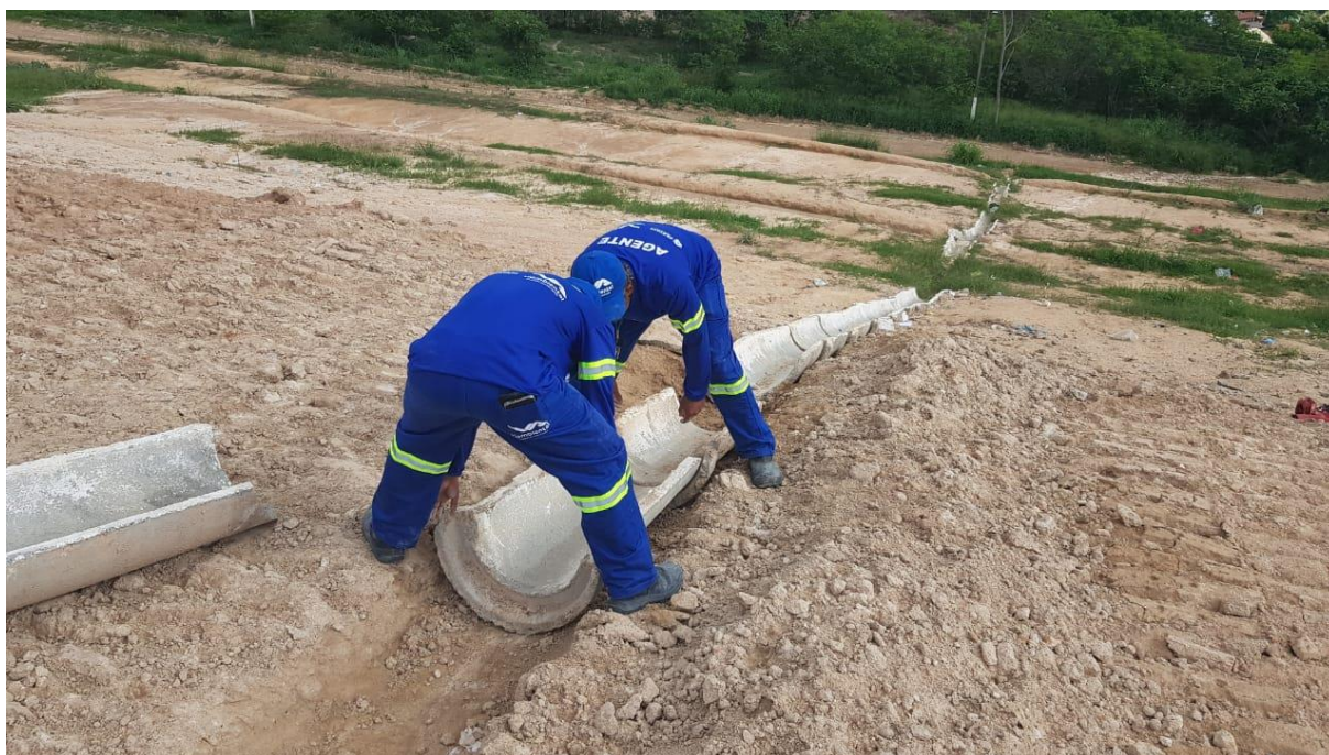
FOTO 14- Imagem implantação de dreno de água pluviais.
