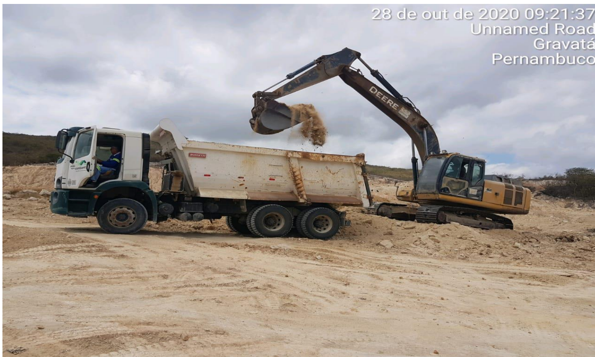
FOTO 27- Imagem detalha a retirada de argila para a cobertura dos RSU na frente de operação.
