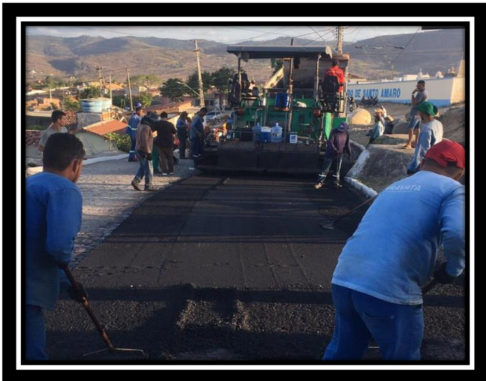
Foto 91 - Execução da 1ª (primeira) camada com BINDER (Rua do Alecrim, Cruzeiro)
