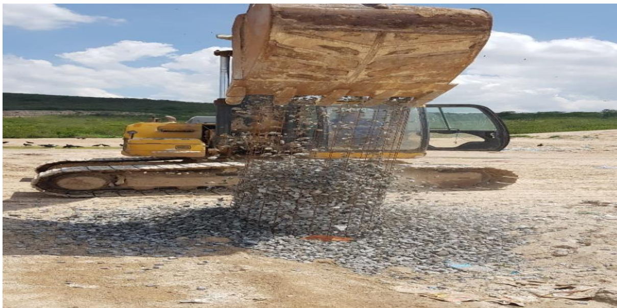
FOTO 15- Imagem detalha a implantação de dreno vertical para coleta e queima de gás.
