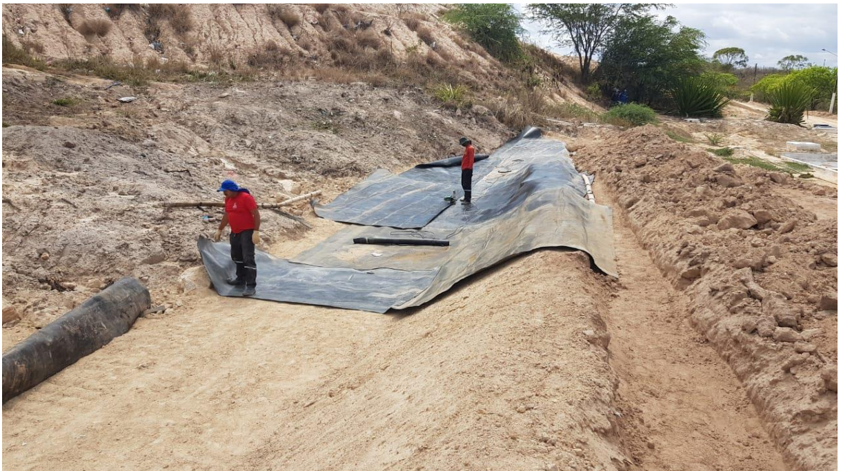
FOTO 31- Imagem da impermeabilização da nova célula.
