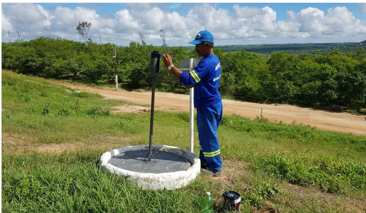
FOTO 16- Imagem detalha manutenção no queimador de gás.
