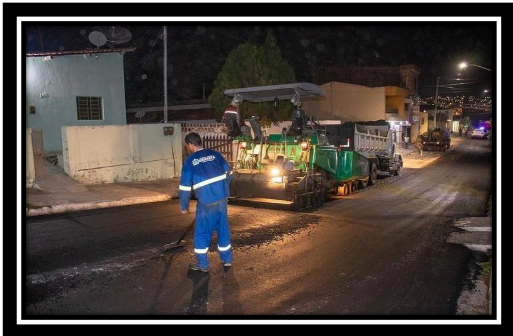
Foto 85 – Aplicação da camada de BINDER e CBU'q (Rua Naturalista Farias Neves, Novo)
