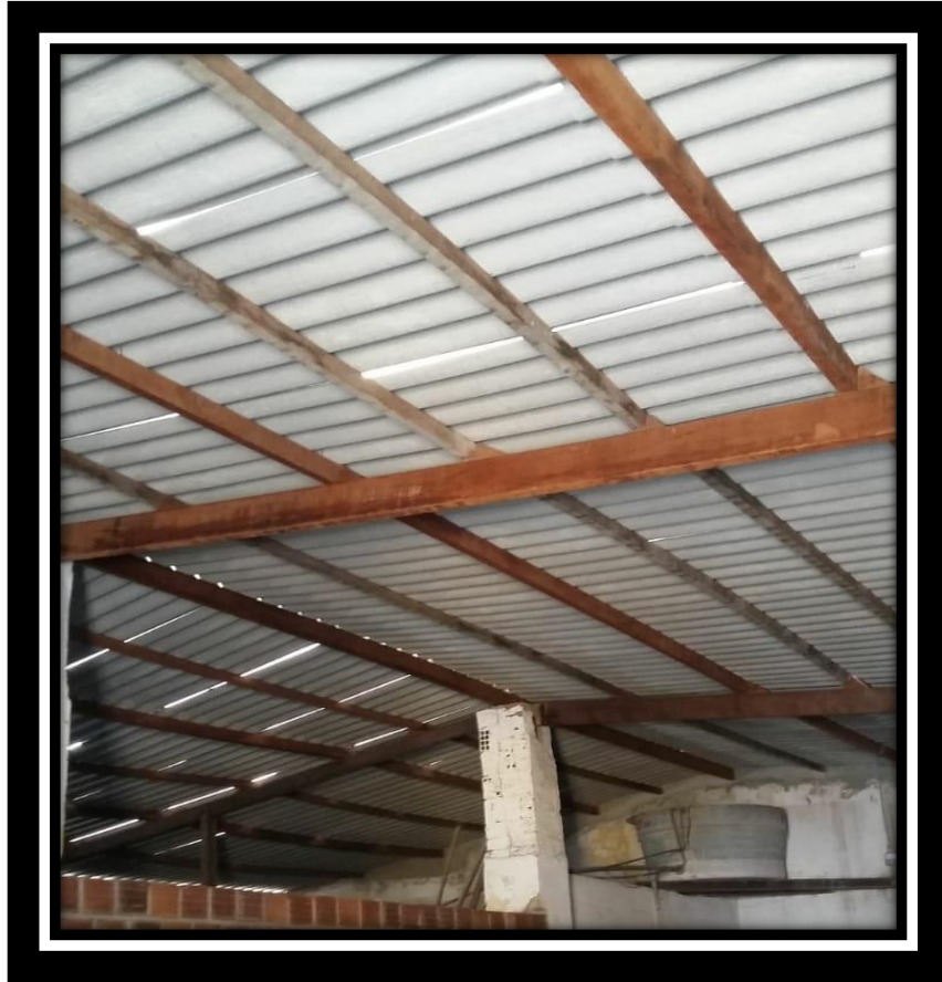
Foto 82 - Coberta do depósito
