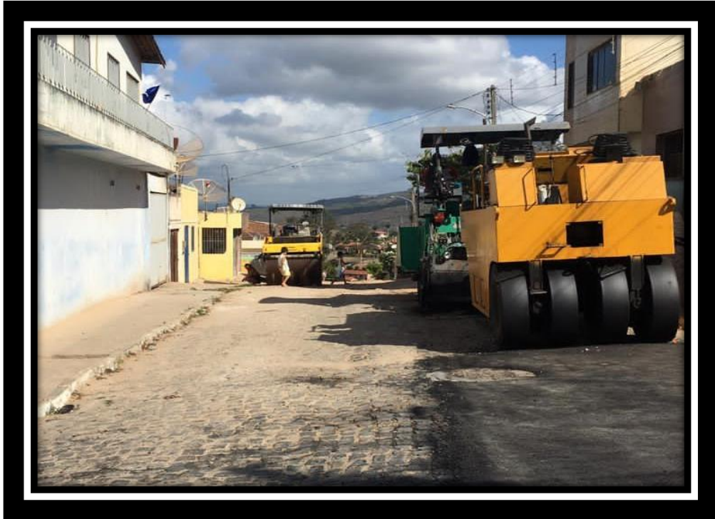
Foto 90 – Execução da camada de BINDER (Rua Conselheiro Jasmelino Correa de Lima, Novo)
