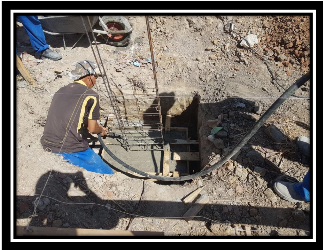
Foto 37 – Concretagem de sapata (Creche, Alpes)
