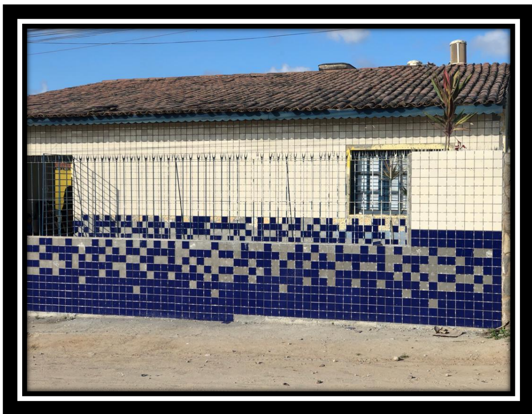
Foto 13 – Execução de revestimento cerâmico (Área Verde I e II)
