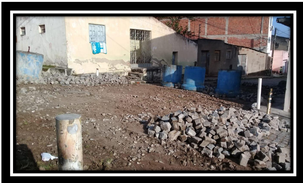
Foto 73 – Escavação para assentamento de pavimento em paralelepípedo. (Rua do Sapateiro – Boa Vista)
