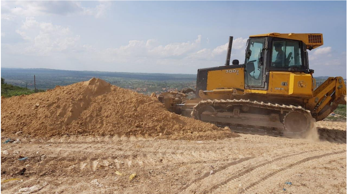
FOTO 30- Imagem do melhoramento das vias do aterro sanitário.
