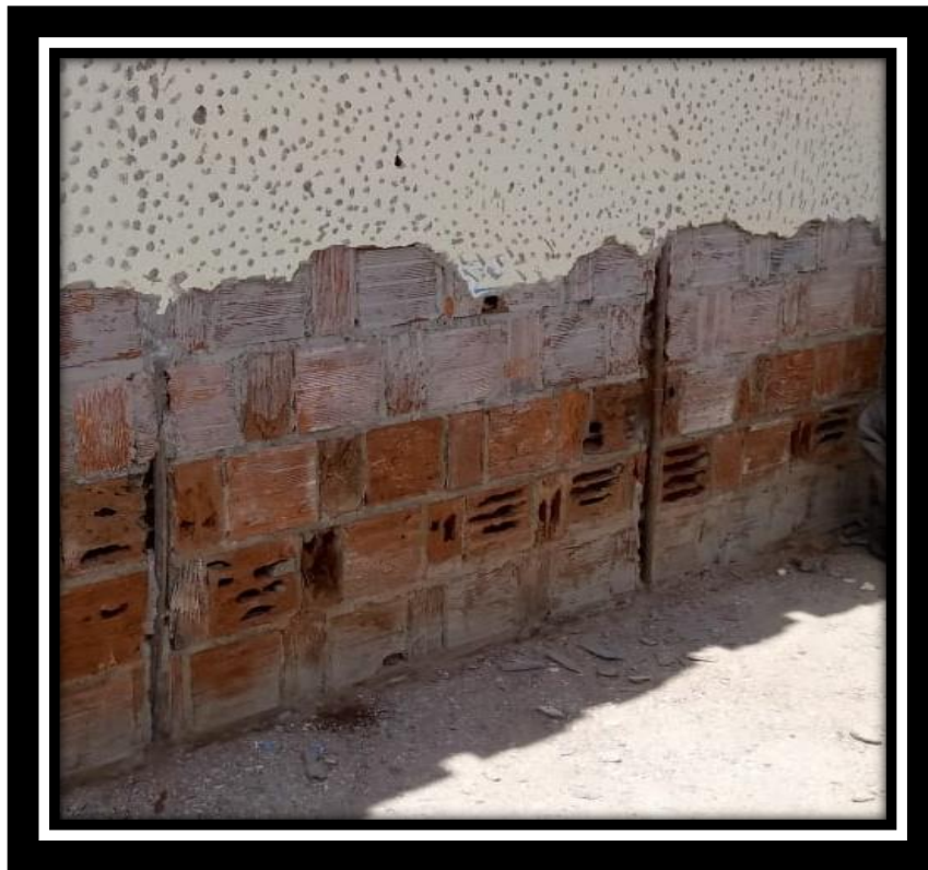
Foto 25 - Demolição do chapisco e emboço (São Severino)
