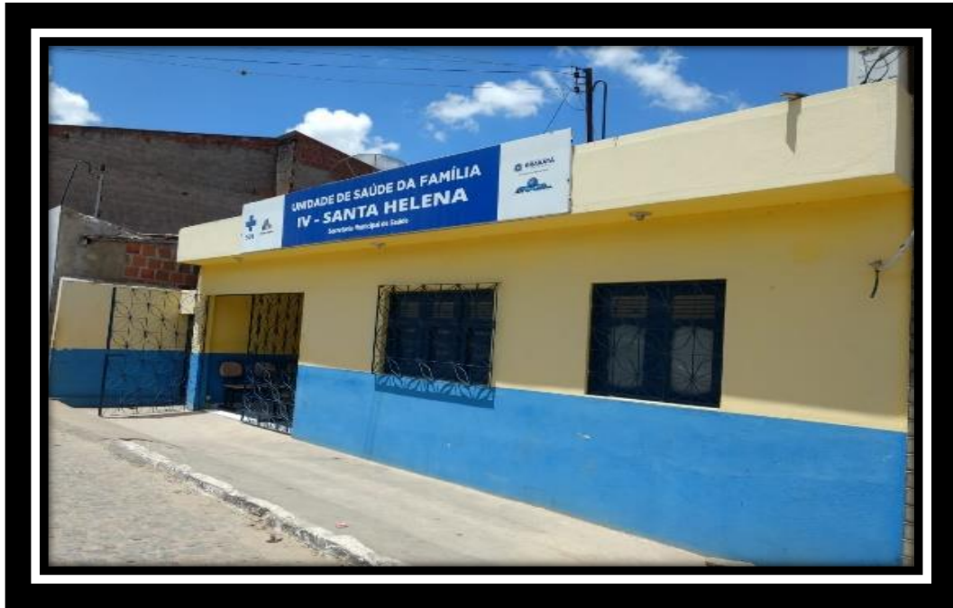
Foto 11 – Fachada (Posto IV)
