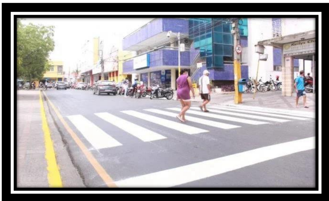
Foto 87 – Sinalização asfáltica com material termoplástico (Rua Rui Barbosa, Centro)
