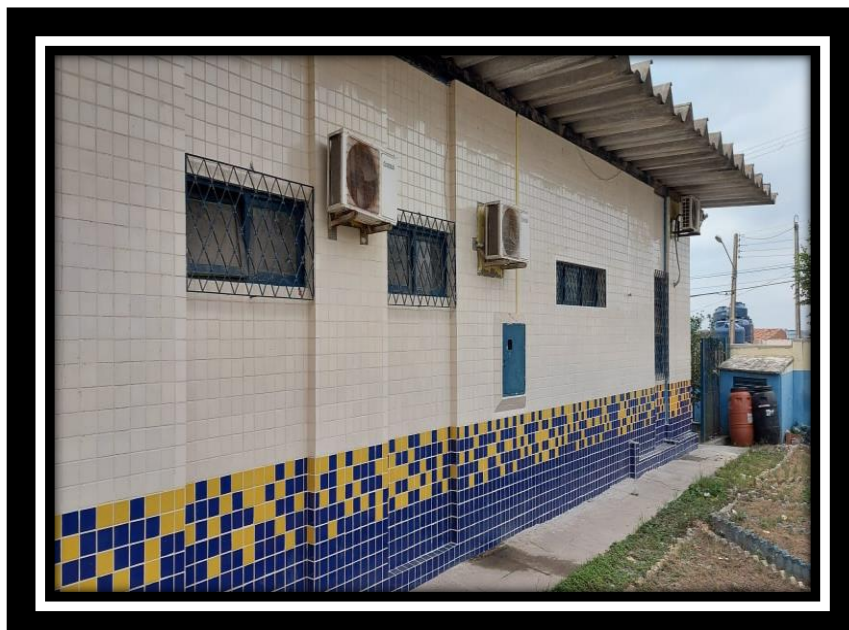
Foto 15 – Execução de revestimento cerâmico (Cruzeiro II)
