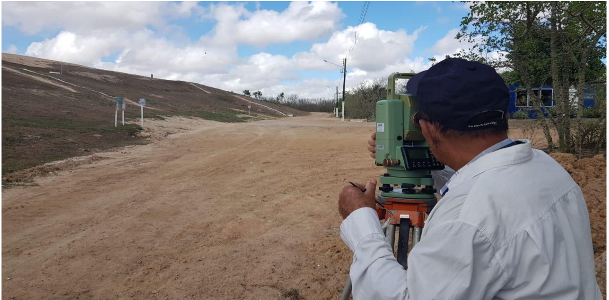
FOTO 22- Imagem detalha o levantamento do monitoramento geotécnico.
