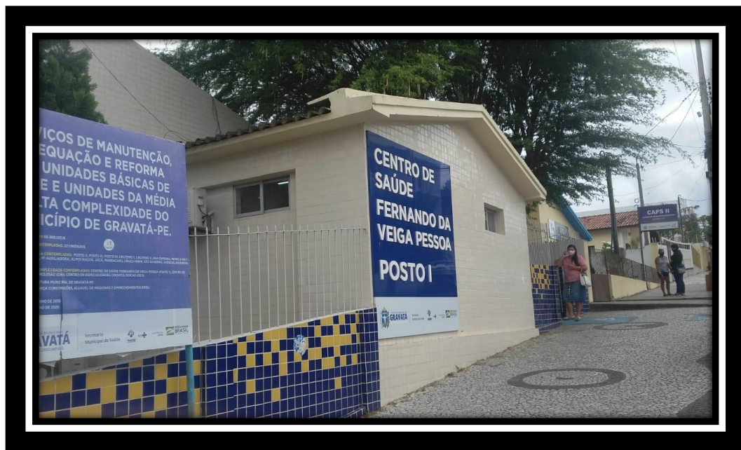
Foto 6 – Fachada (Posto I)
