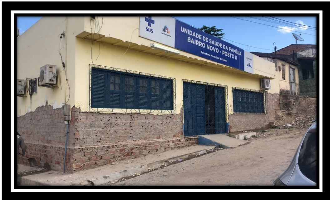
Foto 8 - Demolição de reboco (Posto II)
