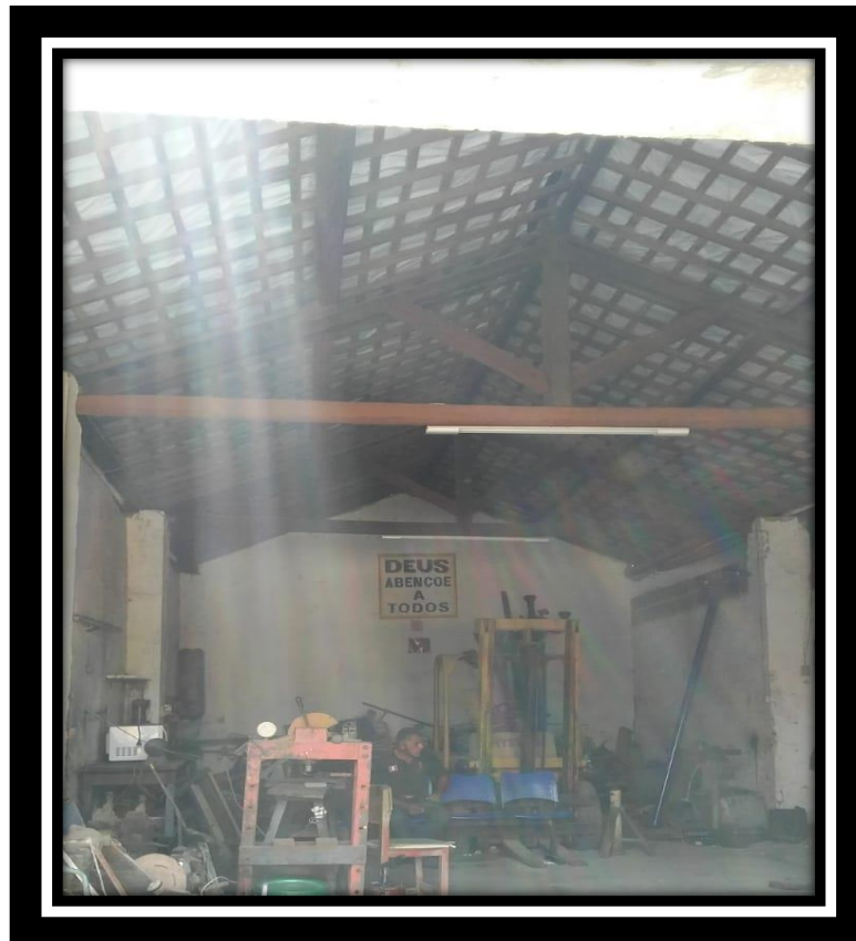
Foto 81 - Coberta da oficina
