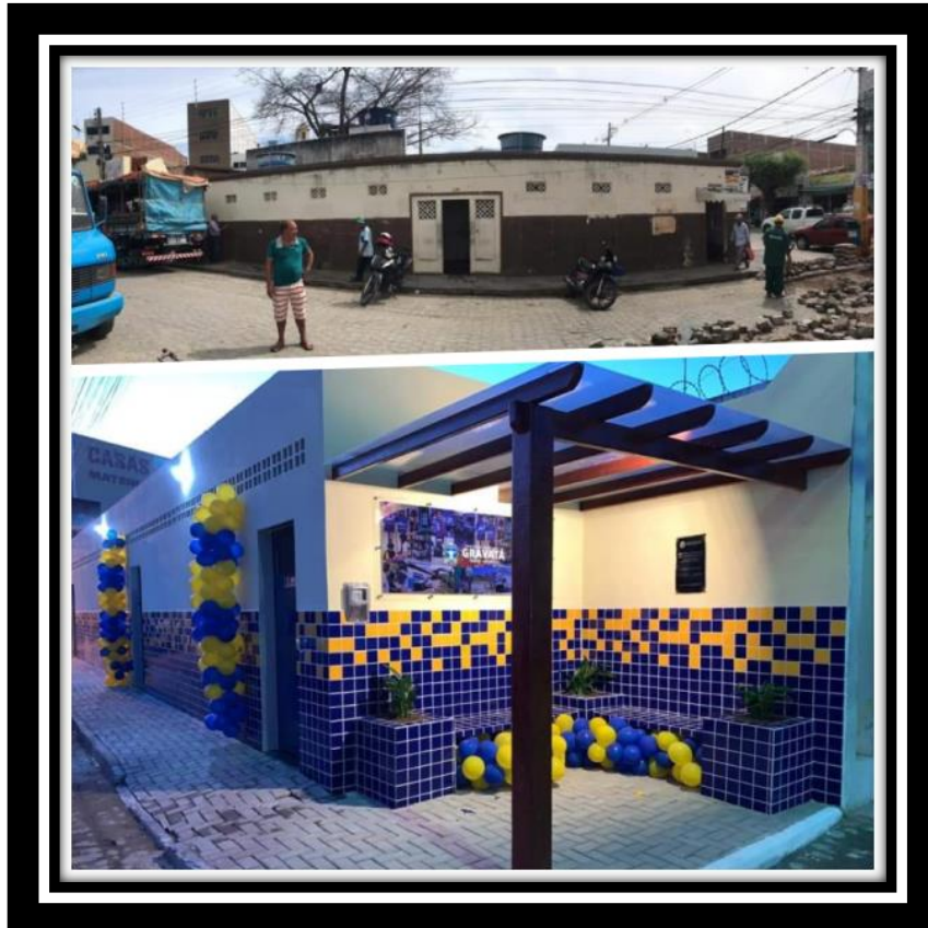
Foto 76 – Antes e depois do banheiro público municipal, lote 01
