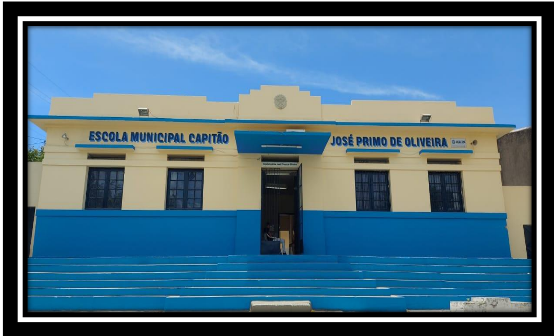
Foto 54 - Acabamento de pintura externa na fachada (Escola Capitão José Primo)
