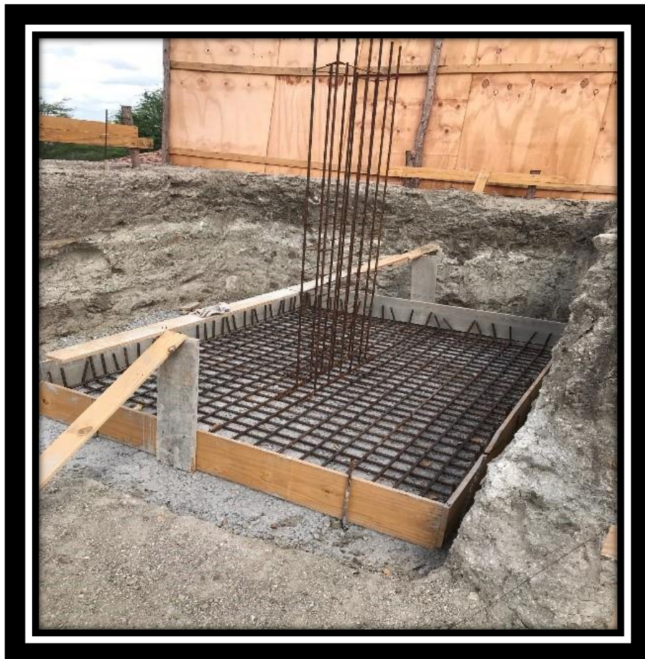
Foto 41 – Sapada concretada, com forma e armação de aço (Quadra, Avencas)
