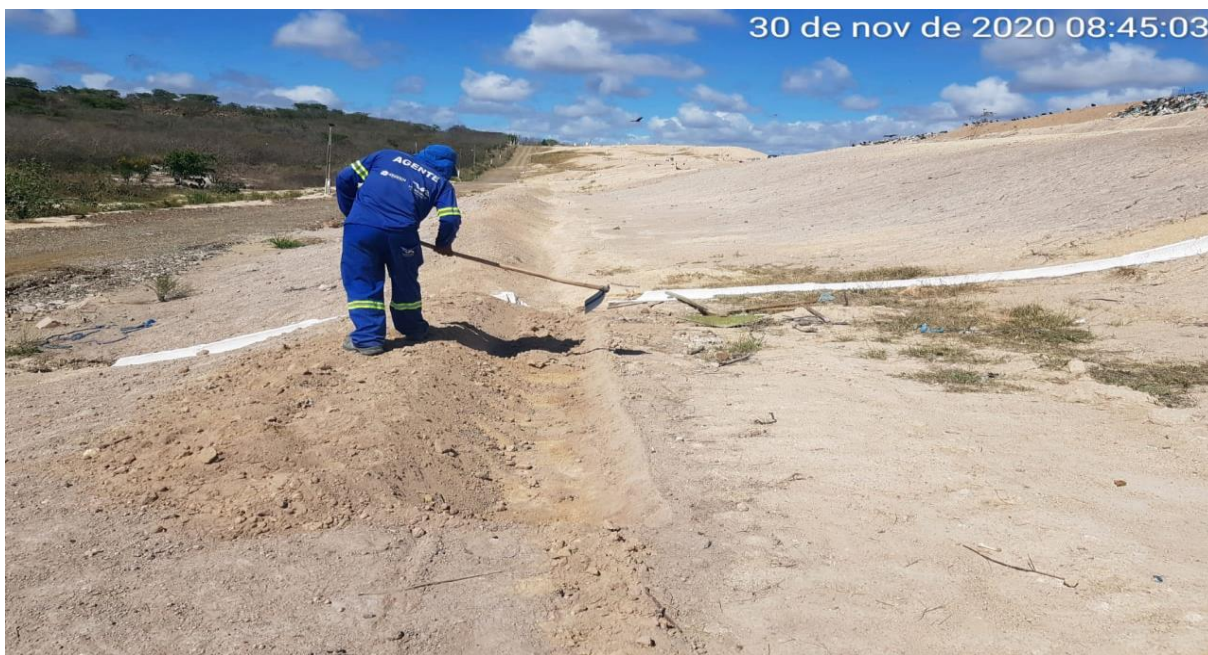
FOTO 12- Imagem detalha a manutenção dos taludes do processo erosivo.
