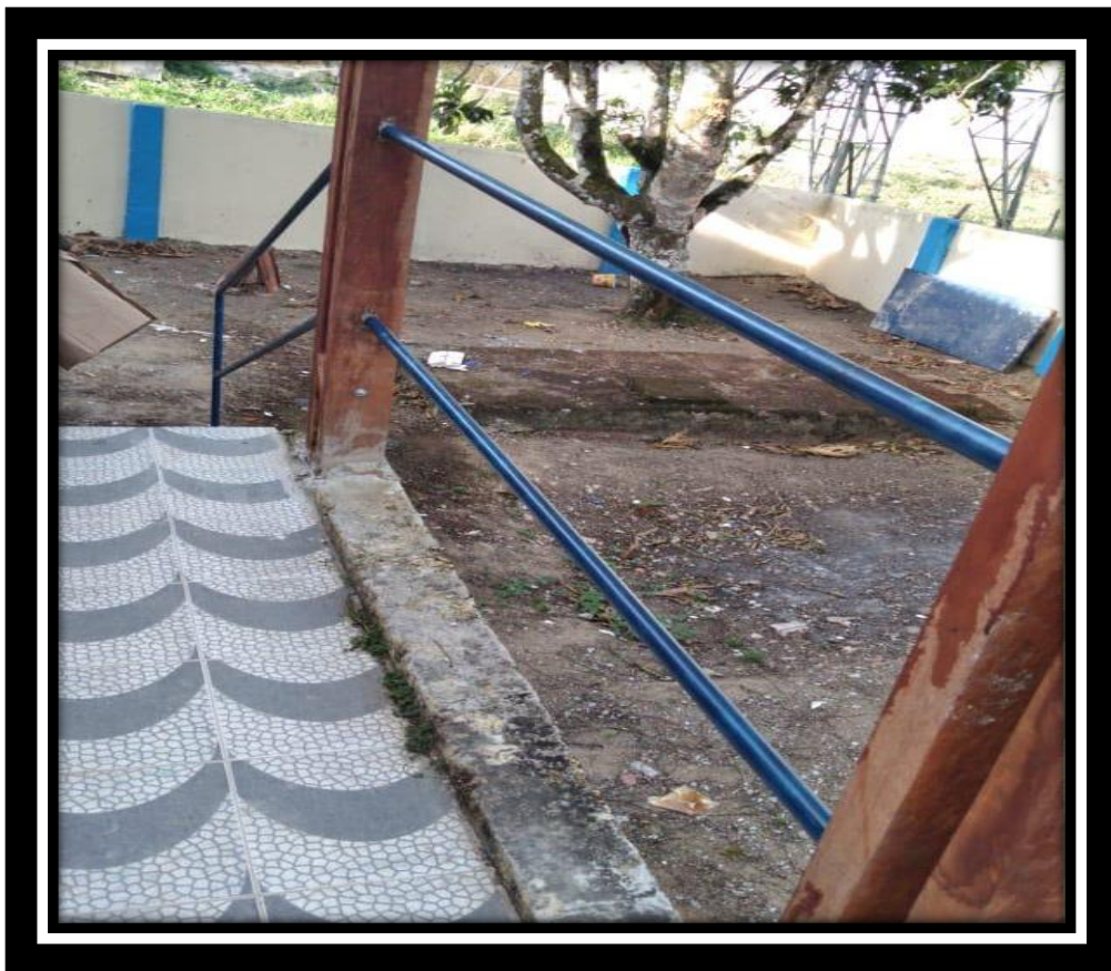
Foto 30 – Execução do guarda-corpo (Uruçu)
