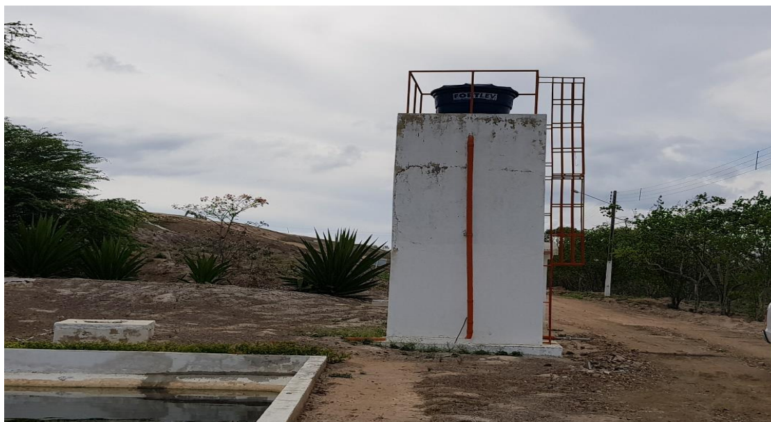
FOTO 4- Imagem do reator anaeróbio da ETE.
