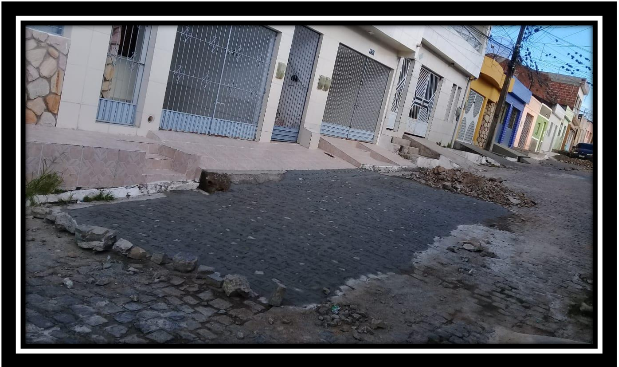
Foto 74 – Execução do pavimento em paralelepípedo. (Rua Visconde de Cairu - Norte)
