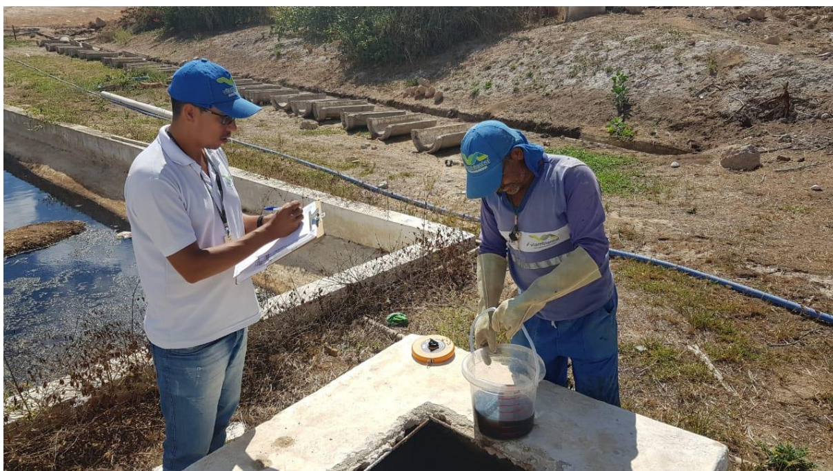
FOTO 17- Imagem controle de vazão de chorume.
