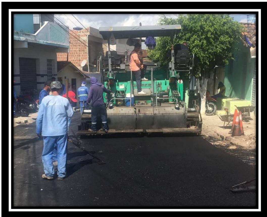
Foto 89 – Execução da camada de BINDER (Rua Alto do Quirino, Novo)
