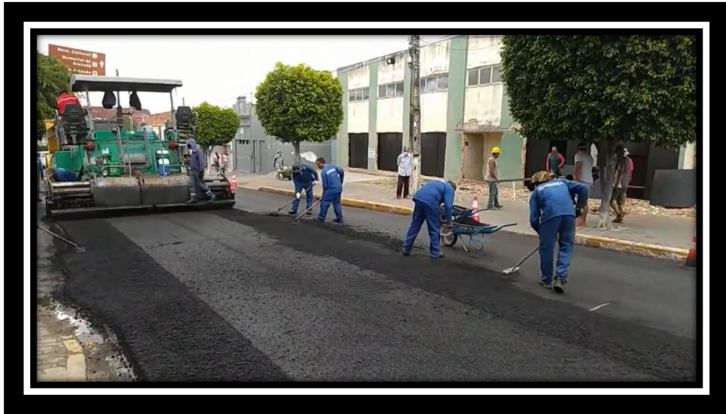
Foto 84 – Aplicação da camada de BINDER e CBU'q (Av. Agamenon Magalhães, Prado)
