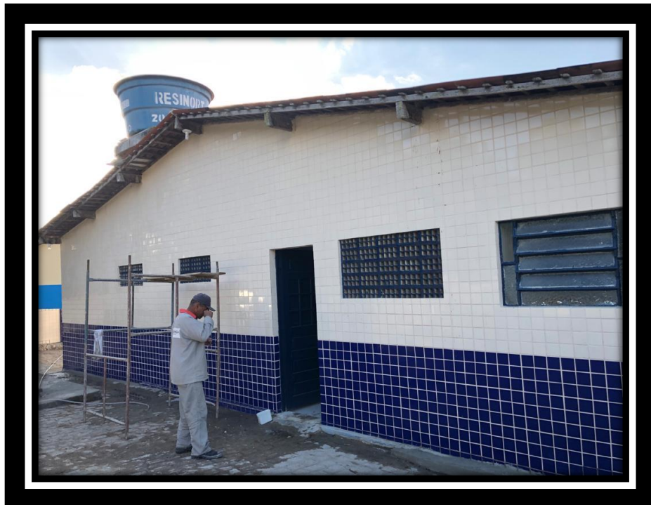
Foto 22 – Revestimento cerâmico na fachada posterior (Mandacaru)
