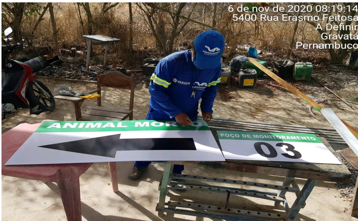
FOTO 33- Imagem da implantação da nova sinalização do aterro sanitário.
