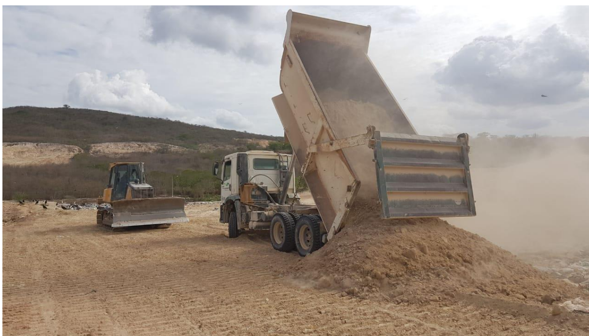
FOTO 21- Imagem detalha o lançamento de material da jazida para a cobertura da frente de operação.
