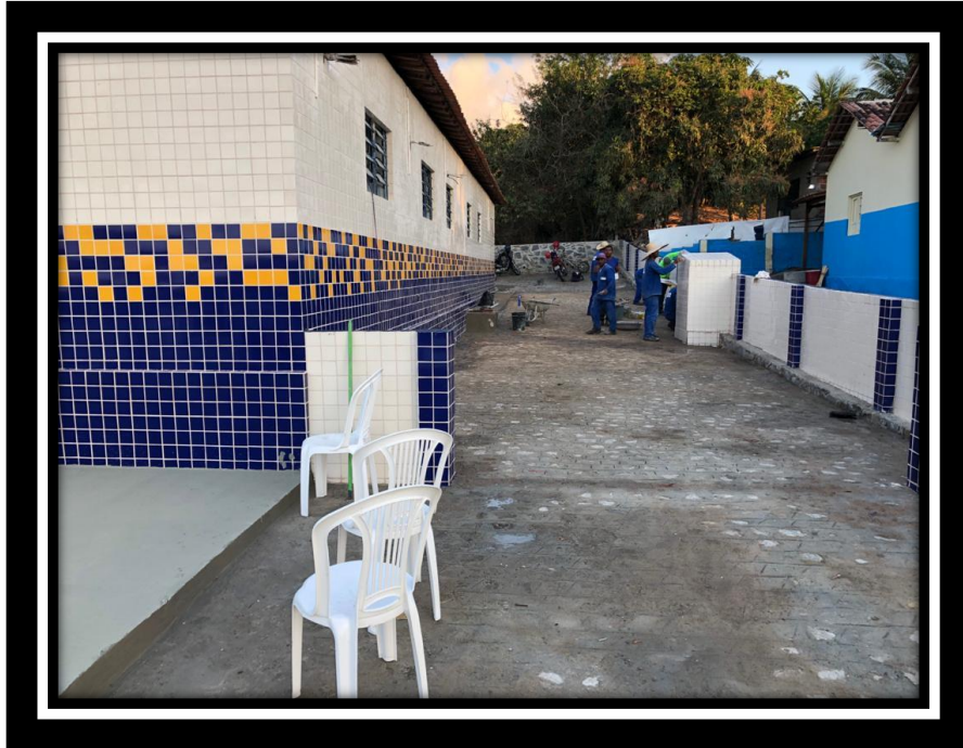
Foto 23 – Revestimento cerâmico: Fachada lat. direita, Muro lat. direita e Casa da bomba (Mandacaru)
