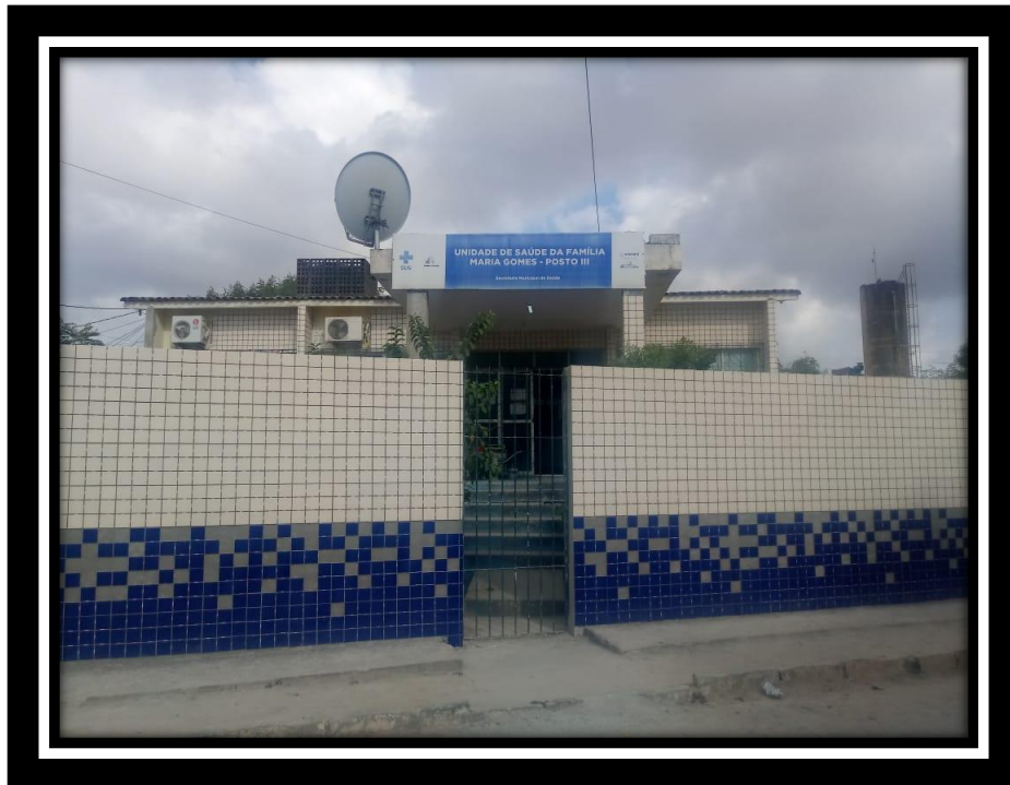
Foto 10 – Execução de revestimento cerâmico (Posto III)
