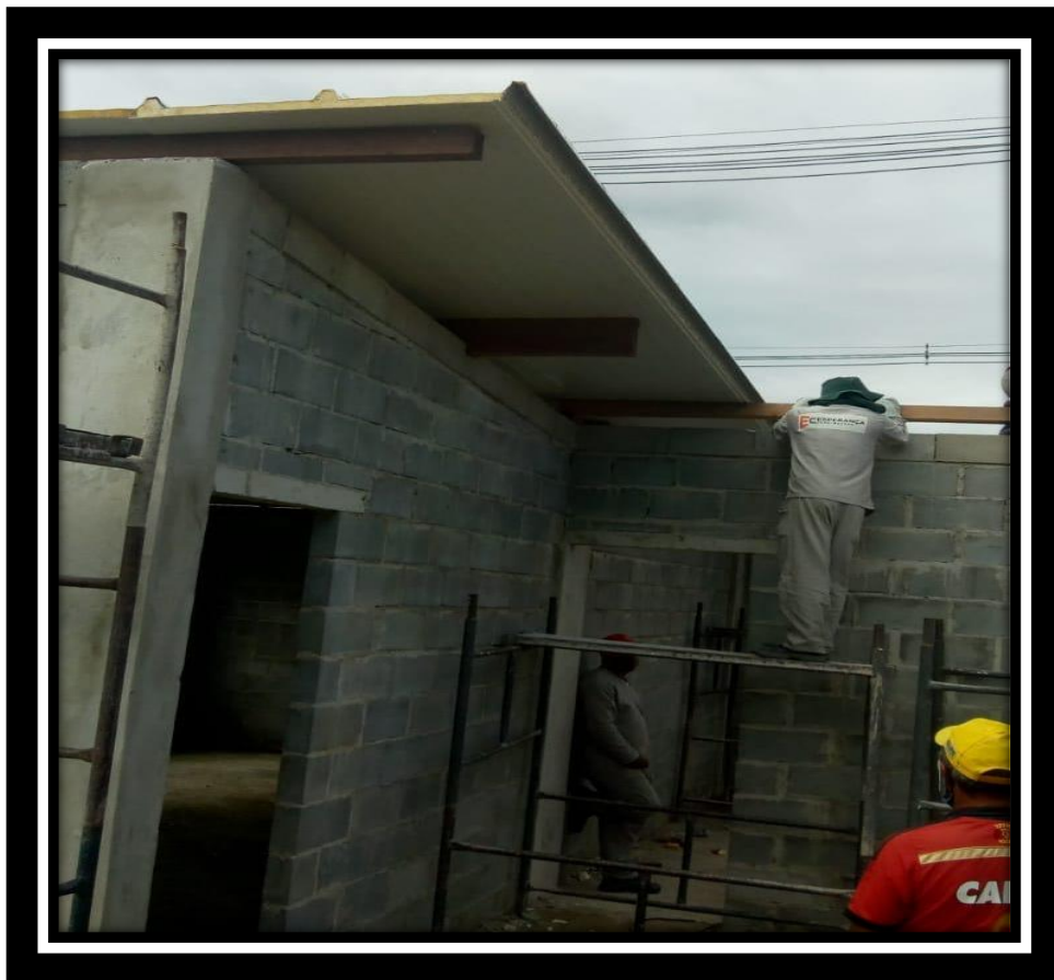
Foto 63- Execução da cobertura (Escola Jesus Pequenino)
