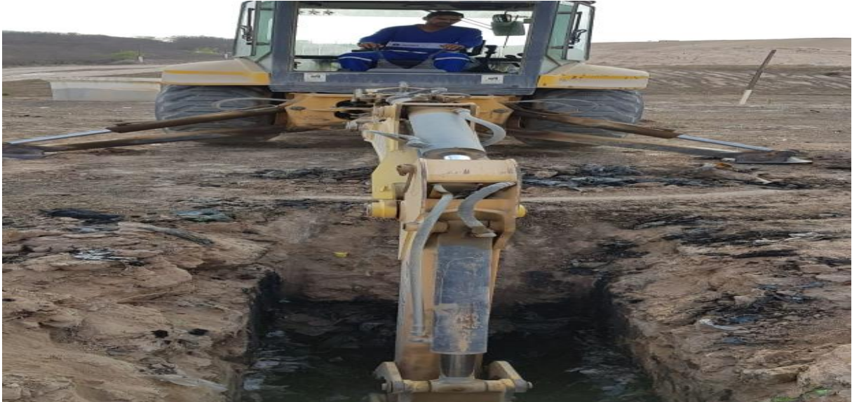
FOTO 18- Imagem detalha a escavação para implantação do dreno horizontal.
