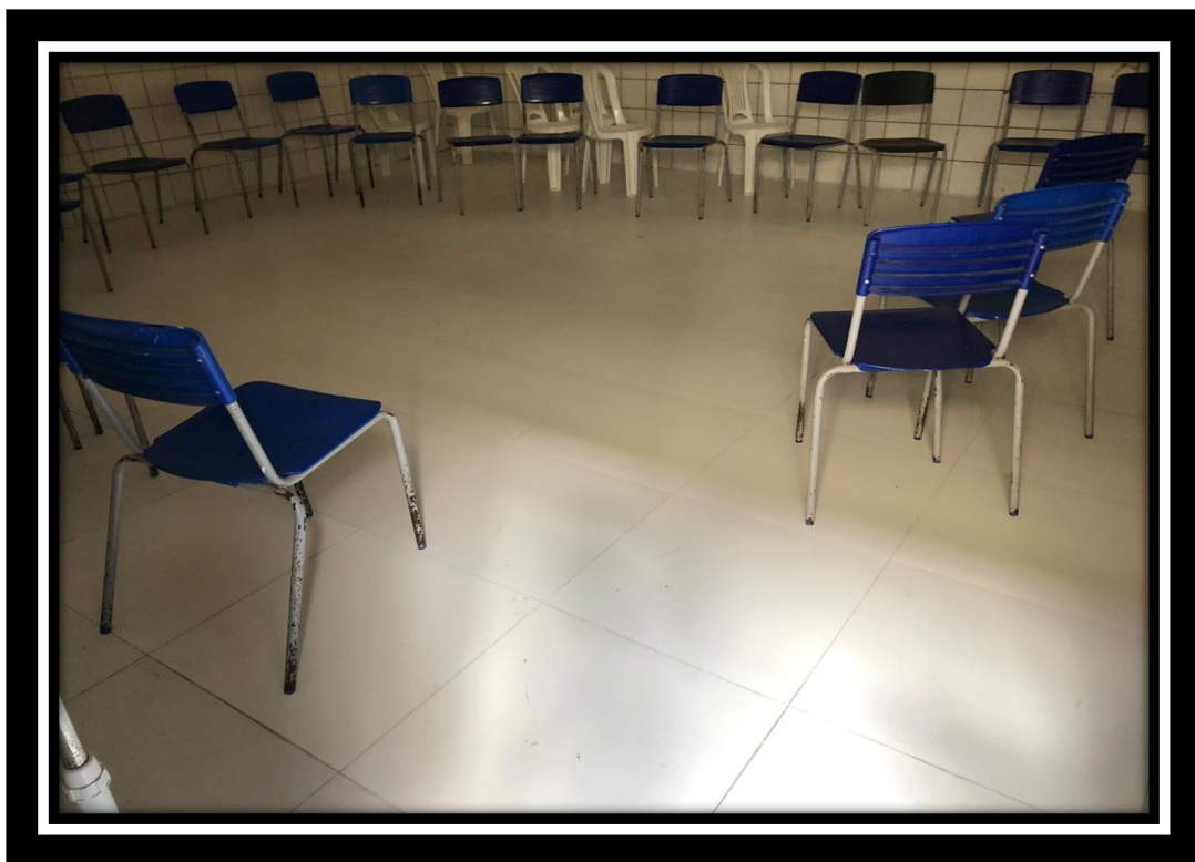
Foto 55 - Sala aula com revestimento em porcelanato (Escola Capitão José Primo)
