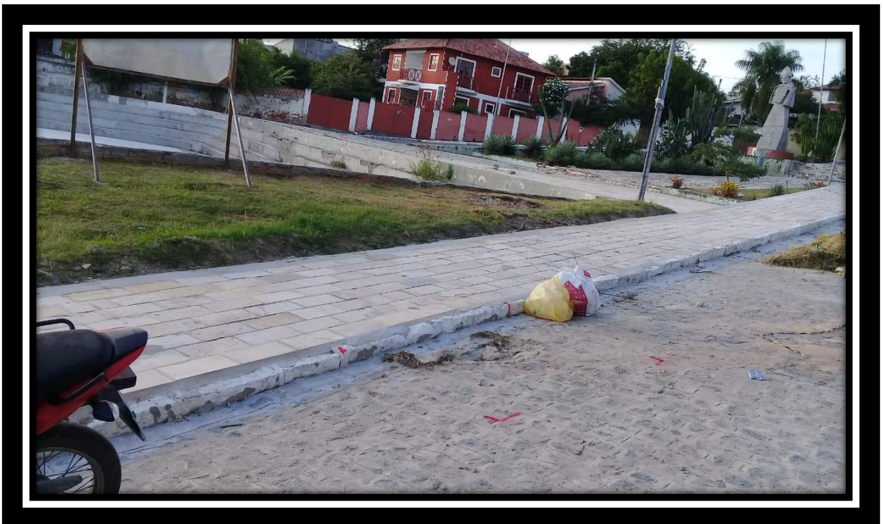
Foto 75 – Execução de sistema de drenagem (meio-fio). (Rua Felinto Farias de Castro – Centro)
