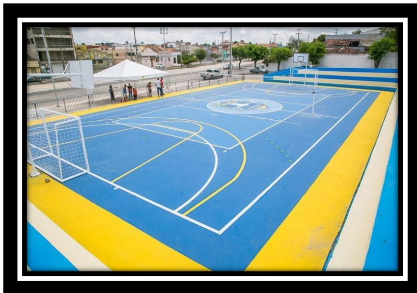
Foto 92 - Quadra finalizada com aplicação de tinta à base de epóxi sobre piso com marcação de quadra poliesportiva futebol, basquete e vôlei
