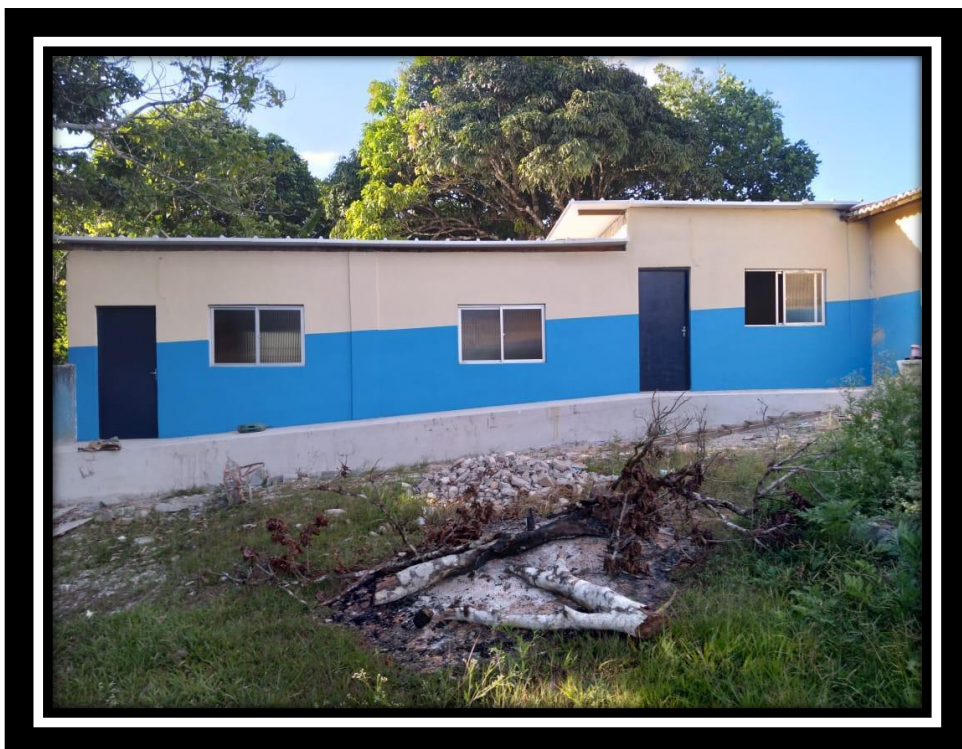
Foto 62 - Pintura e acabamento da alvenaria e esquadrias (Escola Dom Ricardo)
