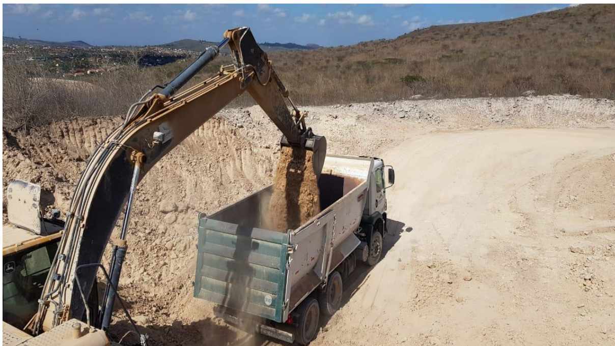
FOTO 28- Imagem do carregamento da argila para a frente de operação.
