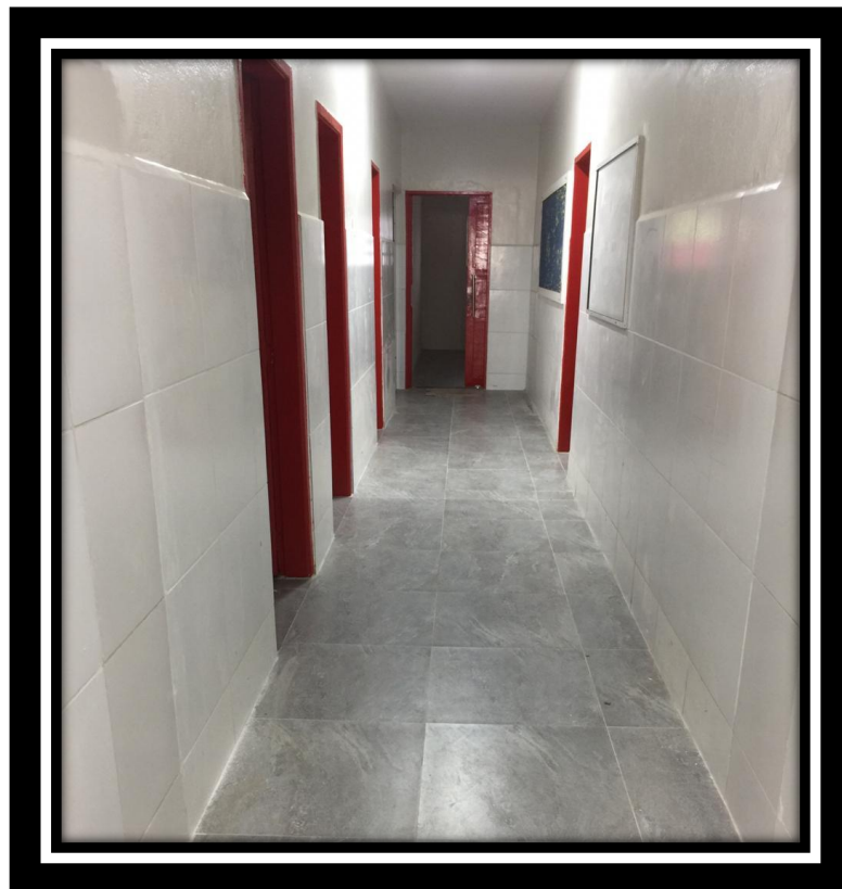
Foto 35 – Revestimento cerâmico tipo porcelanato (SAMU)
