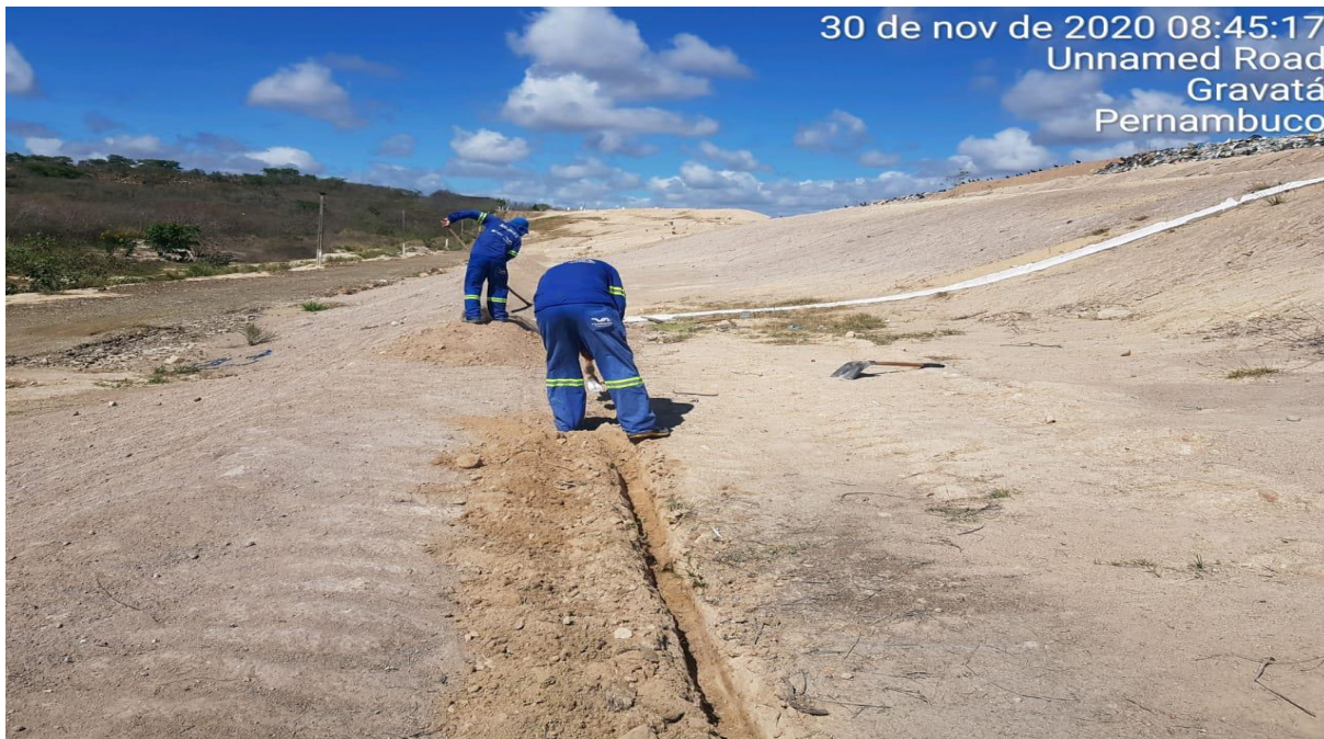
FOTO 11- Imagem detalha da drenagem horizontal nos taludes em contenção do processo erosivo.
