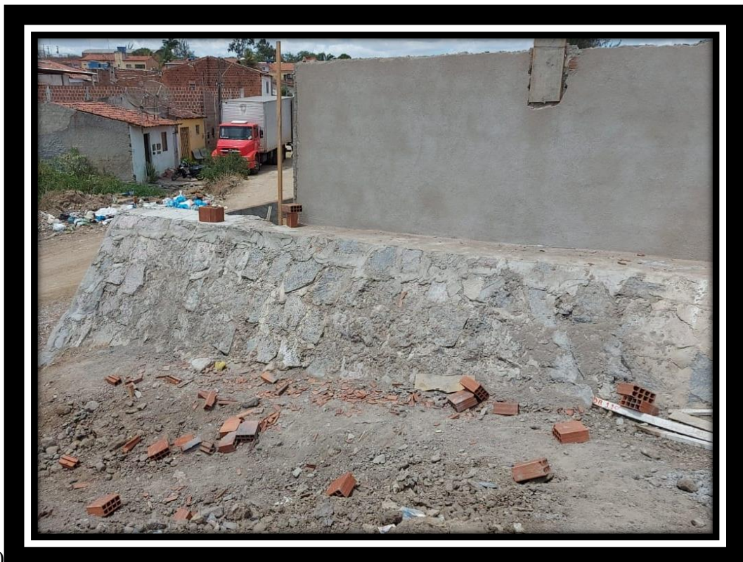
Foto 36 – Muro de arrimo (Creche, Alpes)
