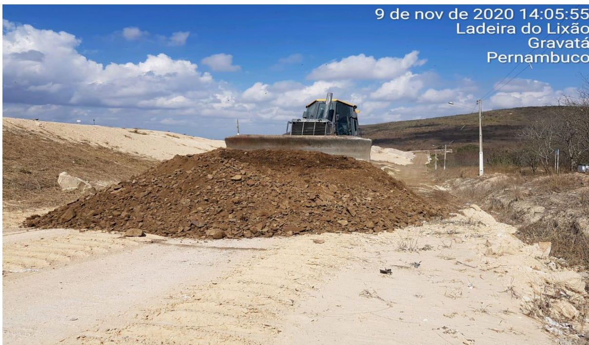
FOTO 32- Imagem da implantação do sistema viário interno do aterro sanitário.
