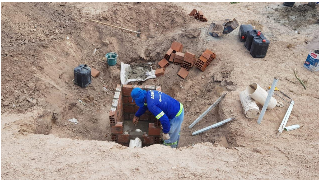
FOTO 34- Imagem da construção da caixa de inspeção de chorume da nova célula.
