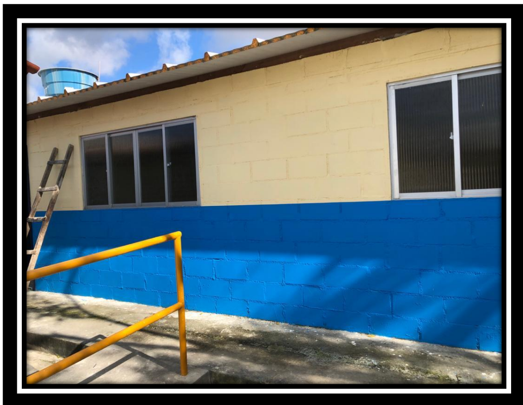
Foto 66 – Execução de Pintura (Escola Maria Alice)
