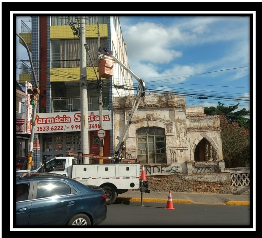
Foto 69 – Empresa realizando a instalação
