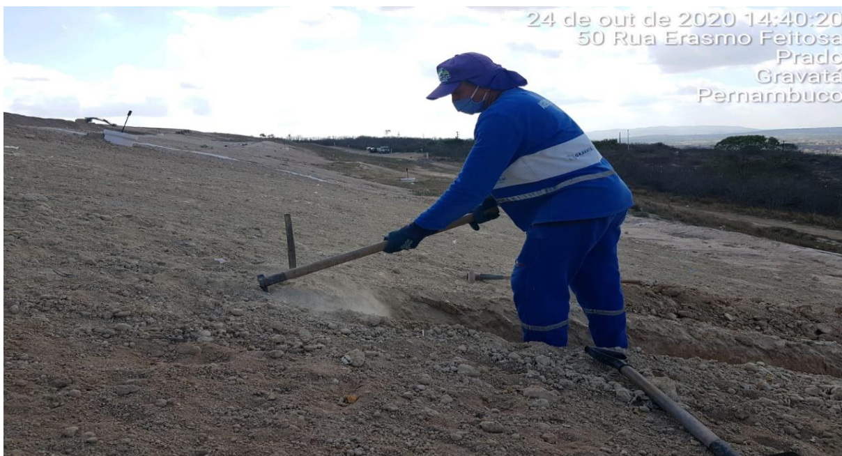
FOTO 13- Imagem do dreno de águas pluviais sendo construído.
