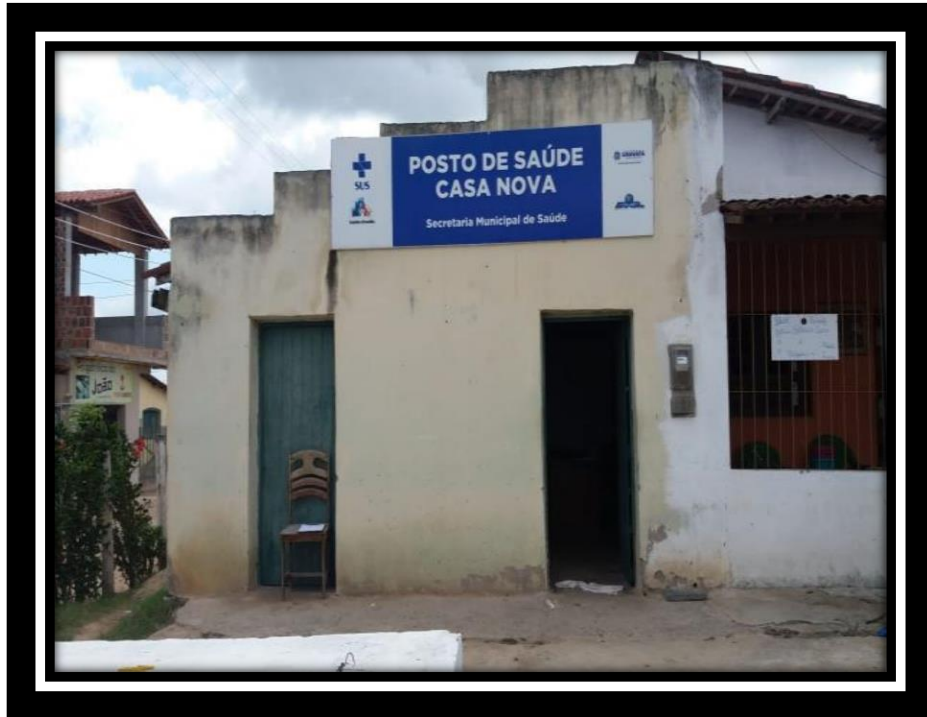
Foto 26 – Fachada (Casa Nova)
