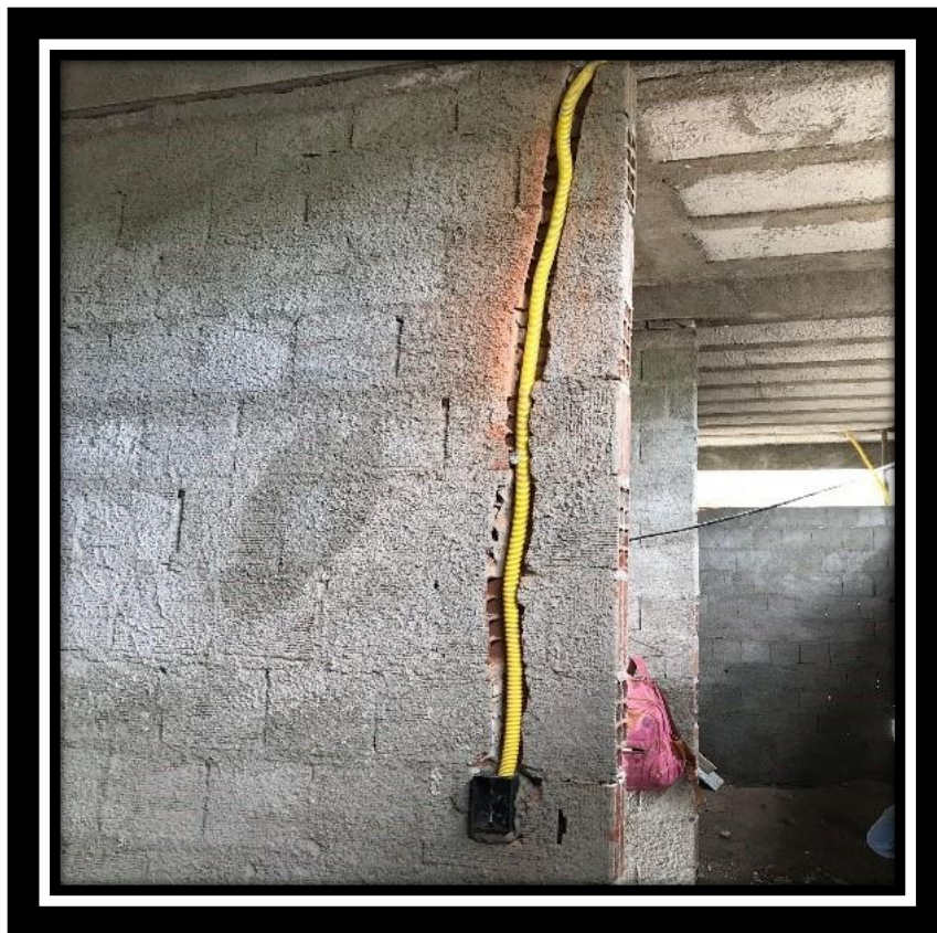
Foto 47 - Instalações elétricas em andamento (Quadra, Mandacaru)
