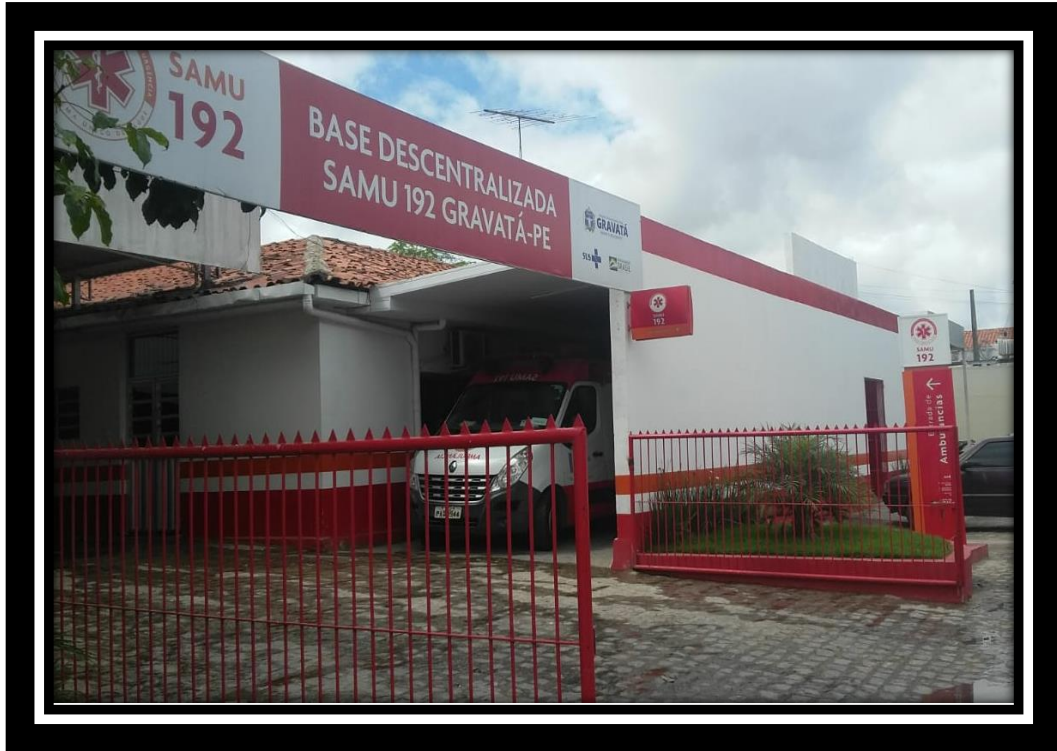
Foto 33 – Muro frontal – Portão (SAMU)
