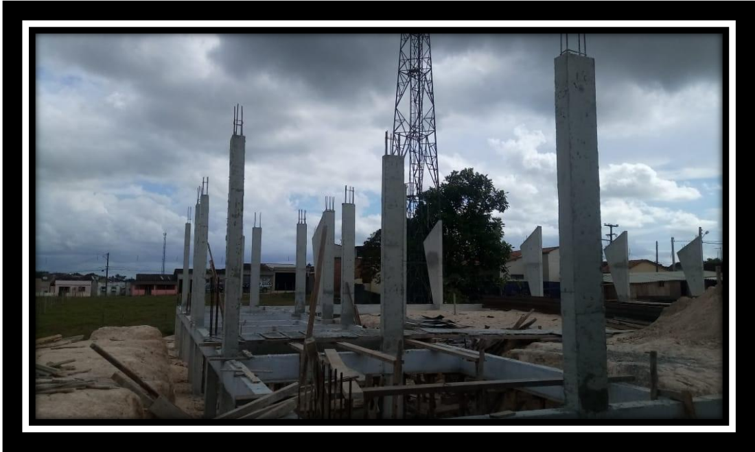
Foto 46 - Pilares e vigas baldramas do vestiário concretadas (Quadra, Uruçu)
