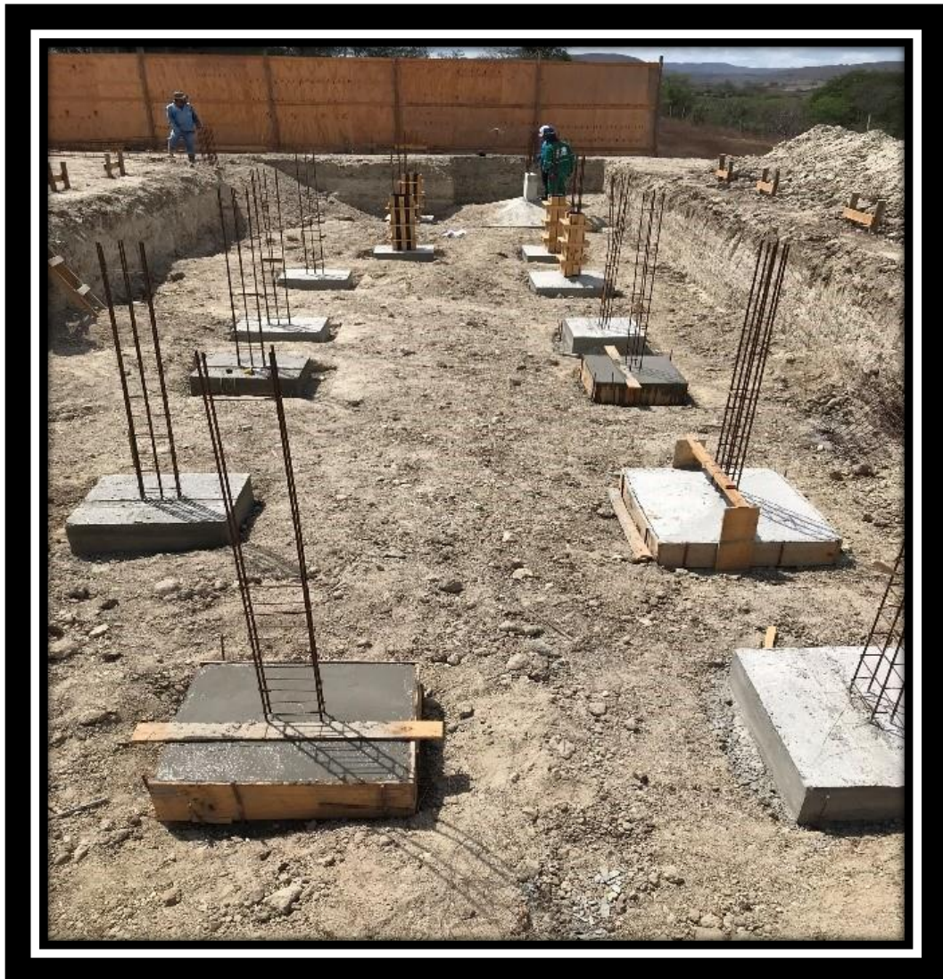
Foto 42 - Execução de forma para pescoço e fixação de colunas de aço de arranque (Quadra, Avencas)
