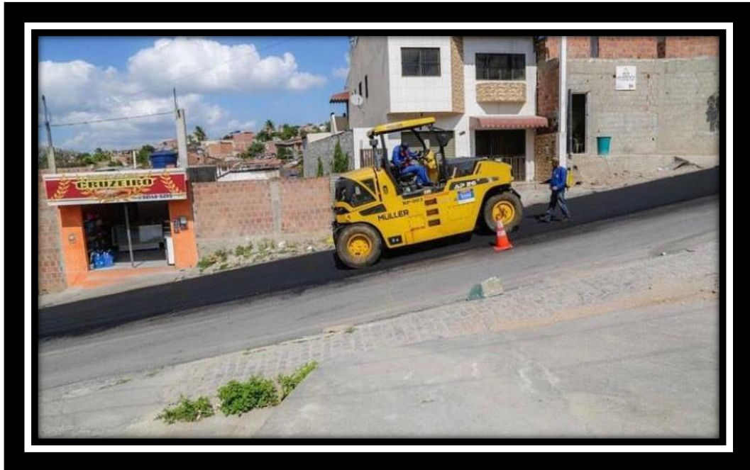
Foto 86 – Aplicação da camada de BINDER e CBU'q (Rua do Cruzeiro, Cruzeiro)
