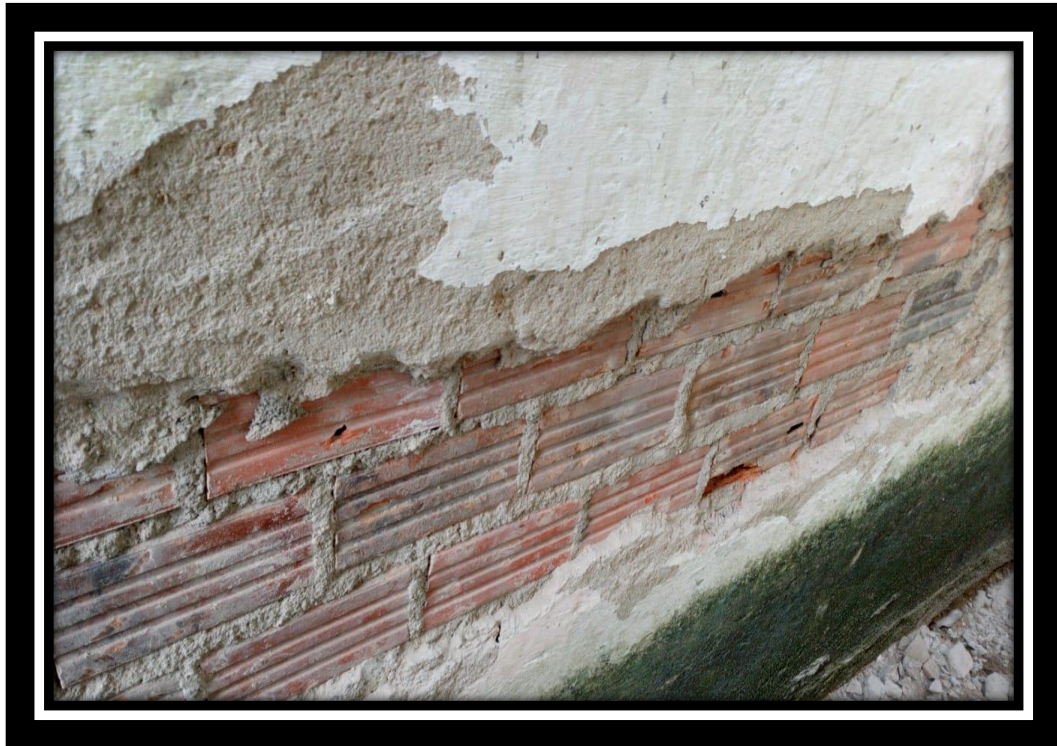
Foto 20 – Demolição do revestimento (Avencas)
