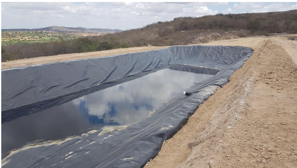
FOTO 35- Imagem da nova lagoa de acumulação de chorume capacidade de 1680m 3 .
