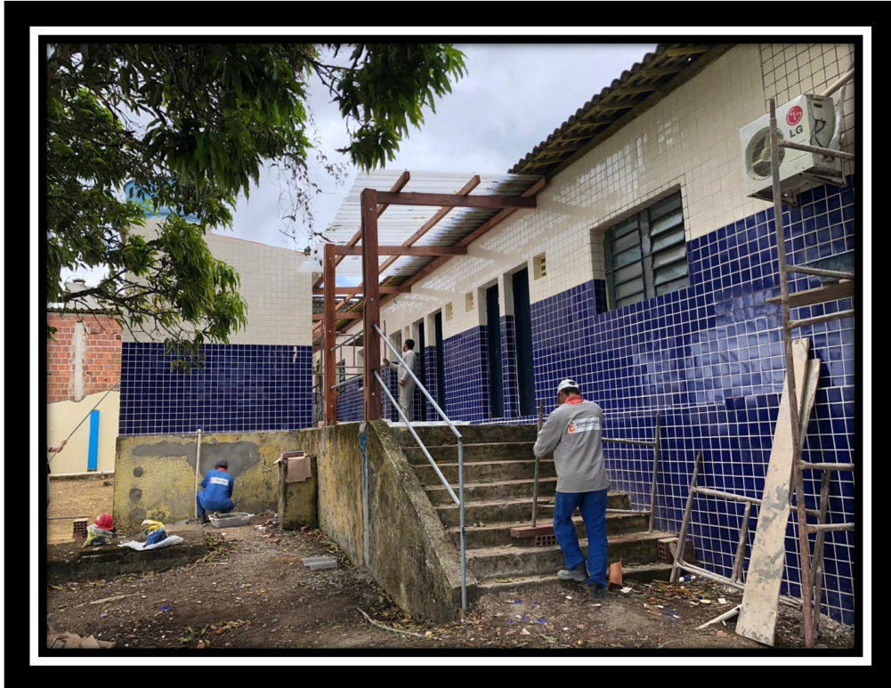
Foto 29 – Execução de cobertura em telha translúcida (Uruçu)
